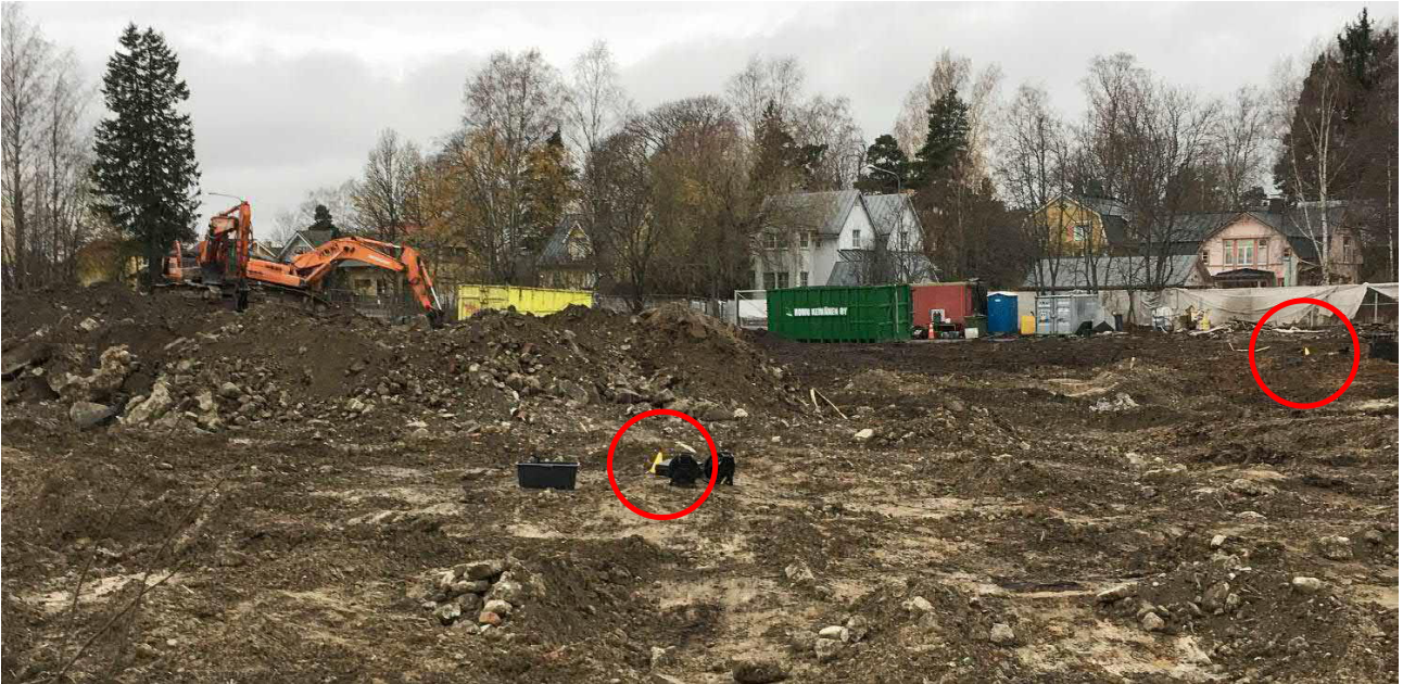
Mittauspisteet 6 ja 7. Sijainti purkutyömaan tontin keskiosassa. Anturien kiinnitys maaruuvilla.
