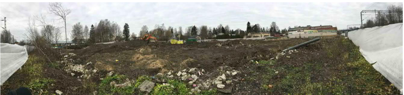
Panoramakuva purkutyömaa-alueen eteläpäädyistä pohjoiseen.
