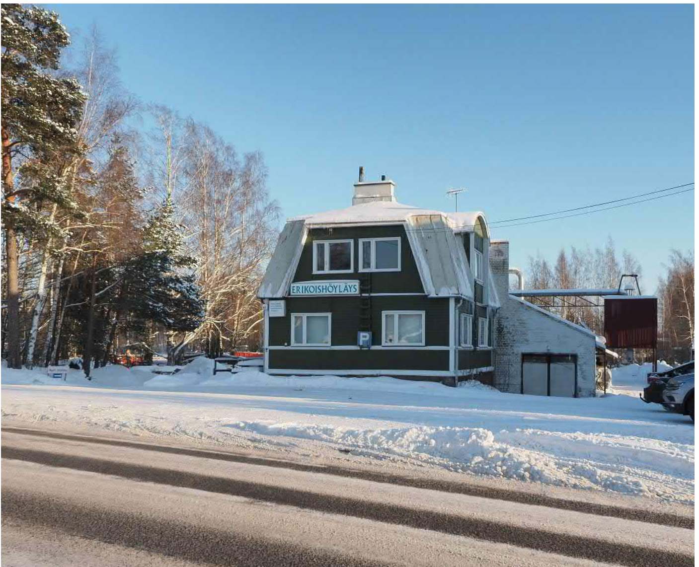
Näkymä Vanhalta Tapanilantien ja Malmin kauppaticien risteuksesta.
