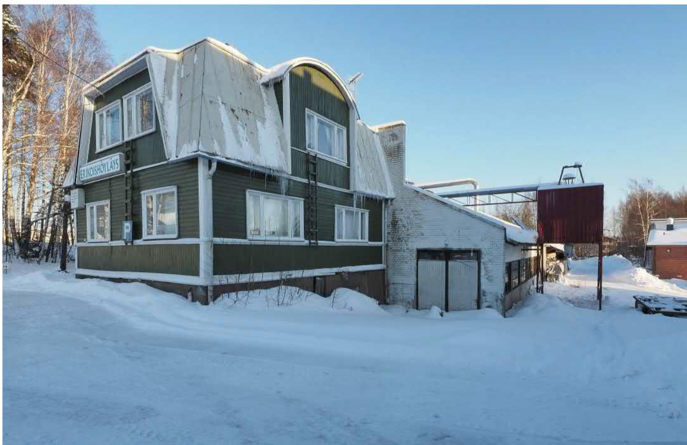
Rakennus kuvattuna lännestä
