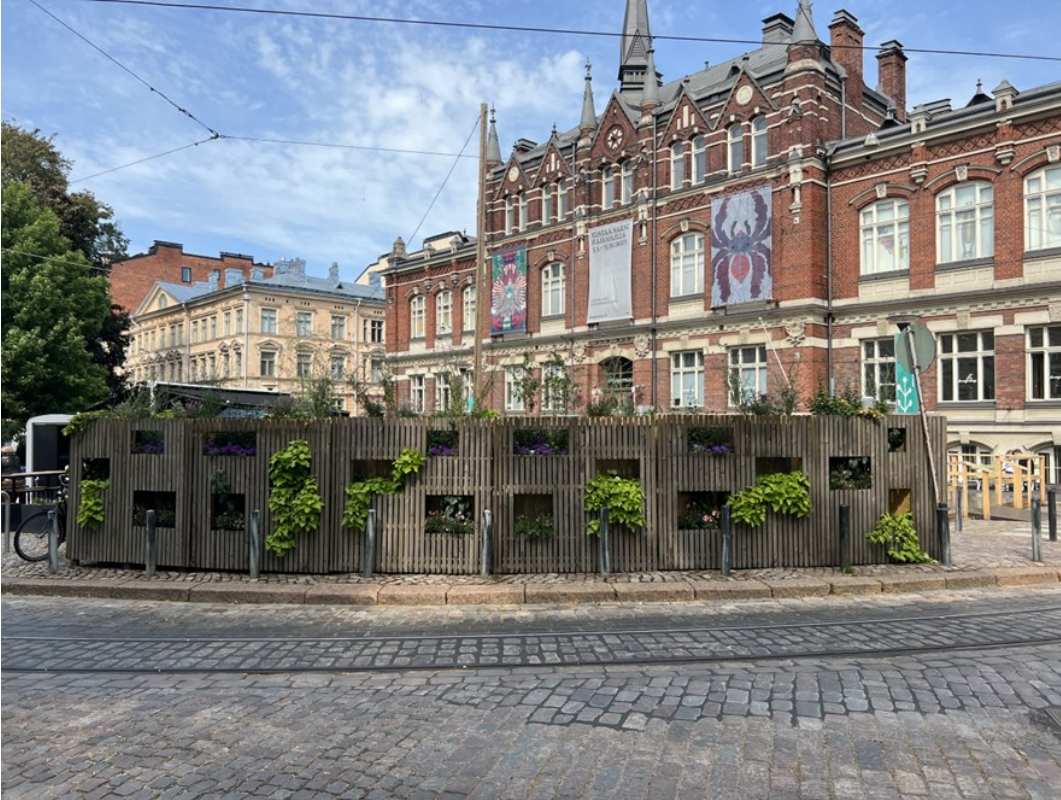
Wau Efekti Oy:n toteuttama meluseinäke Yrjönkadun suunnasta kuvattuna heinäkuussa 2023. Kuva Jenni Kuja-Aro.
