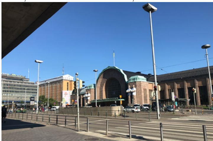
6. Näkymä eteläiselle sisäänkäynnille
