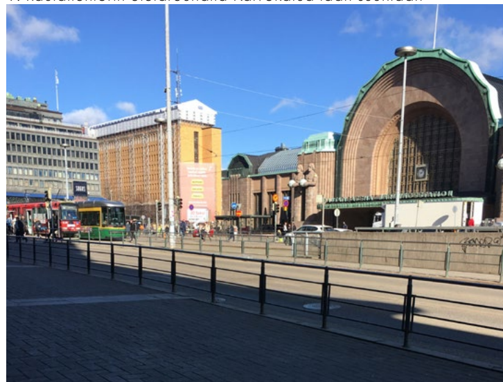
11. Kaivokadun kulmalta aseman eteläiselle sisäänkäynnille
