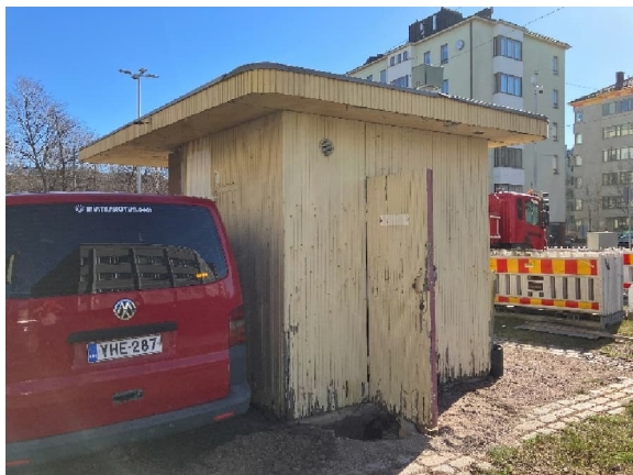
Takaosassa on puurakenteinen ovi.
