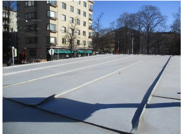
Yleiskuva kioskin vesikatolta.
