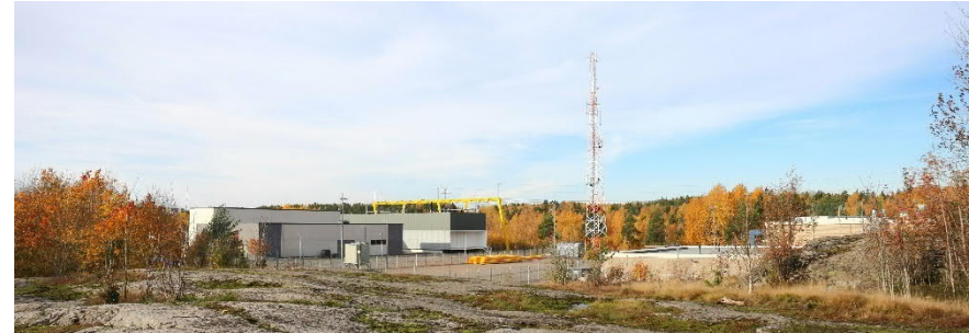
Kuva 39. Muuntamon rakennukset ja rakennelmat erottuvat selvästi maisemassa.
