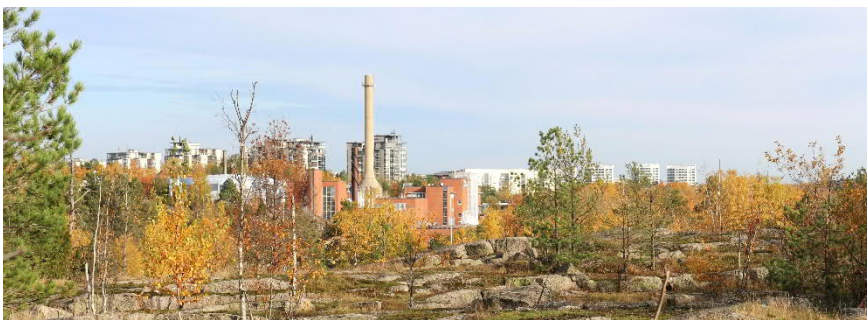
Kuva 57. Viikinmäen jätevedenpuhdistamon takana olevista Viikinmäen Kivitehtaankadun kerrostaloista sekä kuvassa takaoikealla olevista Pihlajamäen taloista näkyy useaan kohtaan selvitysalueelle.
