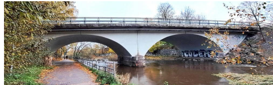
Kuva 35. Vantaanjoen ylittävä silta Kuninkaankartanonsaaren kohdalla.
