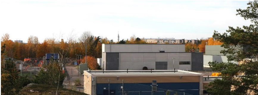
Kuva 56. Koskelan rakennuskantaa ja Pasilan linkkitorni näkyvät kaukomaisemassa Viikinkallion laen muuntamoalueen taustalla.
