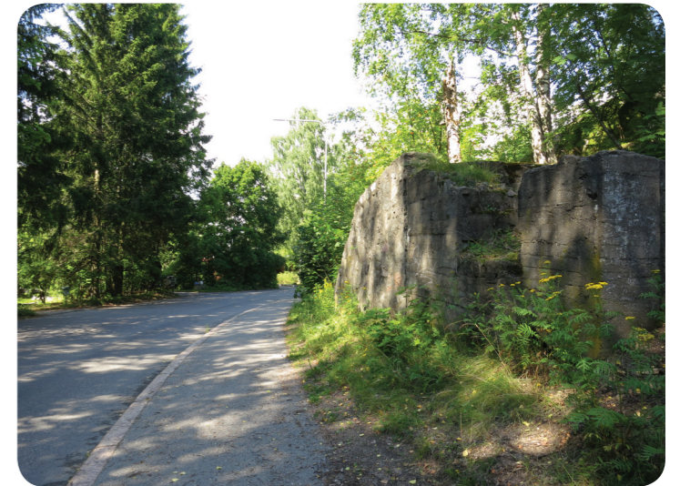
Kuva 5, alla. Näkymä Riskutien varrelta, jossa sijaitsee vanhoja linnoituslaitteita.
