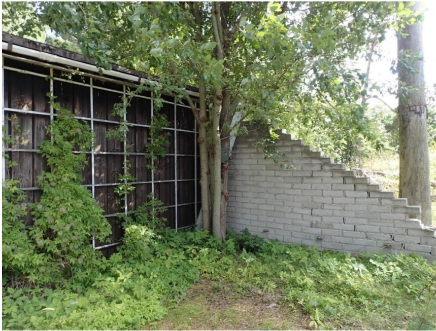
Kuva 23 Lepakkodetektori asennettiin puuhun ulkorakennuksen ja tiiliseinän kulmaukseen.
