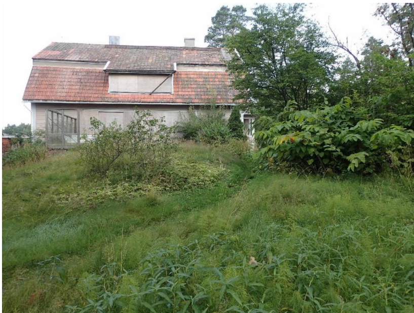
Kuva 15 Huvilan puutarhassa kasvaa useita pensaita ja nurmikko on muuttunut niityksi.
