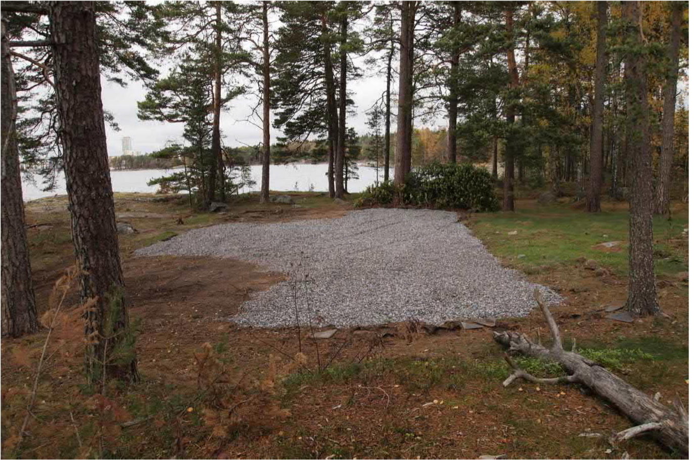
Nuottasaaresta puretun rakennuksen paikka, samalle kohdalle mahdollistetaan merellisten palveluiden rakentaminen
