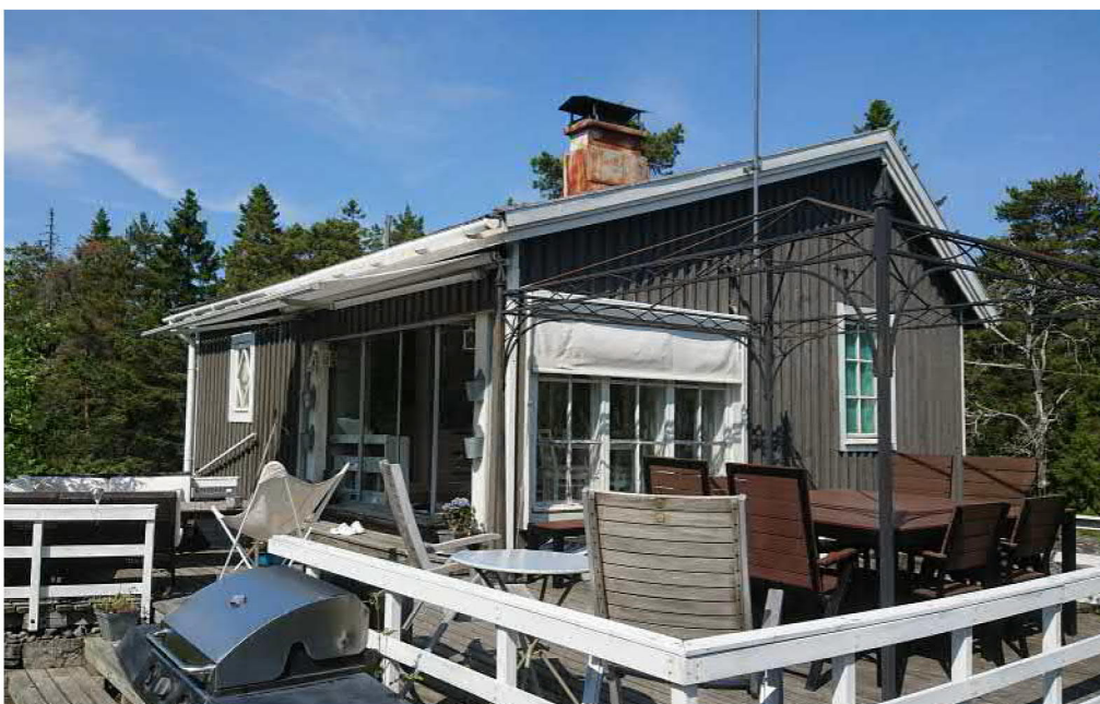
Villa Sandstrandin vierasmaja kesällä 2020, rakennus suojellaan merkinnällä sr-3
