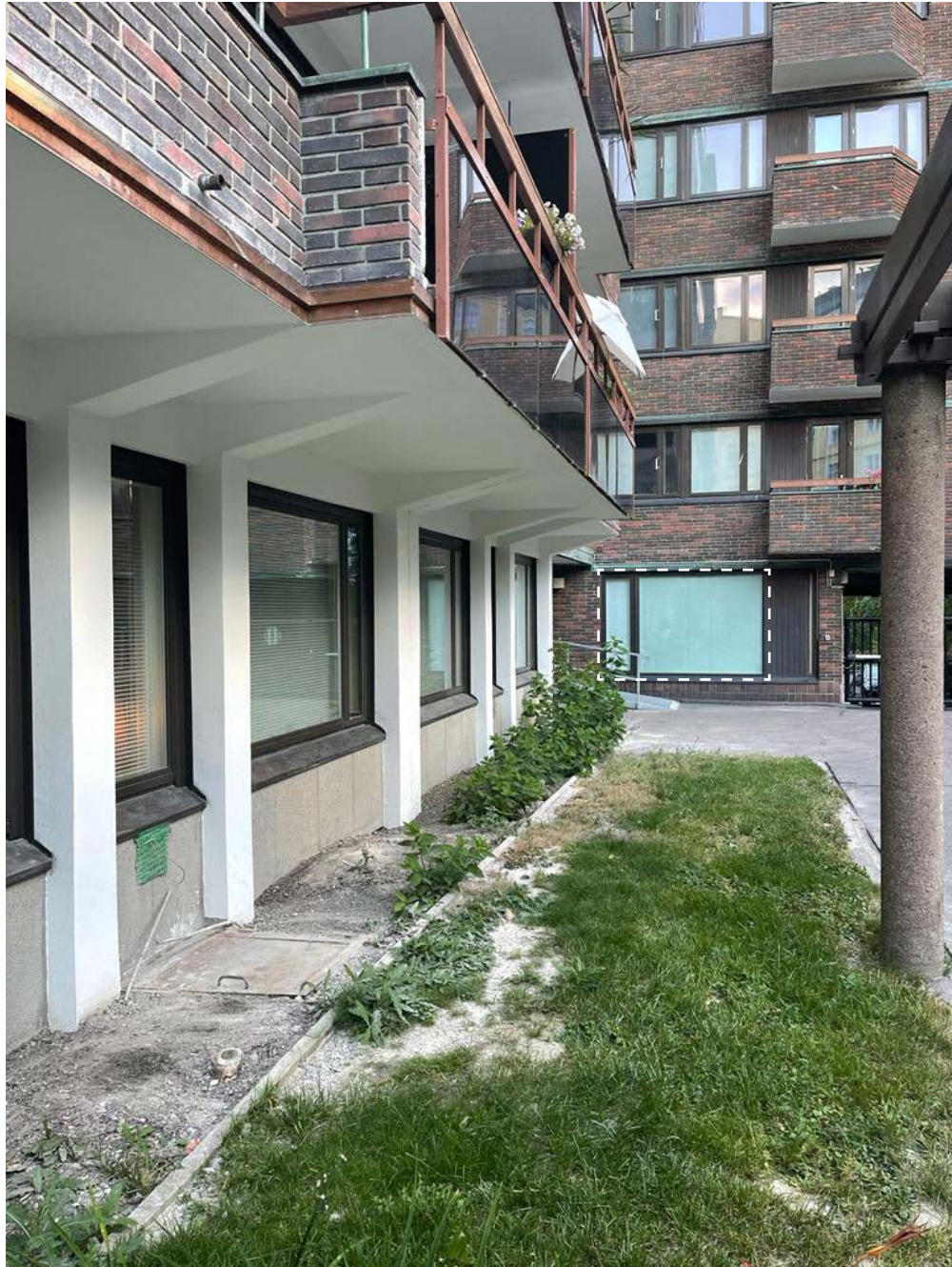
Näkymä sisäpihalta kohti huoneisto 3 B17 ikkunaa (korostettu katkoviivalla)
