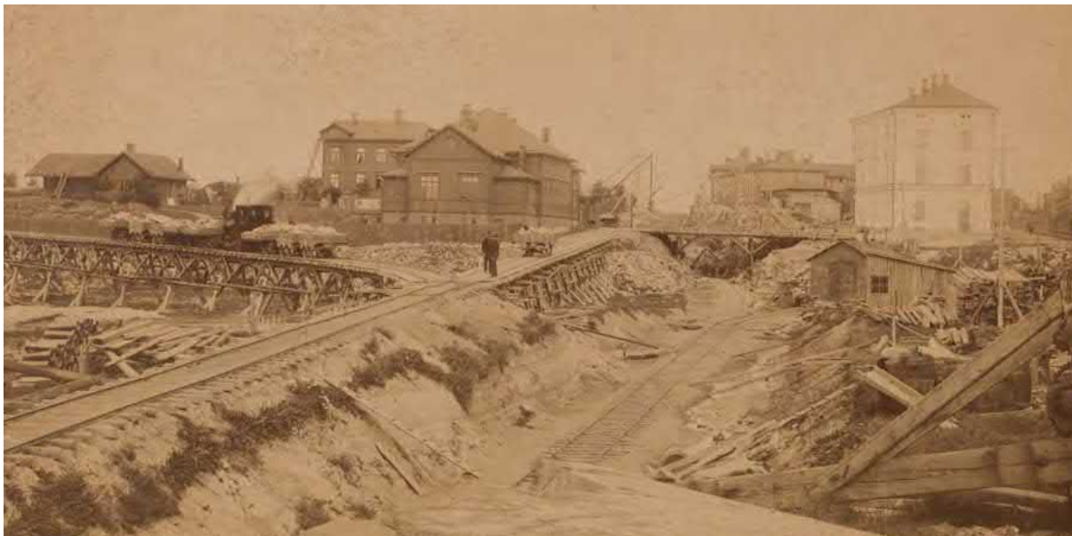
Satamaradan työmaa Leppäsuon kohdalla vuonna 1905. HKM
