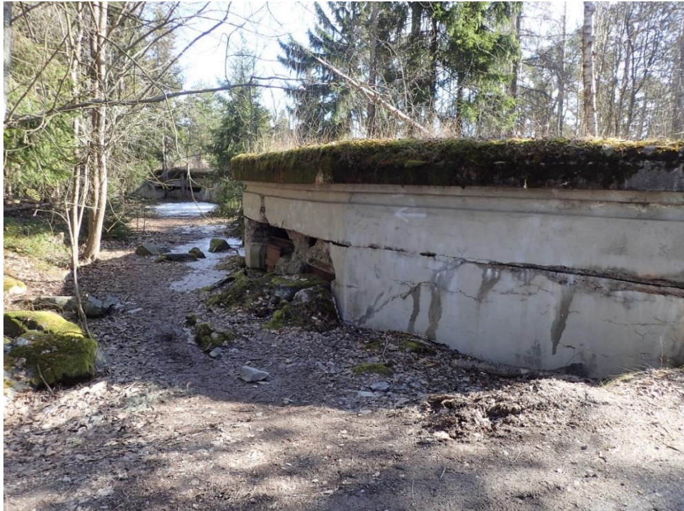
Kuva 3 Rannikkotykkipatteri on suurikokoinen rakennelma.
