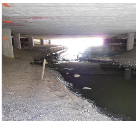
Kuva 41. Vesistöalikulku, johon yhdistetty kuiva tasanne. Vesistöalikulku, jossa maapenkereet uoman reunoilla (Strömbergin puisto). Kuva: Lauri Erävuori.
