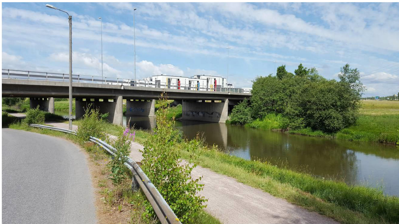
Kuva 33. Jokien ja vesistöjen ylityksissä siltarakenne on toteutettu siten, että rannoilla on sillan allittava maakaistale, jota myöten eliölajit voivat liikkua jokivartta myöten. Tuusulan moottoritie, Vantaanjoen ylitys). Kuva: Tiina Saukkonen.
