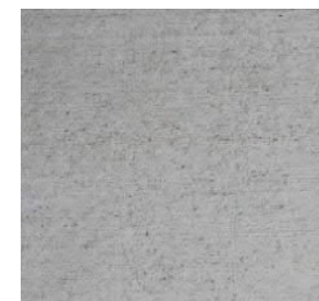
Betoni kadut, jalankulku, pysäköintialueet
