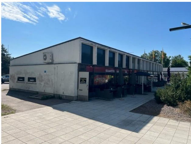
Rakennuksen pohjoispääty ja itäpuoli.
