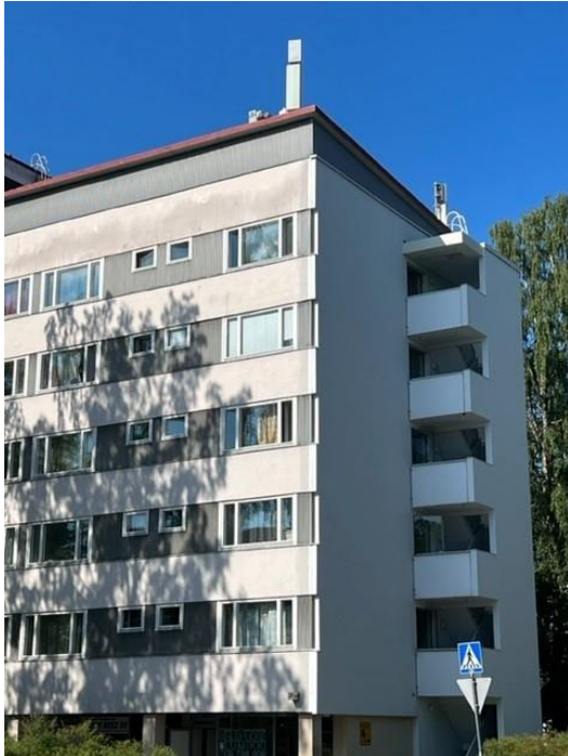
Rakennuksen pohjois- ja itäpuoli.
