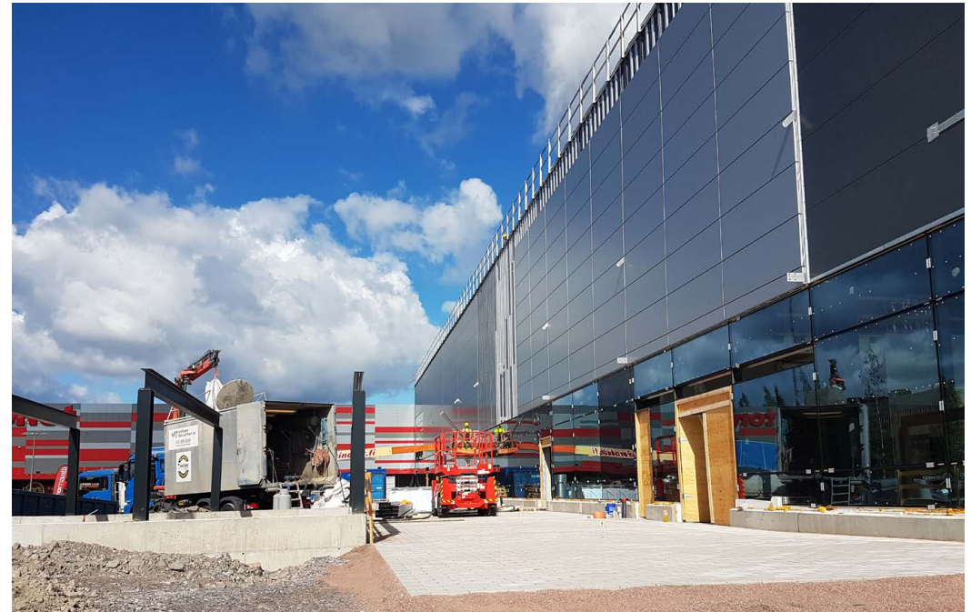
Kuva 18. Tulppatien liikerakennus rakentuu elokuussa 2017.
