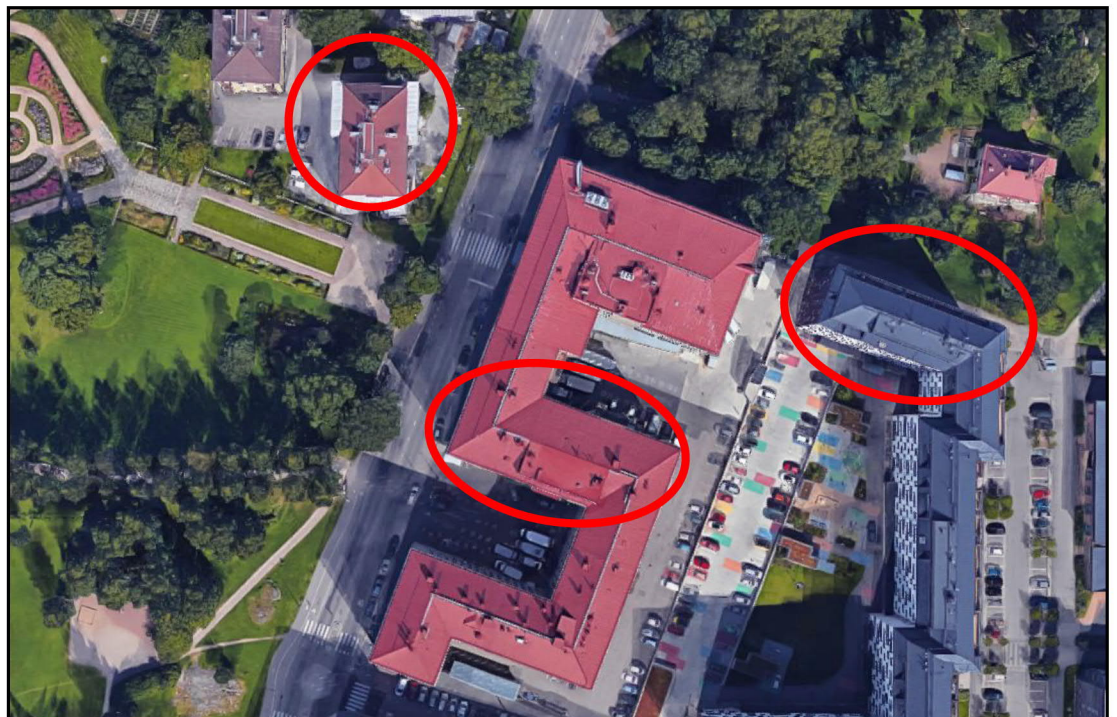
Kuva 4. Kohteen viereisten rakennusten katoilla sijaitsevat lähimmät LVIS-laitteet
