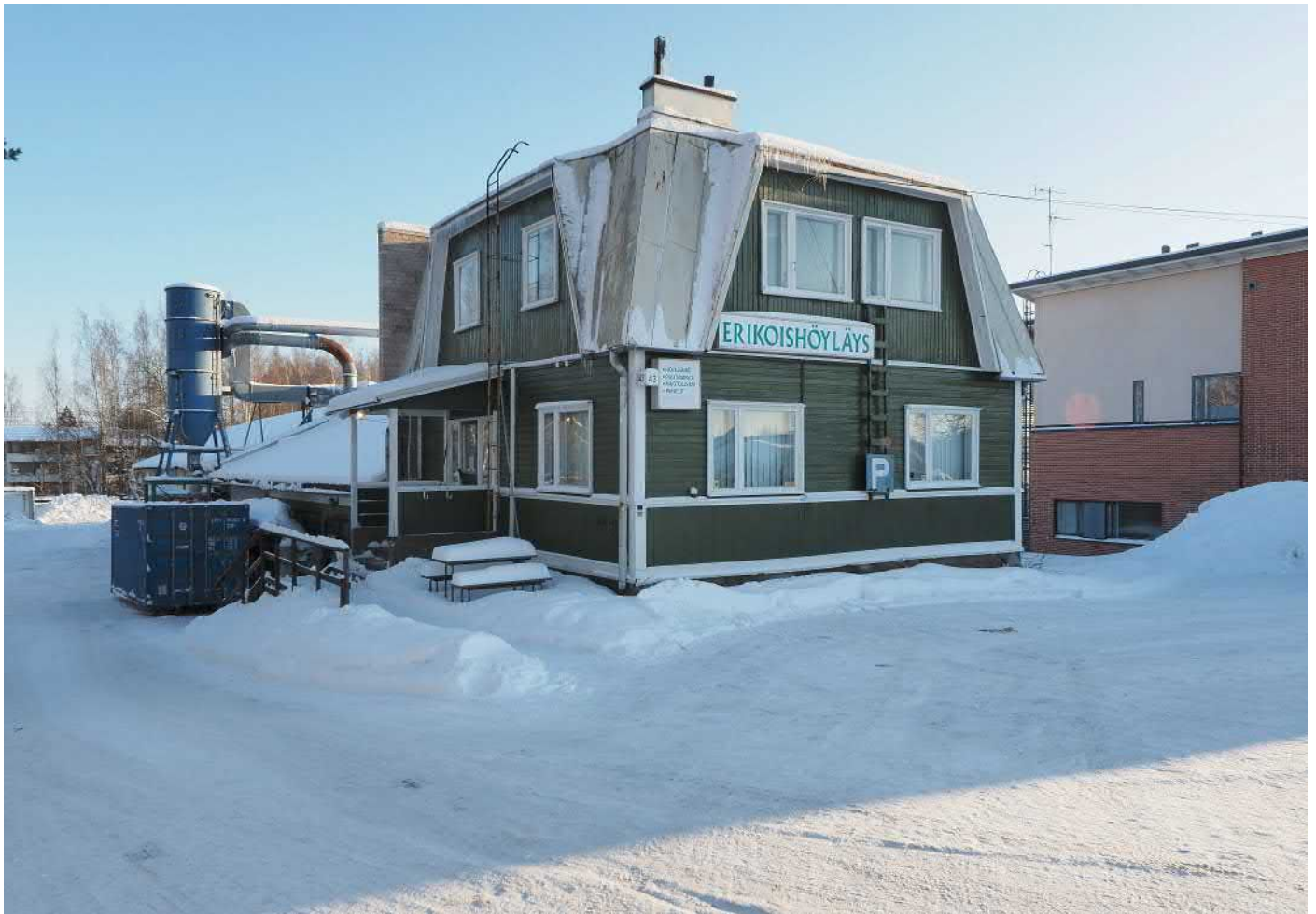
Rakennus kuvattuna pohjoisesta
