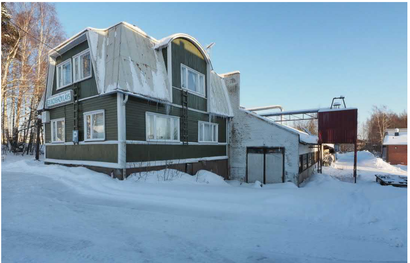
Rakennus kuvattuna lännestä
