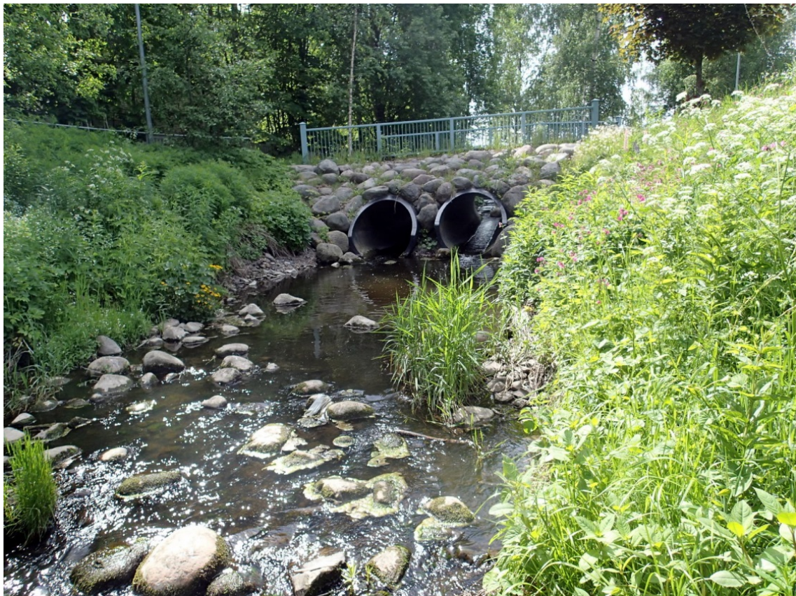
Kuva 8. Ojapuistonkosken yläpäässä oleva tienalitus on kaloille osittainen nousueste jyrkkien tierumpujen takia. jakso 19 ja 20
