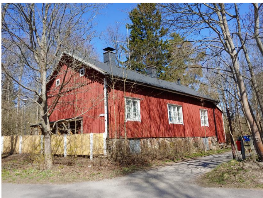
Kuva 4. Osoitteessa Mikkolantie 25 sijaitseva, asemakaavassa suojeltu rakennus (tontilla 34028/2)
