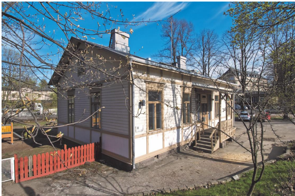
Kuva 3. Marian sairaalan rakennus 8, desinfiointivierasmaja
