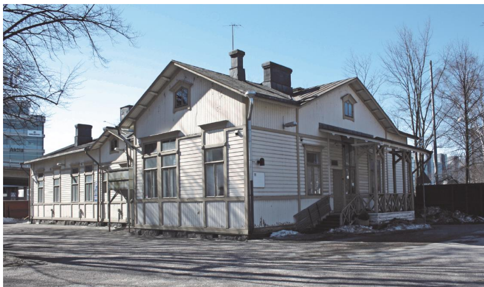
Kuva 2. Marian sairaalan rakennus 11, kulkutautipaviljonki
