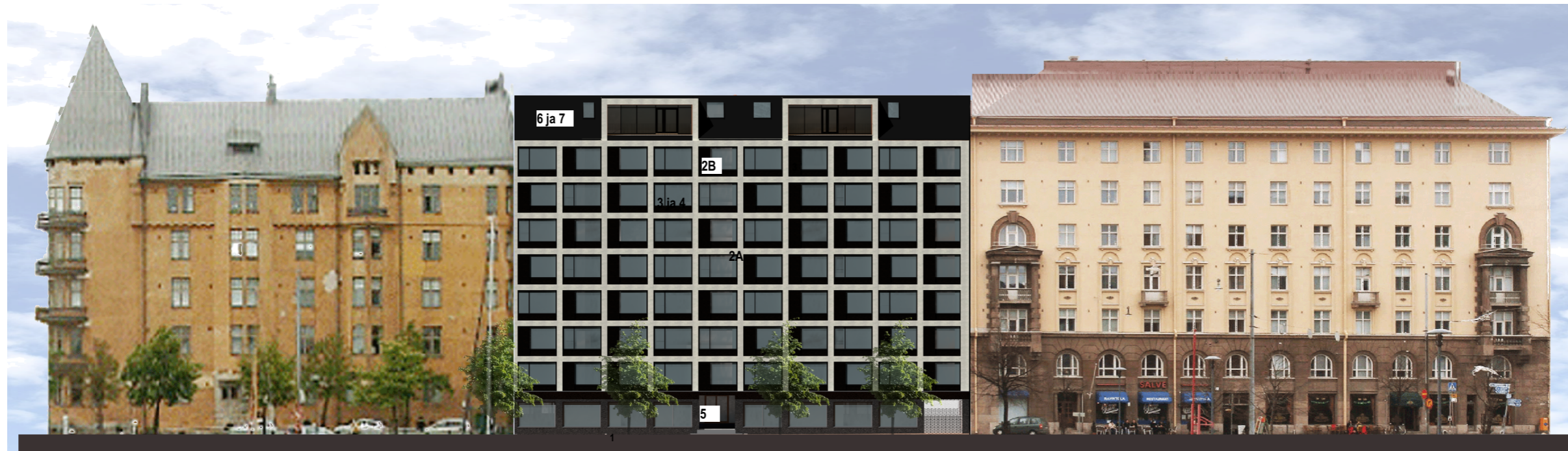
Katujulkisivu muutoksen jälkeen
