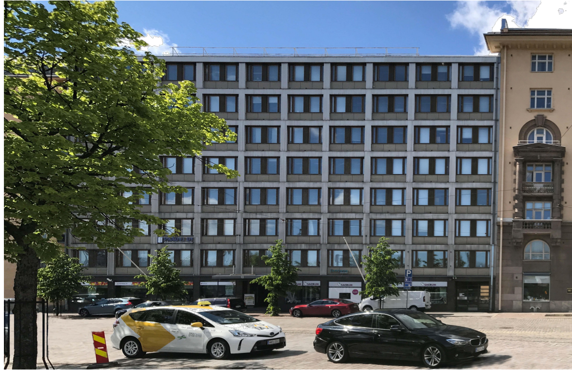
Katujulkisivu ennen muutosta
