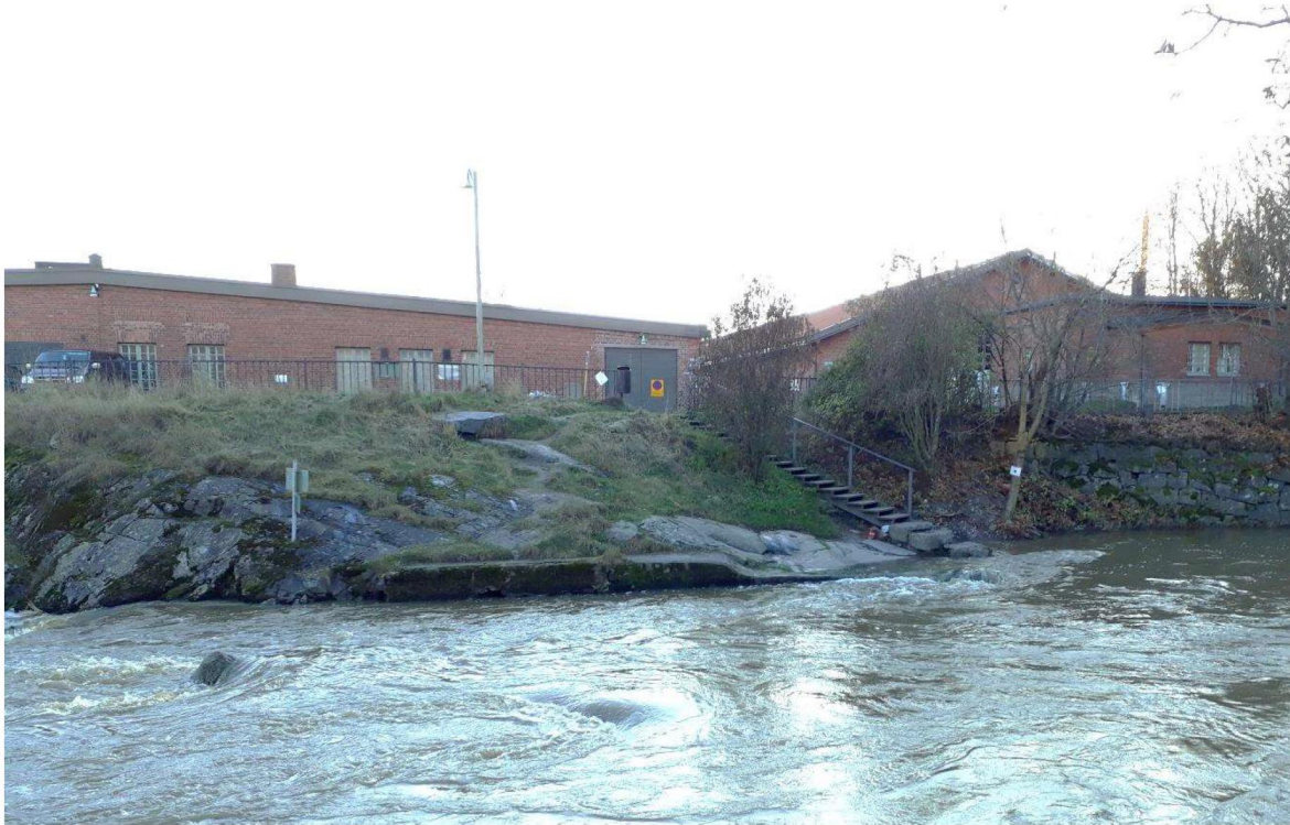
Kuva 3. Kohde 01: betonirakenne Kuninkaankartanonsaaren rannassa. Kuva: Eeva Vakkari, SubZone Oy, 31.10.2017.
