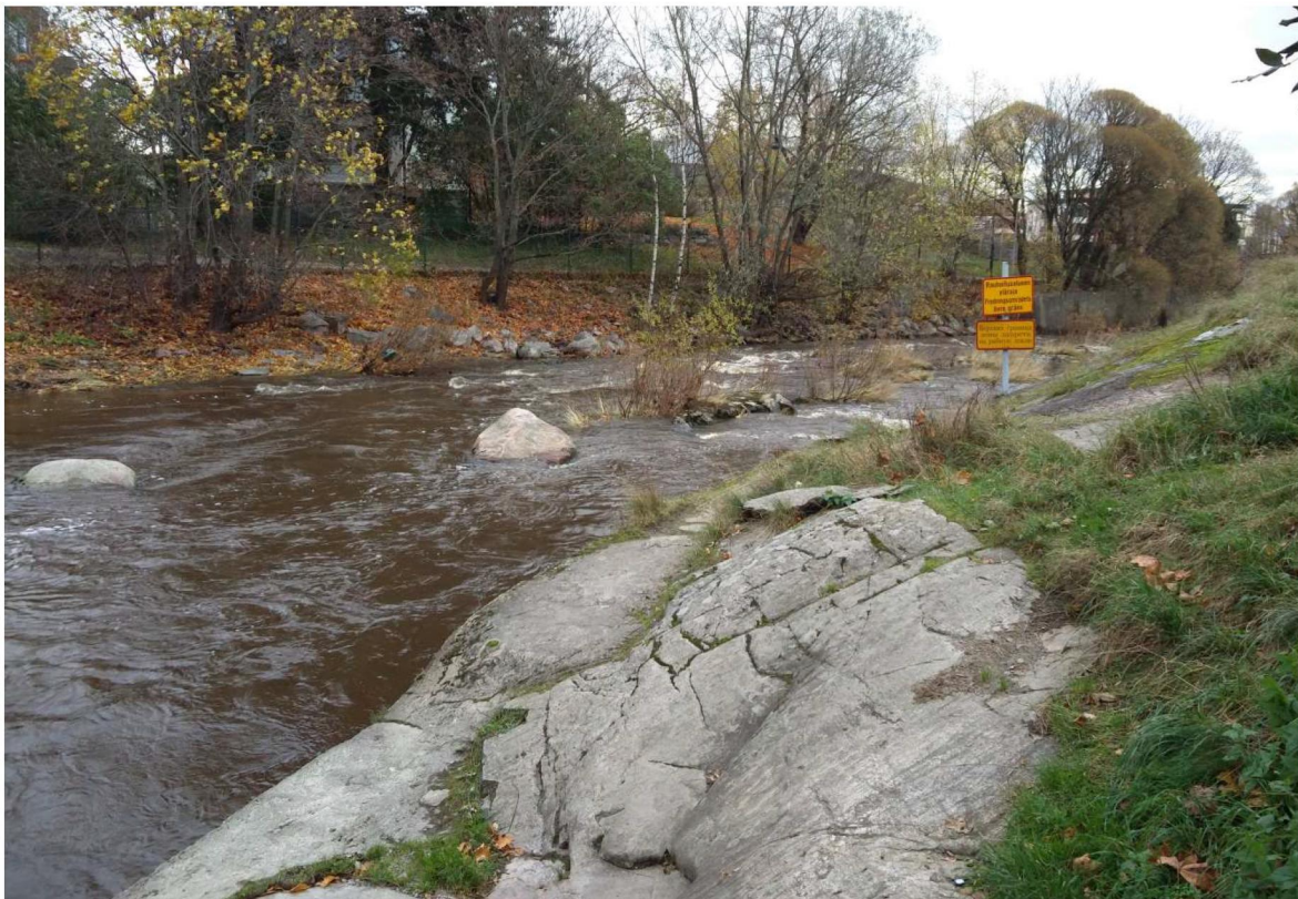
Kuva 4. Kohde 01: betonirakenne Kuninkaankartanonsaaren rannassa. Kuva: Immi Wallin, SubZone Oy, 25.10.2017.
