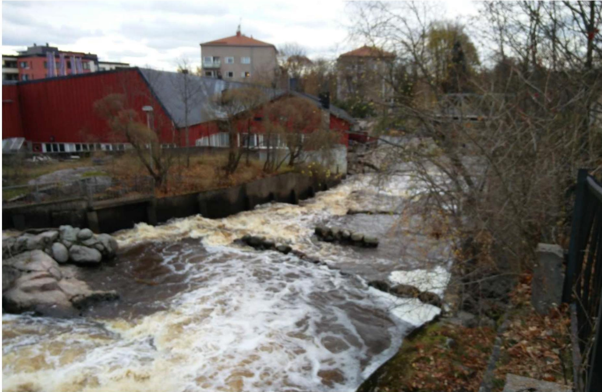
Kuva 9. Kohde 03: IVO:n vedenottoputken betoninen tukimuri kosken itäreunassa. Koskessa vuonna 1999 rakennettuja tasanteita. Kosken partaalla oleva rakennus on entinen IVO:n virtauslaboratorio, nykyinen ravintola Koskenranta. Kuva: Immi Wallin, SubZone Oy, 25.10.2017.
