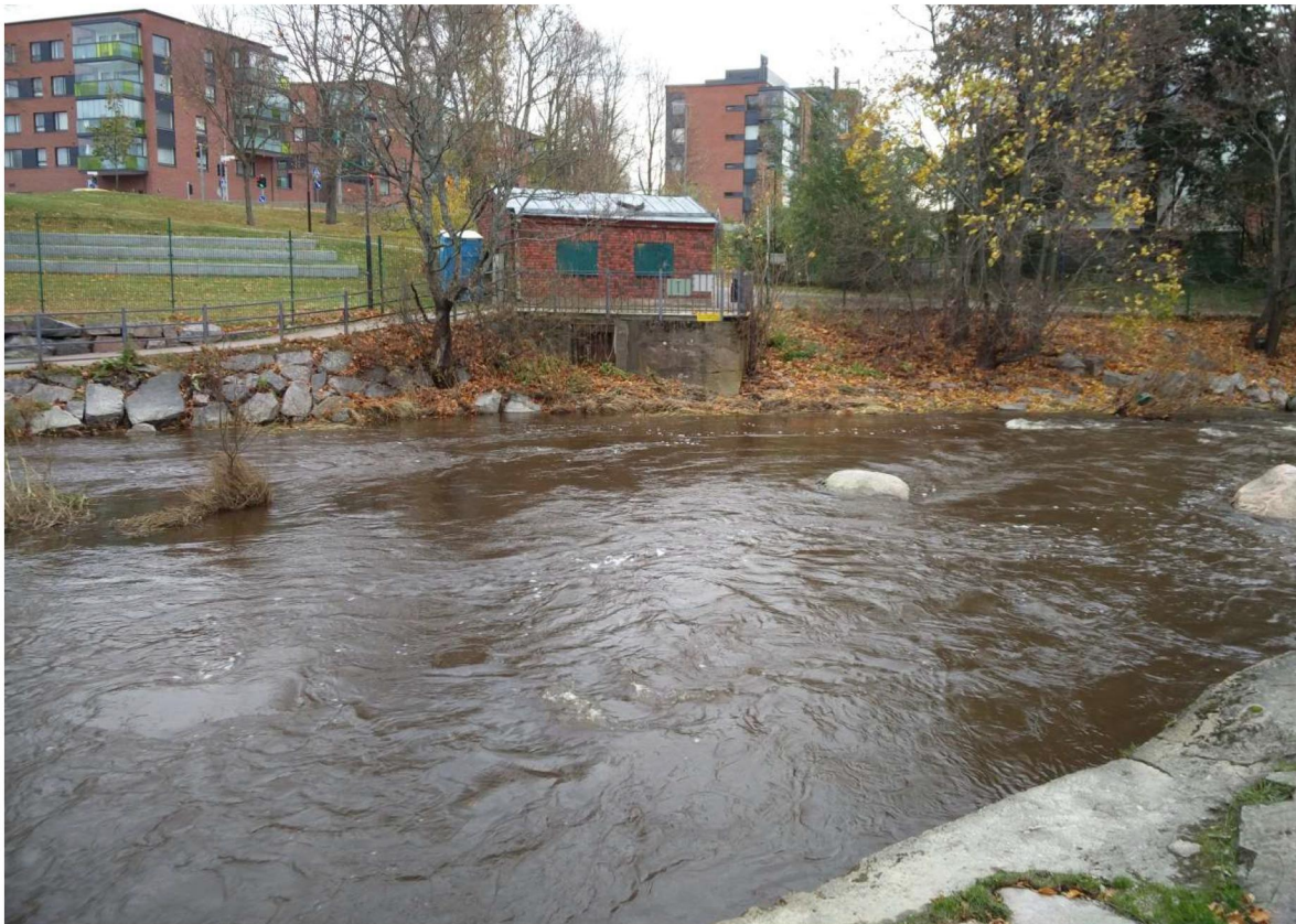
Kuva 7. Kohde 02: betonirakenne itärannalla, IVO:n vedenottamorakennuksen edustalla. Kuvassa etualalla osa kohdesta 01. Kuva: Immi Wallin, SubZone Oy, 25.10.2017.
