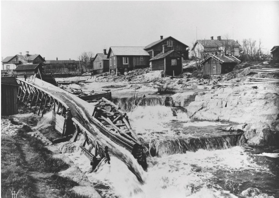
Kuva 1. Vanhankaupunginkosken itähaaran tukkiränni 1890-luvulla. Tukkiränni sijaitsi uoman Kuninkaankartanonsaaren puoleisessa reunassa, kosken jyrkimmässä kohdassa. Kuva: Rosenberg 1890-luku, Vantaanjoki, Vanhankaupungin itäinen koski, uittokouru . Helsingin kaupunginmuseo, kuvan inventaarionumero N259350, lisenssi CC 4.0.
