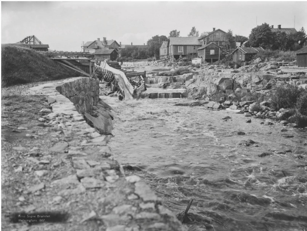
Kuva 2. Vanhankaupunginkosken itähaaran tukkiränni vuonna 1907, etualalla Kuninkaankartanonsaaren rantamuuria. Itärannalla Viikinmäen rakennuksia. Kuva: Signe Brander 1907, Vantaanjoki . Helsingin kaupunginmuseo, kuvan inventaarionumero N233, lisenssi CC 4.0.
