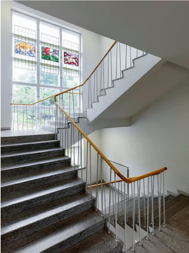
Päärakennuksen portaan alkuperäinen pinnakaide. Kuva Anttinen Oiva arkkitehdit oy. Käsijohteena on lakattu koivuprofiili. Kuva ark-byroo
