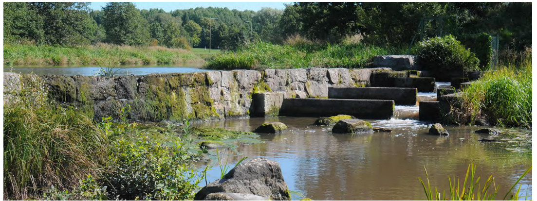
Kuva 10. Kirkonkylänkosken pato sekä oikealla etelärannan tuntumaan rakennettu kalaportas. Kuva: Oso Lintinen / Ramboll Finland
