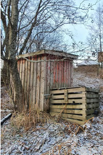
Kuva 11. Puurakenteinen pumppaamo puretaan. Kuva Hanna Keskinen / Ramboll Finland
