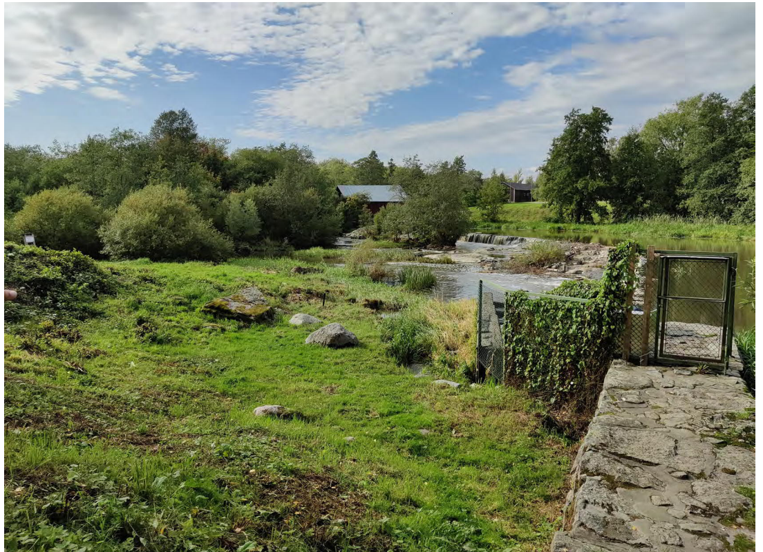
Kuva 1. Kirkonkylänkoski ja pato kuvattuna etelärannalta pohjoiseen. Kuva: Maria Hankala / Ramboll Finland
