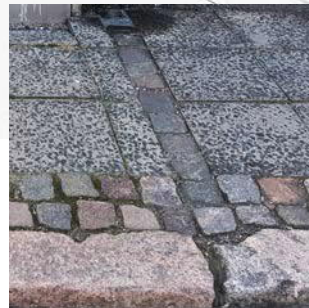
Puu-Vallilan edustalle ehdotettua yhtenäistä kiveysaluetta kehitetään siten, että se sointuu nykyiseen puutaloja kehystävään betoni- ja graniittipakkiviin ja -reunakiviin.
