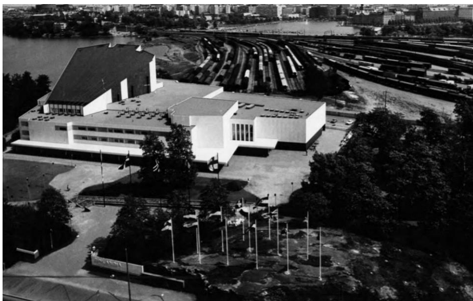
Kuva vuodelta 1971 (FTA) Finlandia-talon rakennushistoriaselvitys, arkkitehtuuri- ja muotoilutoimisto Talli Oy
