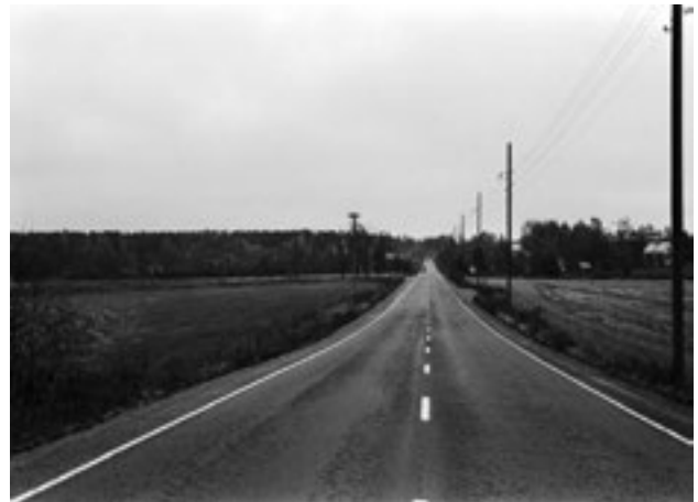
Vartiokylä, Vartioharju 1970. Näkymä Itäväylää koilliseen kohti Mellunkylää.
