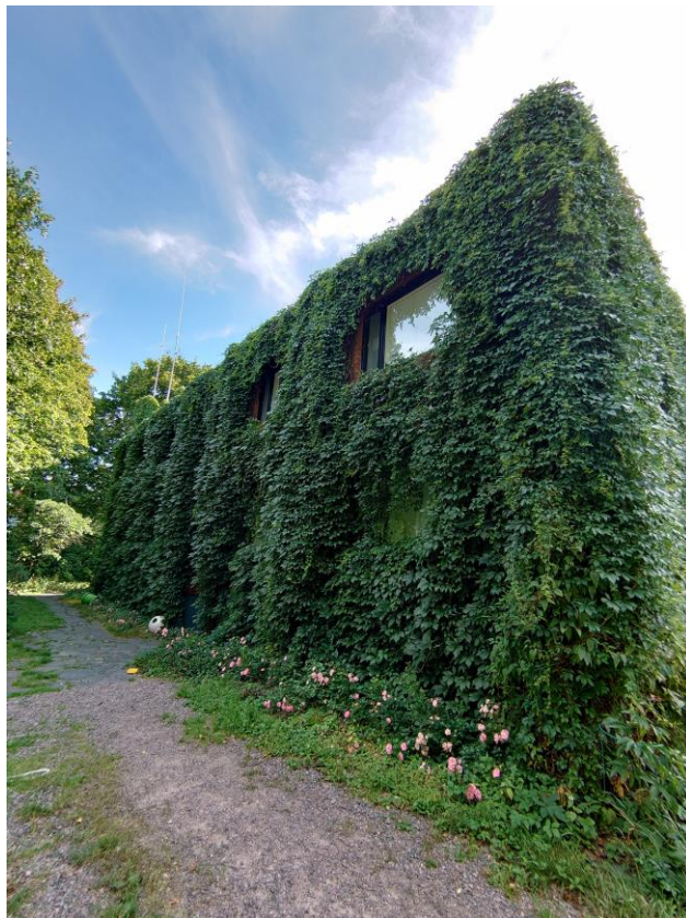
Kuva 37. Viikinmäentie 14. Villiviinin peittämä julkisivu.
