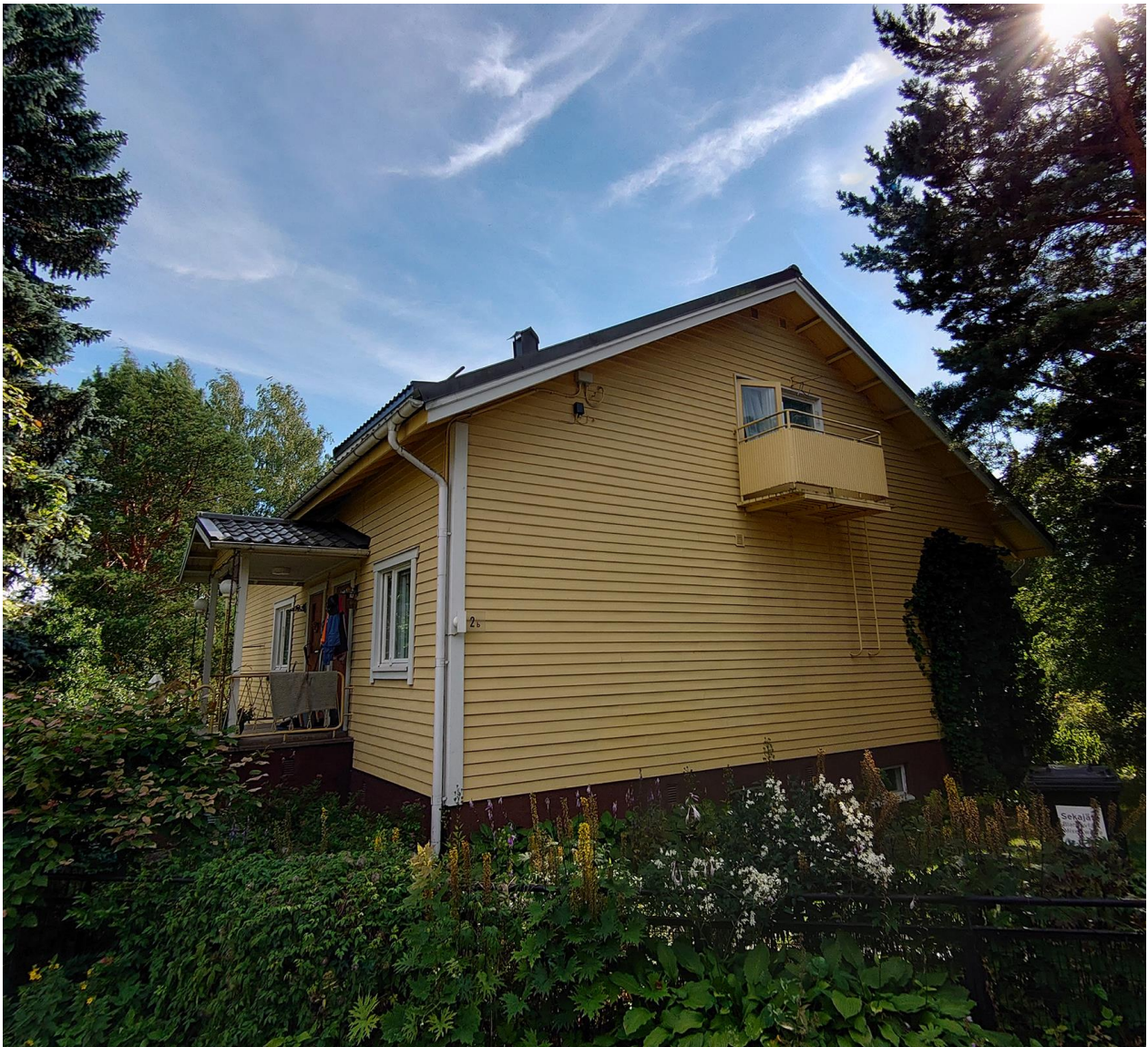
Kuva 21. Viikinmäentie 2b, näkymä kadulta. Rakennuksessa on kaksi asuntoa.
