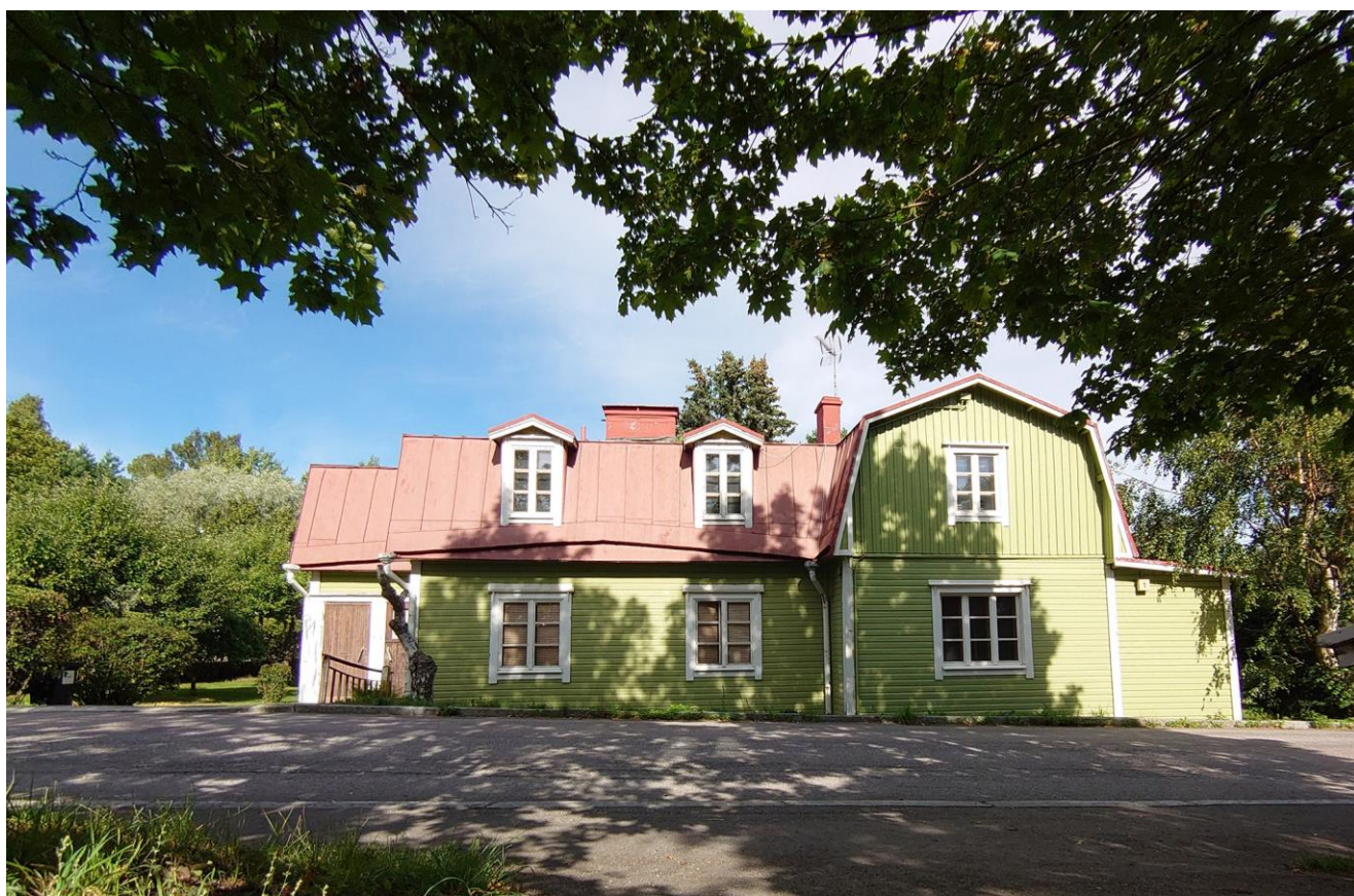
Kuva 18. Pornaistenkuja 1, kadunpuoleinen julkisivu.
