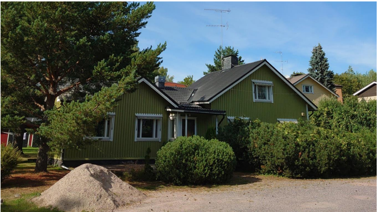
Kuva 16. 1890 valmistunut Viikintie 20. Vasen puoli toimi sekatavarakauppana vuoteen 1960, minkä jälkeen kahvibaarina aina 2020-luvun alkuun. Oikea puoli on ollut asuinkäytössä. Näkymä Viikintieltä.
