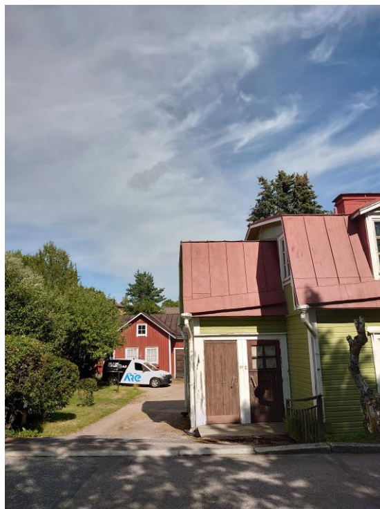
Kuva 17. Pornaistenkuja 1 pääty, taustalla talousrakennus.
