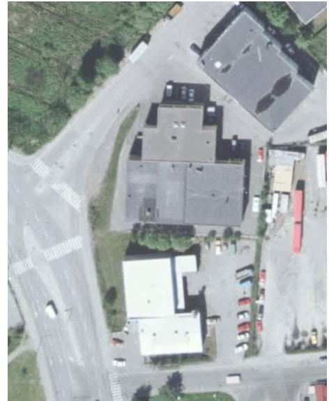
1988- Kaikki nykyisistä rakennuksista rakennettu
