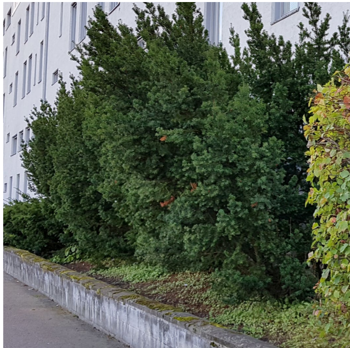
Matala muuri liittyy 2000-luvun rakentamiseen ja on oman aikakautensa elementti kaupunkitilassa. (TS)
