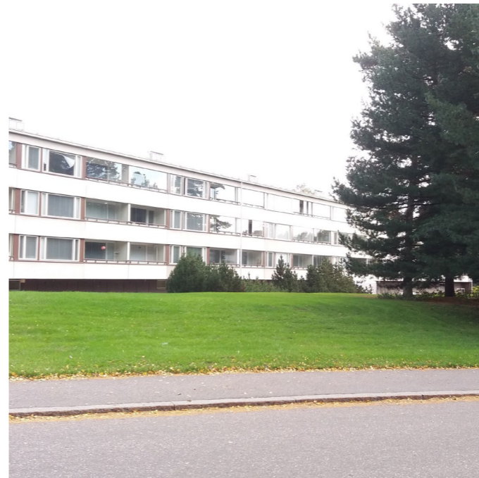
Laaja avoin nurmipinta liittyy suoraan kadun asfalttiin ja rakennuksen sokkeliin. Katualueen ja tontin raja ei erotu maisemassa. Pelkistetyt ikivihreät istutukset ovat aikakaudelle tyypillisiä. Kuvassa vuorimäntyjä ja sembramäntyjä Mustalahdentien pohjoisreunassa. Samaan aikaan istutetut puut ovat osittain tontilla, osittain puiston puolella. (RR)
