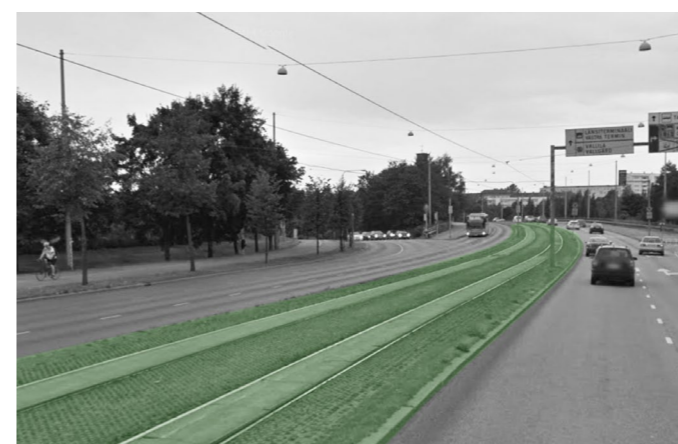
Malliesimerkki: Nurmikivetty raitiolinja Hämeentiellä.
