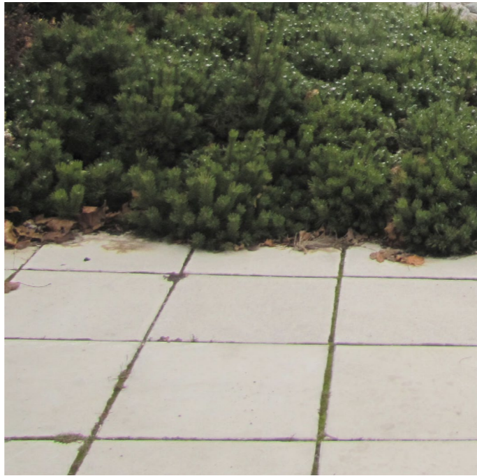
Iso betonilaatta on tyypillinen modernismin aikakauden rakennetuissa ympäristöissä. (BR)
