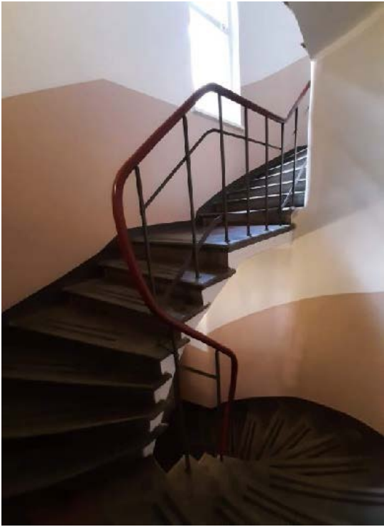
Porrashuone B. Molemmat porrashuoneet kaiteineen, lattiaineen ja ovineen ovat lähes alkuperäisessä asussaan ja hyvässä kunnossa. (Kuva: Varpu Pahta Ahlman 2.8.2021)
