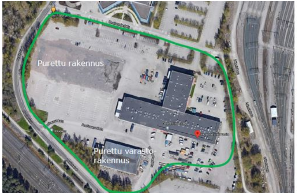
Kuva 2. Kohde vuoden 2021 ilmakuvassa. Alue jolla kaivetaan pilaantunutta maa-ainesta on rajattu kuvaan vihreällä. © Maxar Technologies
