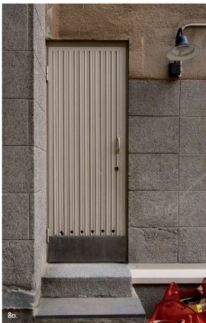
Kuva 82 1) ranskalaisten parvekkeiden kaiteet (maalattu) 2) suojakaiteet 3) yläikkunat (maalattu, sävy muutettu)
