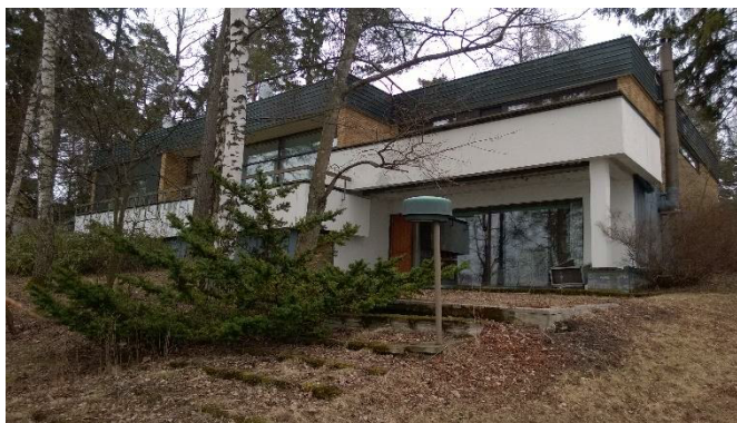
Vuonna 2017 purettu asuinrakennus
