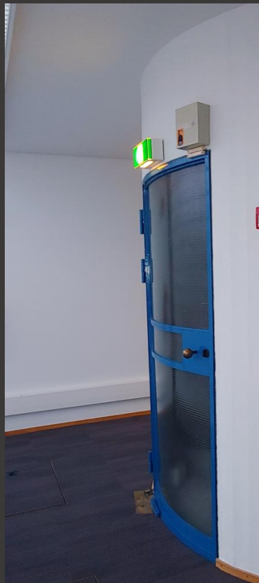
Sininen kaareva teräsovi poistumisportaan erikoisuutena
