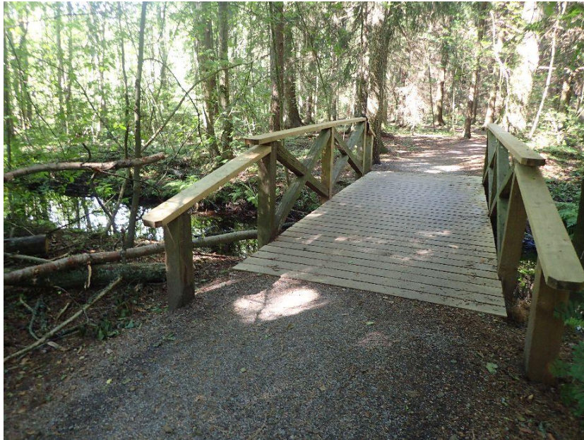
Kuva 30 Laskuojan ylittävä silta oli hyväkuntoinen vuonna 2020.
