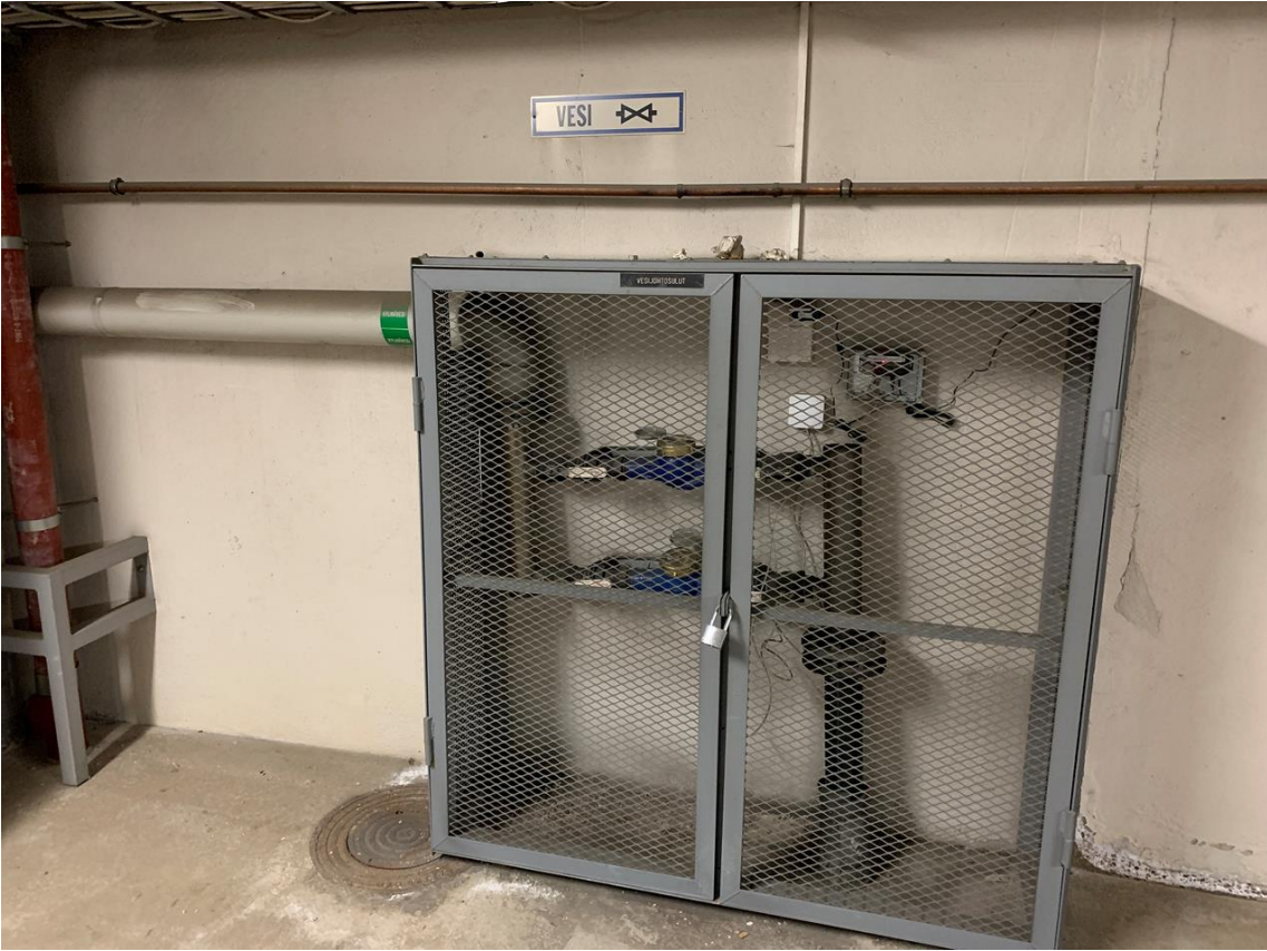
vesimittarit autohallissa.
