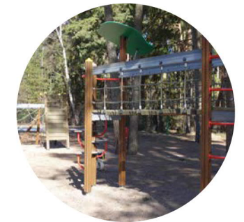
Leikkipaikan välineet uusitaan
