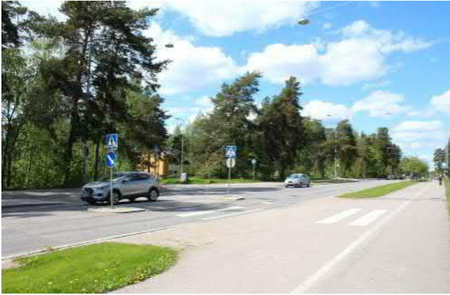
Kallvikintien ja Airoparintien risteys kohti pohjoista
