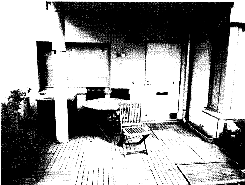
Kuva 43 , C49 ulko-oven edustalla oleva terassin kestopuinen pihalaatoitus. Huom. kuvassa näkyvä parvekkeen teräsbetonipilari kaipaa kunnostusta (asia tarkemmin kohdassa 11. parvekkeiden kunnostus)
