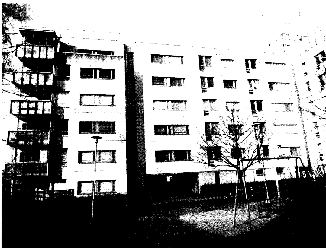
Kuva 26, sisäpihan julkisivua, mm. betonielementtien yläosat ovat likaantuneet.
