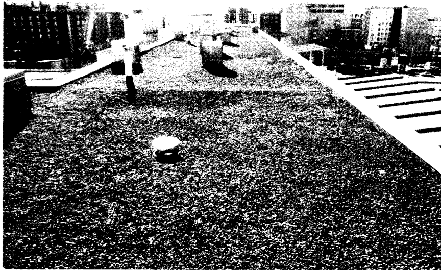
Kuva 15 , yleiskuva n. Avain Asumisoikeuden hoitovastuulla olevasta singelillä suojatulla bitumikermikatteisesta katosta (kuvassa etualalla näkyvä kattokaivon suojaritilä kuuluu naapurikiinteistölle).
