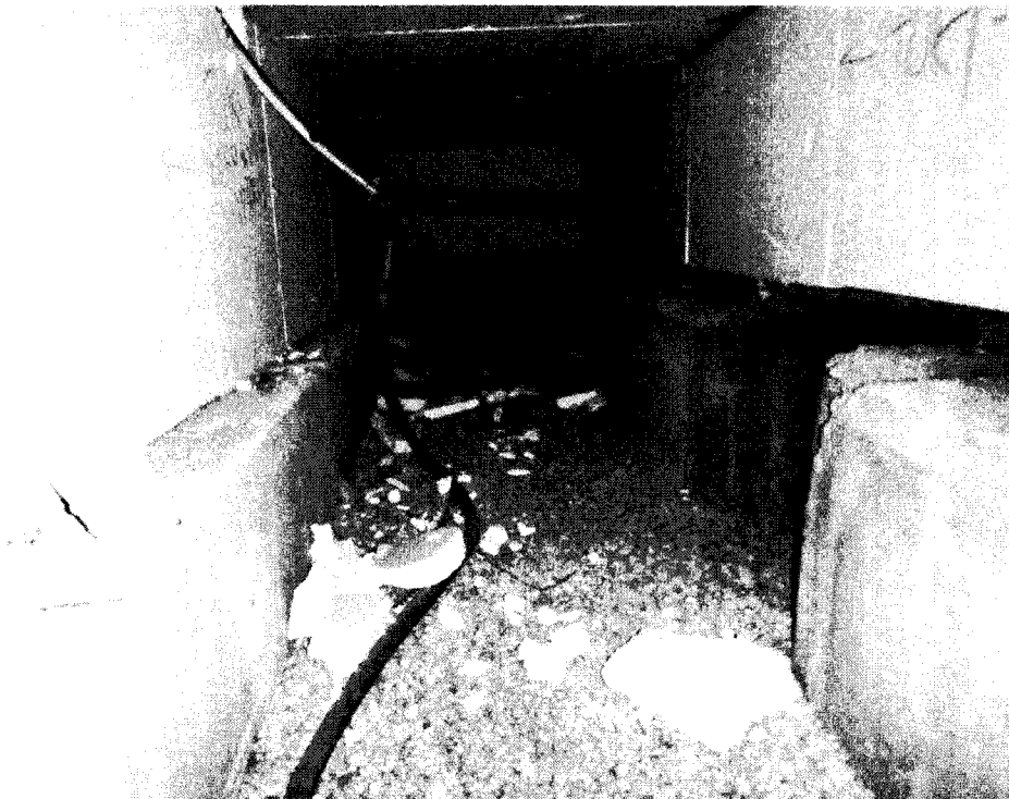
Kuva 39 , Alapohjassa on muutamissa kohdissa rakentamisen jäljiltä SPU levyn kappaleita.
