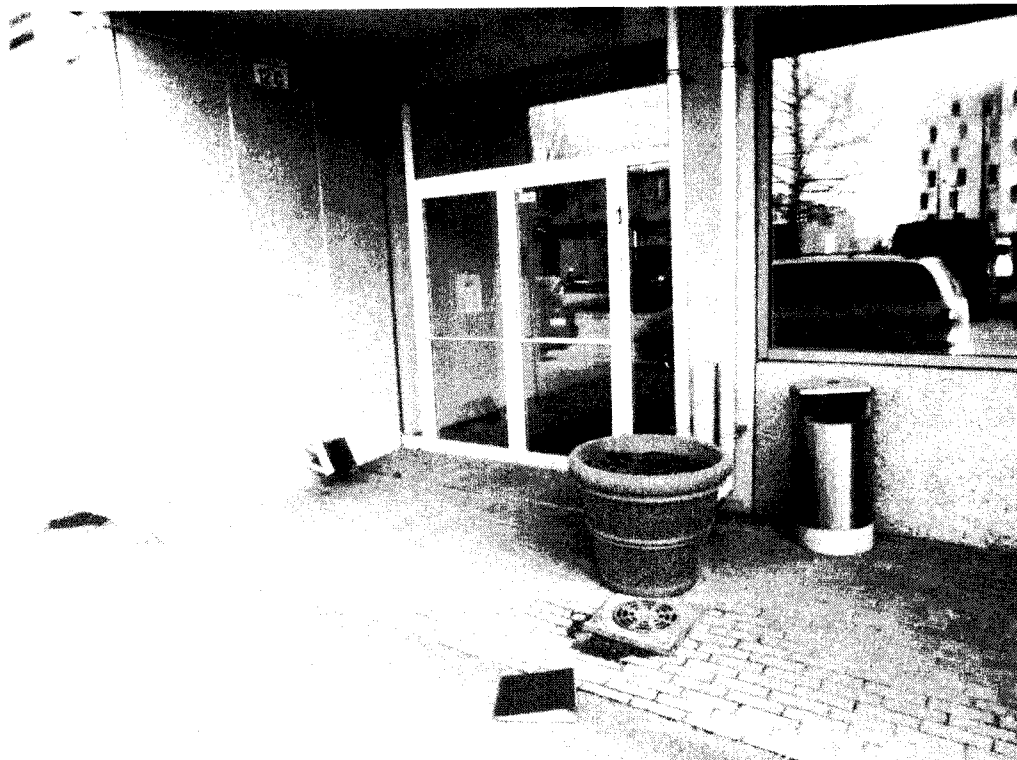
Kuva 41, Katusivustalla C-portaan edustalla havaittu betonikiveyksessä painautuma. Sade- ja sulamisvesi jää seisomaan kaivon vierustalle
