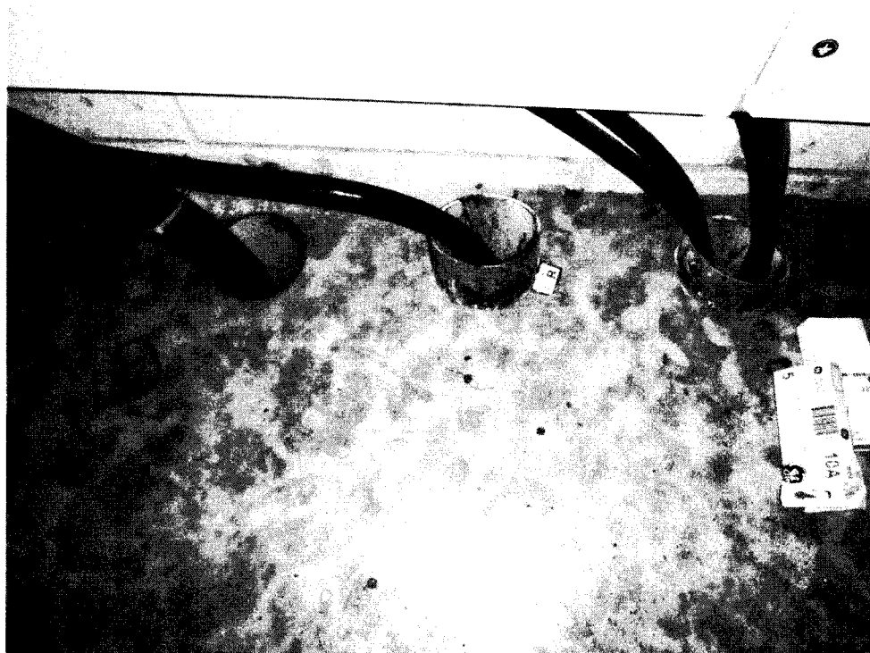
Kuva 40 , Alapohjan läpimenot eivät ole kaikilta osin tiiviitä, kuva otettu C-porrashuoneen lastenvaunuvarastosta (missä oli tarkastuspäivän polkupyöriä säilytyksessä)
