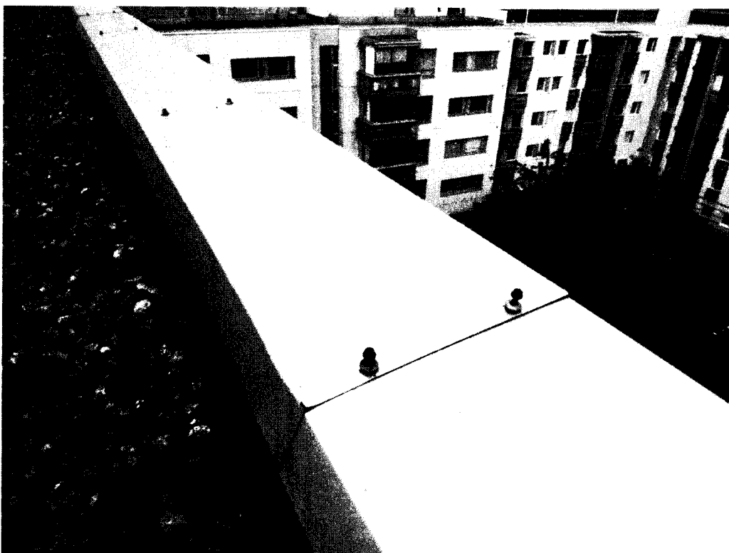
Kuva 23, Räystäspelttien kiinnitysruuvit ruostuneet ja osa oli löysällä.
