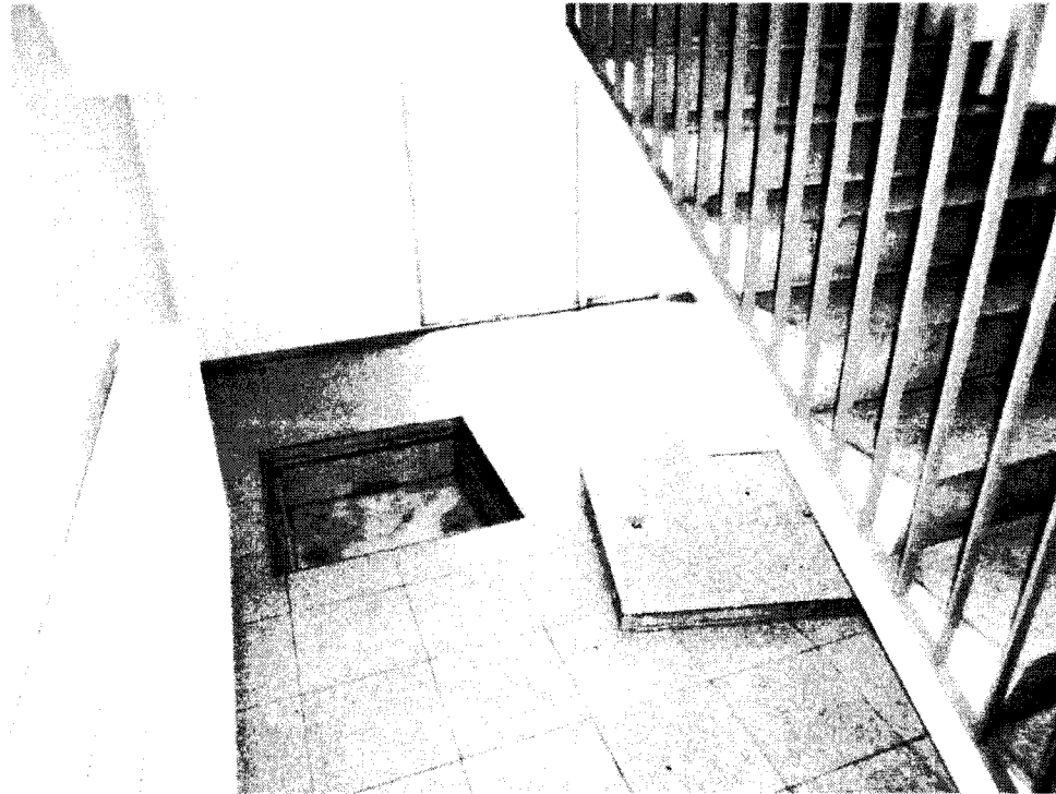
Kuva 36, alapohjaan kulku porrashuoneen tarkastusluukun kautta (yht. 2 kpl)
