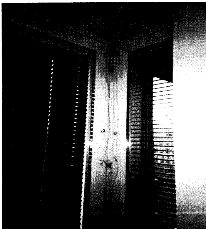
Kuva 28, esim. julkisivun "kylmät" ulkonurkat
