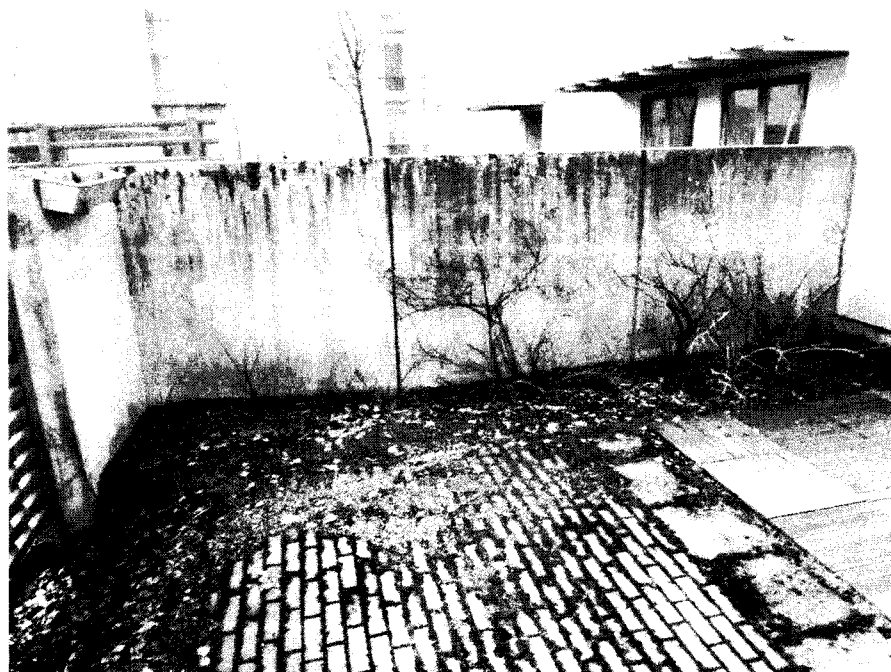
Kuva 7, tontin rajalla olevaa betonimuuria (huoltoliikettä poistaa kulkuväylällä olevan sammaleen)
