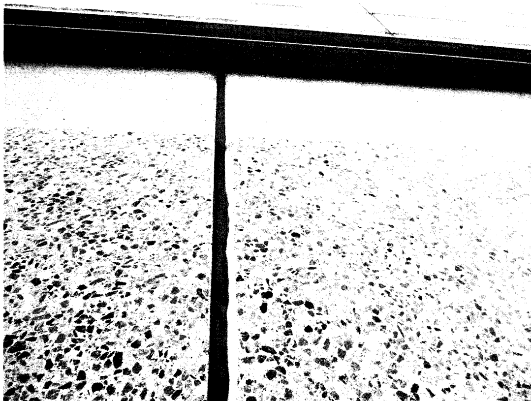
Kuva 25, esim. katujulkisivulla elementtisaumoissa havaittavissa halkeilua
