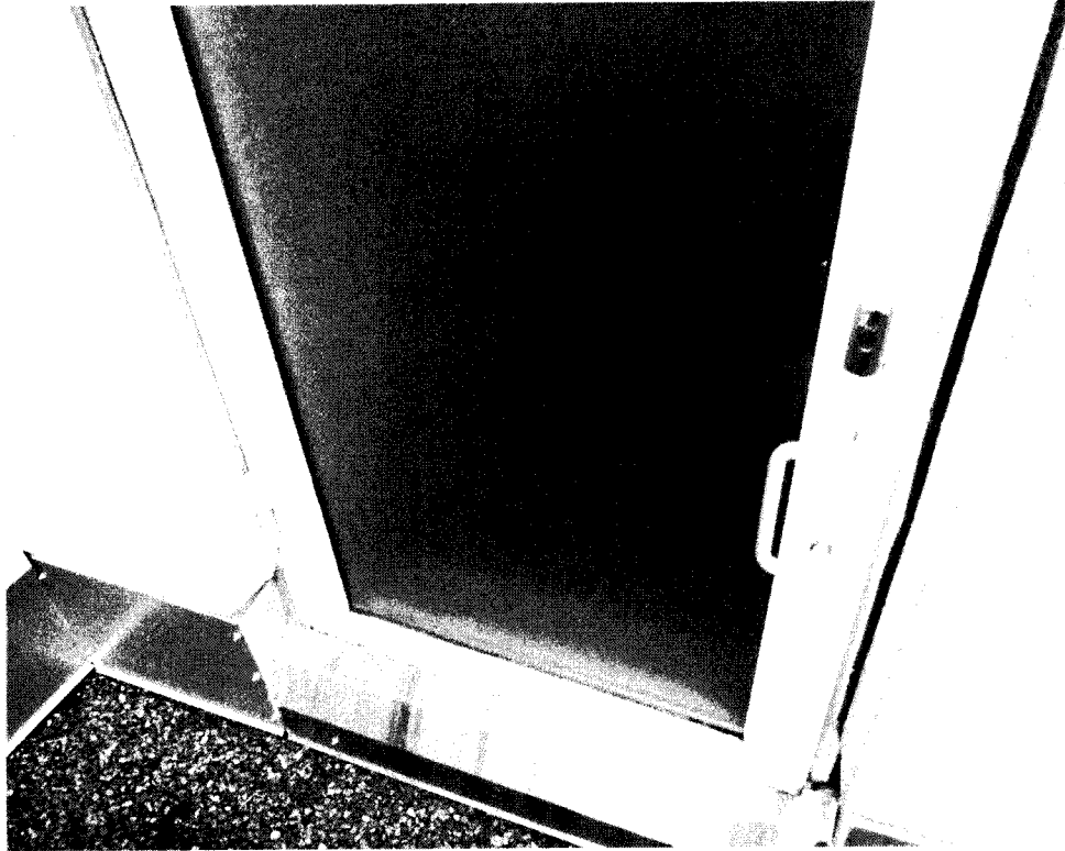
Kuva 17 , kuvassa näkyvä B- porrashuoneen ovi kuuluu Avain Asumisoikeuden hoitovastuulle, ovi kaipaa kunnostusta peruskorjauksen yhteydessä.
