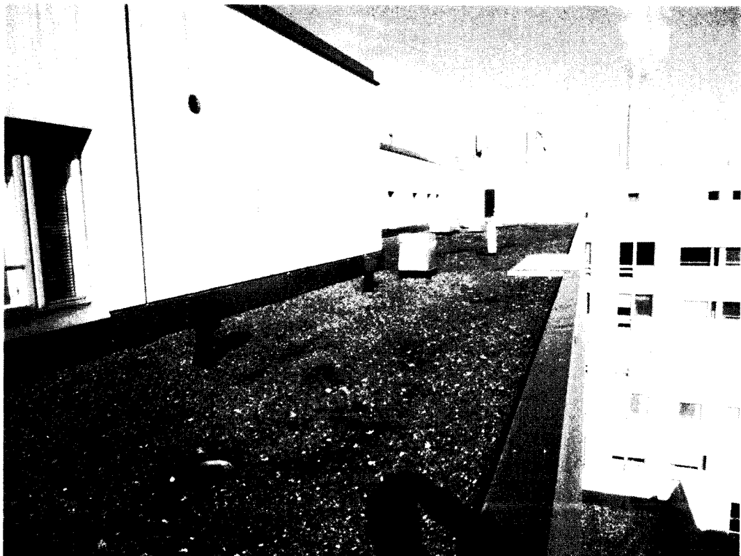
Kuva 20 , matalammalla sijaitsevaa kattoa (vertaa kuva 16).
