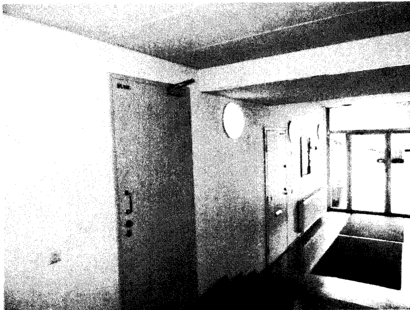
Kuva 14, esim. porrashuone valaisimia sisääntulo aulassa.
