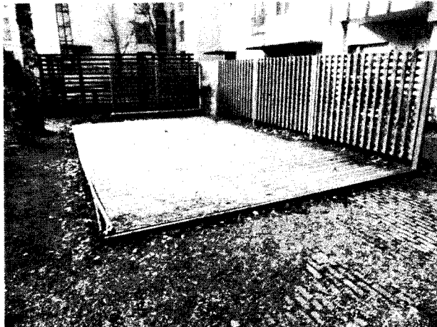
Kuva 6, mm. pergola-aita (kuvassa näkyvän pation aurausvaurion huoltoliike korjaa)
