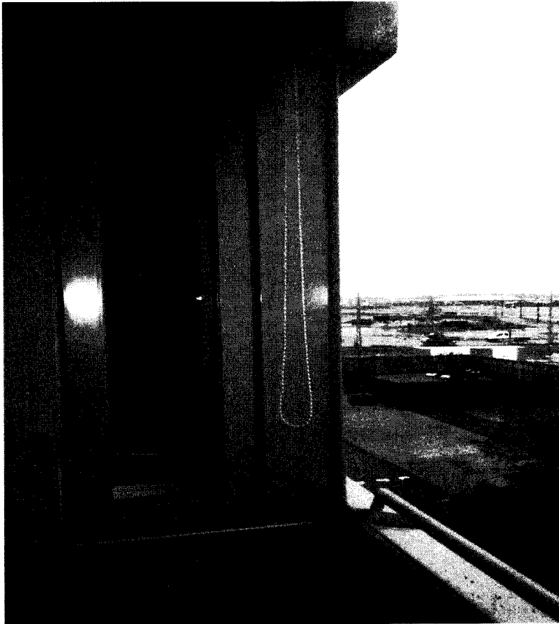
Kuva 29, esim. julkisivun "kylmät" ulkonurkat
