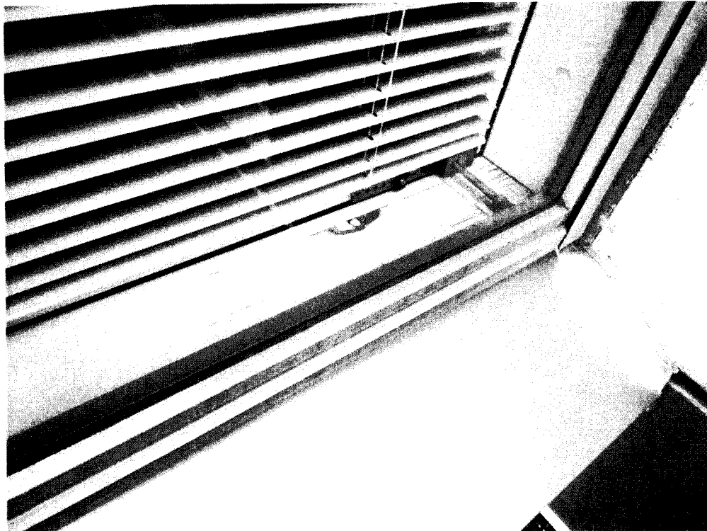
Kuva 44, mm. ikkunoiden puurakenteiset karmit ja sisäpuite kaipaa korjaustoimi, puurakenteissa halkeamia, kosteusvaurioita (kuvassa sisäpihan ylimmän kerroksen yksi ikkuna)
