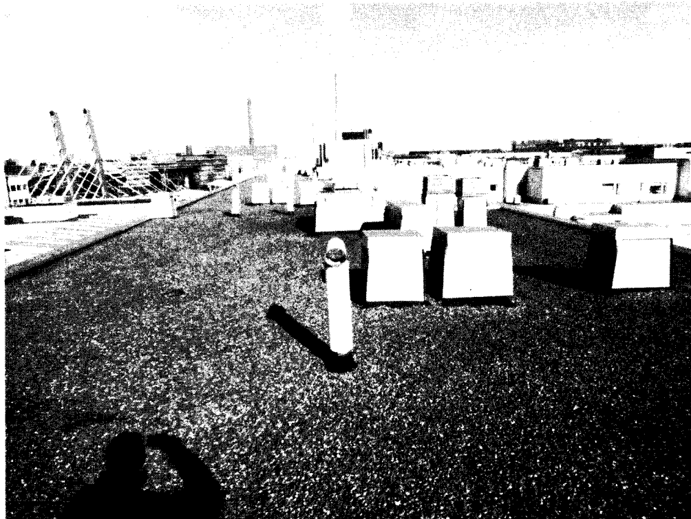
Kuva 8 , katolta löytyy useita IV- puhaltimia. Siis vain C-porrashuoneen puhallin on Avain Asumisoikeuden hoitovastuulla.
