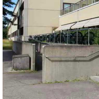
Terveyskeskuksen eteläpuoleisen terassin betonilaatat teräskaitteineen.
