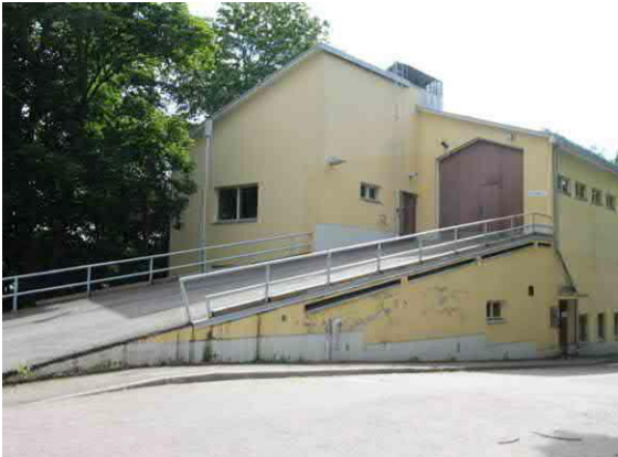
Laakson sairaalan vuonna 1956 valmistunut lämpökeskusrakennus.
