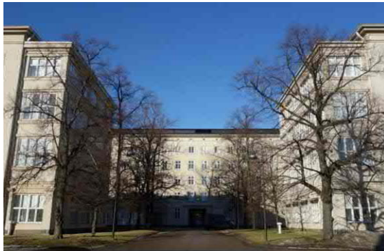
Keskiakseli nykytilassaan. Osa alkuperäisistä lehmuksista on säilynyt. Kulkuväylät on asfaltoitu, kulmat pyöristetty, arkadikäytävät rakennettu umpeen ja päätyparvekkeita korotettu.
