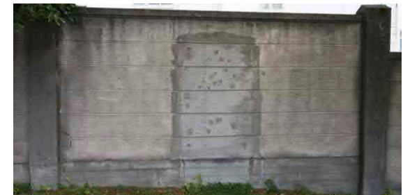
5. Umpeen muurattu kulkuaukko on palvellut mahdollisesti vielä 1929 tontilla sijainnutta Bergströmin huvilaa tai muuta toimintaa.
