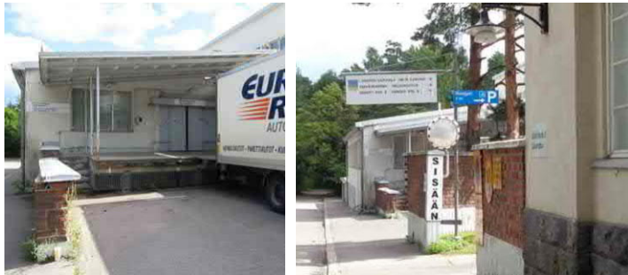
1. Vanha muuri autotallilta kappelin portille asti on poistettu. Sen tilalle on tullut tiilimuri, jossa uusi sisäänkäynti ja keittiön huoltopiha.
