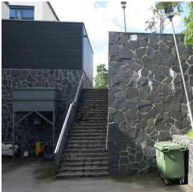
Uuden kuntoutuskeskuksen huoltopihan sileäpintaiset luonnonkivimuurit, osittain yhdistetty tiheäjakoiseen teräsaitaan.
