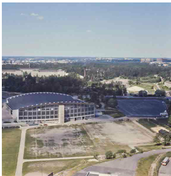
1960-luvun lopussa Ärtin koulupuutarhan paikalle rakennettiin uuden jäähallin paikoitusalue. (HKM)
