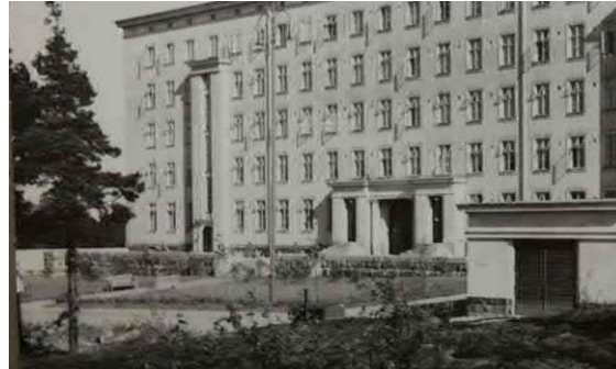
Pääsisäänkäynnin edustalla näkyvät vuoden 1933 istutus-suunnitelman mukaan tehdyn puurivit ja istutukset. (MVka)
