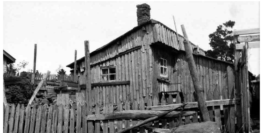
Läntinen Viertotie. Huvila-alue Laakson kohdalla 1924 (Mannerheimintie 51-63). Entinen kanala, josta asuntopulan aikana oli tehty asunto. (HKM)
