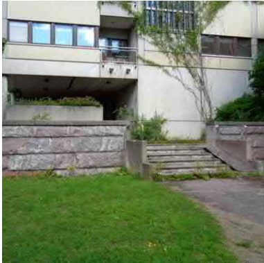
Uuden terveyskeskuksen lohkopintainen luonnonkivimuuri.
