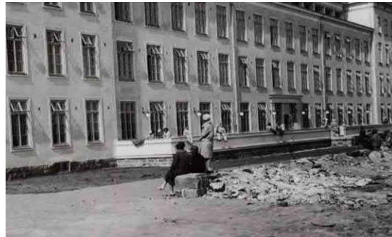
Toteutunut muuri sairaalarakennuksen ulkoterrassin edustalla 1929.
