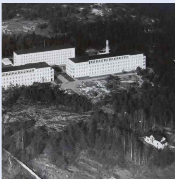
Dalin tilaan kuulunut Bergströmin huvila sijaitsi vielä tuberkuloosisairaalan valmistuessa sairaala-alueella. Sinne oli suunniteltu muun muassa henkilökunnan asuintiloja.
