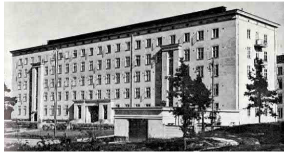
1. Pääsisäänkäynti hallintorakennuksen porttikäytävän läpi.
