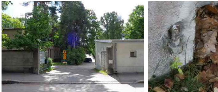
2. Uusi sisäänkäynti talusrakennuksen itäpuolelle. Kappelin alkuperäinen sisäänkäynti on säilytetty 1980-luvulle asti, minkä jälkeen se on muurattu umpeen. Vanhan portin saranat ovat edelleen paikoillaan.
