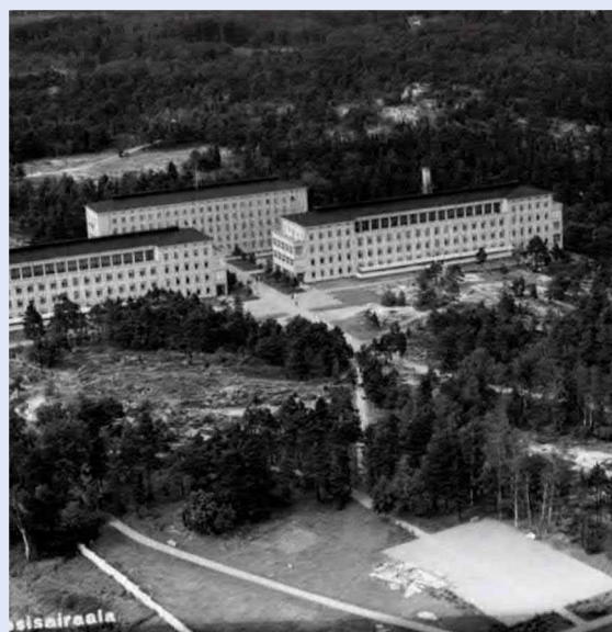
Bergströmin huvila purettiin kuitenkin pian tuberkuloosipotilaille tarkoitetun kroketkentän tieltä. Pelikenttiä oli alkuperäisessä puistosuunnitelmassa kaksi. Keskiakselin itäpuolella sijainnut kenttä jäi kuitenkin toteuttamatta.
