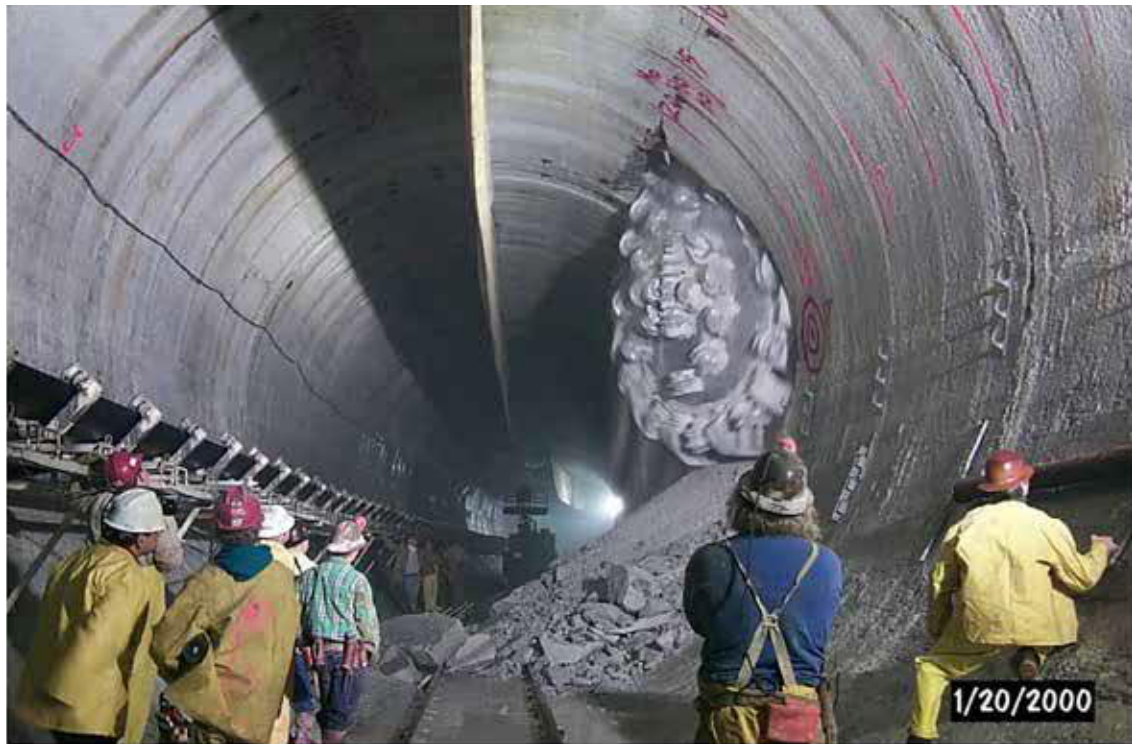
Kuva 4-5. Täysprofiilikone (Robbins TBM) on jyrsimässä tunnelia Chicagossa USA:ssa. Kuvassa näkyvät jyrsinporakoneen leikkauspäät ovat puhkaisseet yhteyden päätunneliin, joka on tehty TBM-menetelmällä. Lähde: Lach ym. 2000.
