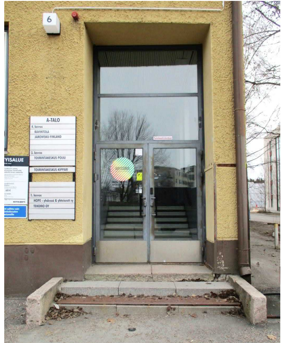
Kuva 42. Pääsisäänkäynti. Ovi on uusittu, ajankohta ei tiedossa.
