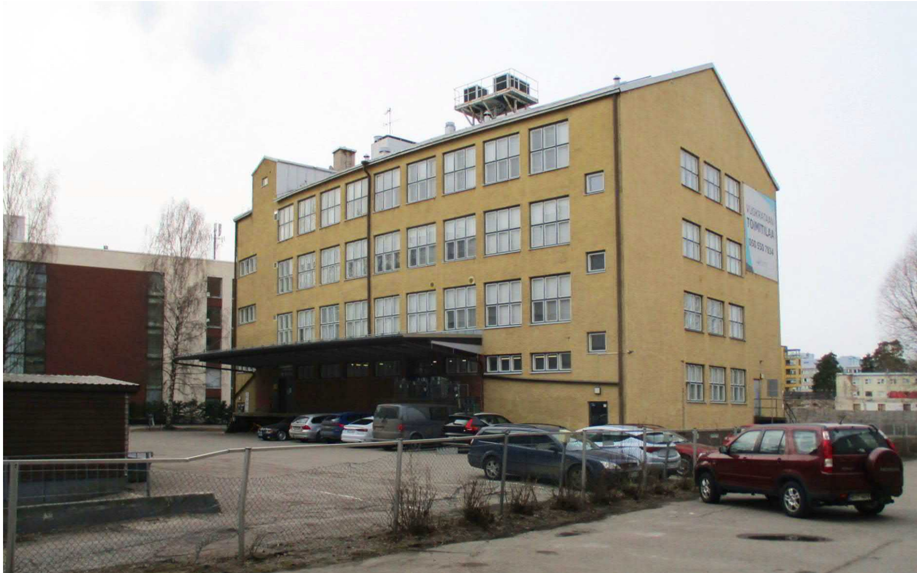
Kuva 37. Näkymä rakennukseen naapuritontista (Kutomotie 4). Etualalla lastauslaiturin oikealla puolella alkuperäinen luiska on poistettu ja korvattu portailla kellarikerrokseen.
