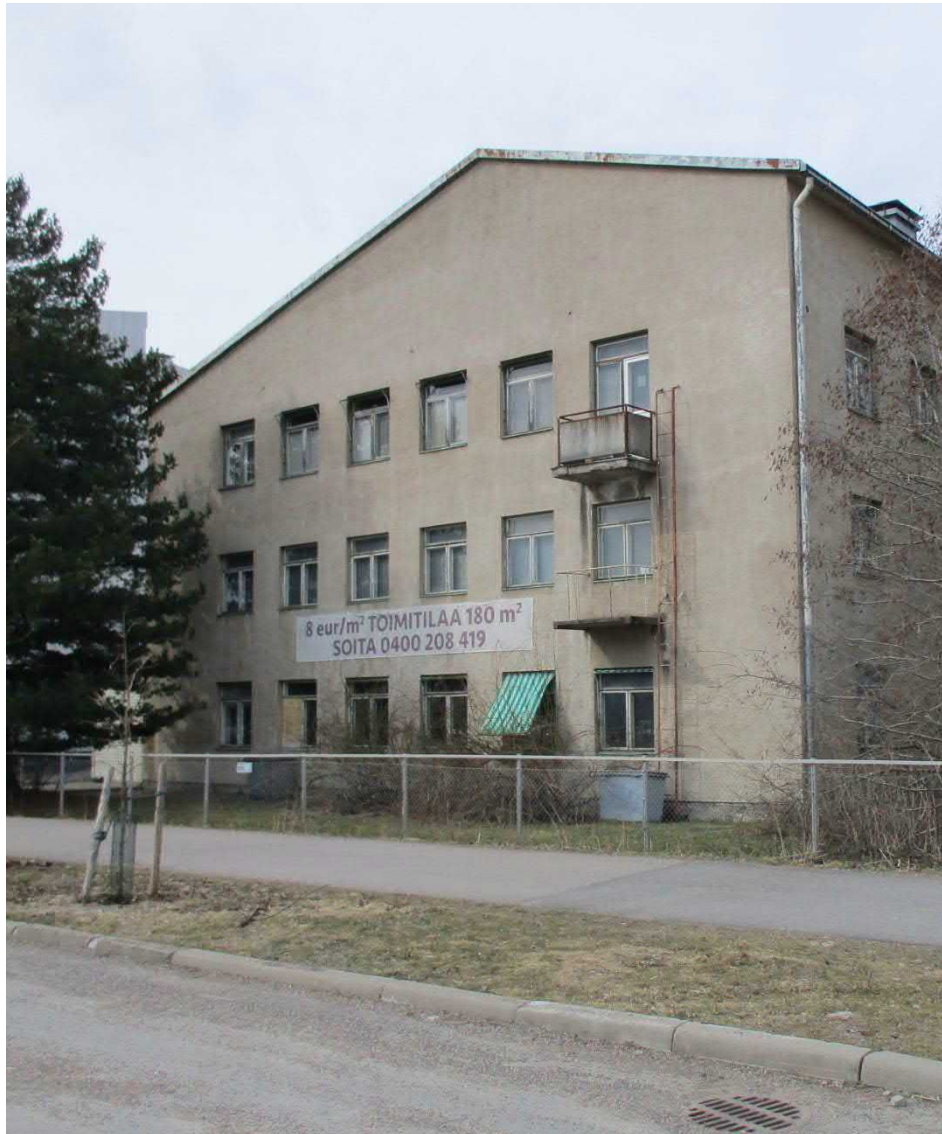
Kuva 55. Julkisivu kaakkoon. Parvekkeet on lisätty 1960-luvulla ja ne toimivat varapoistumistienä.
