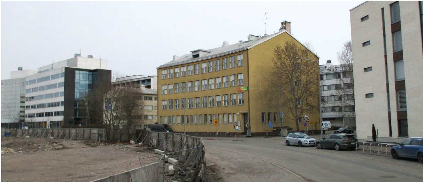
Kuva 31. Näkymä rakennukseen Kutomotie 6A luoteesta, tien länsimäisestä varresta.
