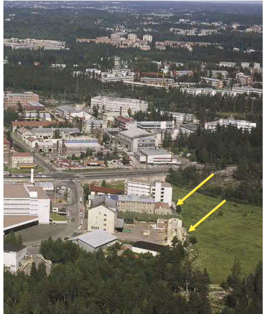
Kuva 10. Ilmakuva vuodelta 1965. Kutomotie 4-6 merkitty nuolella. Uudisrakennus 6B ei ole vielä rakenteilla. Kuvaaja Sky-Foto Möller. Lähde: HKM, Finna -palvelu (3.4.2023).
