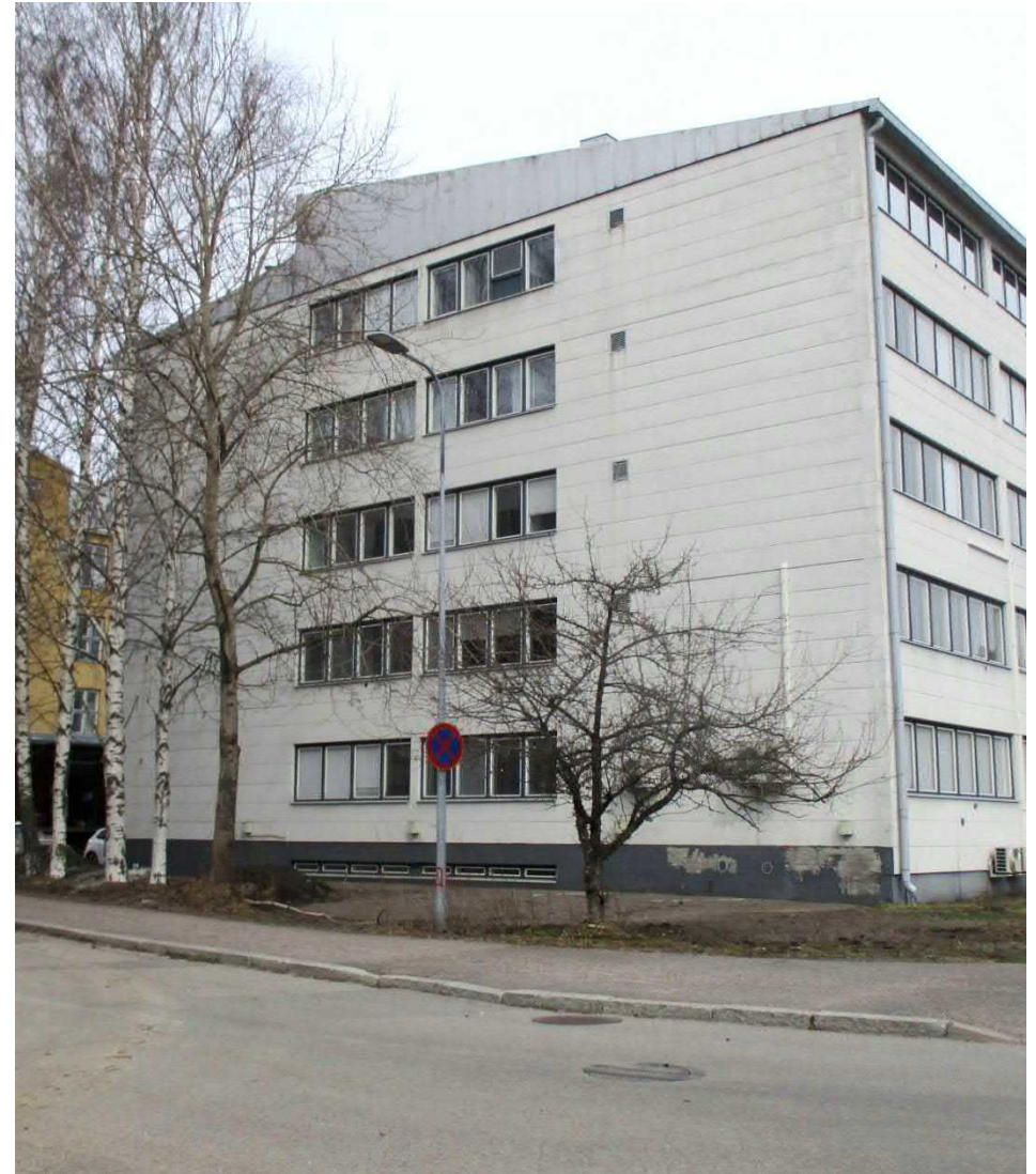
Kuva 76. Julkisivu lounaaseen. Näkymä Kutomokujalta. Ainoa muutos alkuperäisestä on viiden kerroksen ikkunan vaihto IV-säleiköksi.
