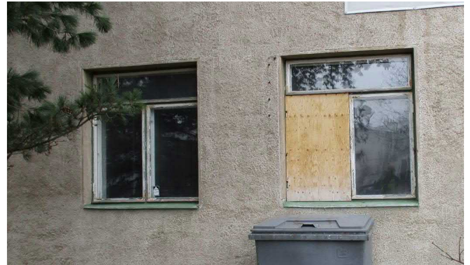
Kuva 63. Vanhan osan ikkunat (1950-luvun alusta).
