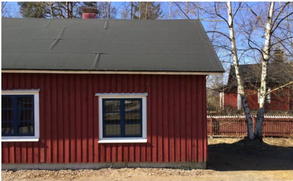
Vanha sauna on muutettu ponitalliksi
