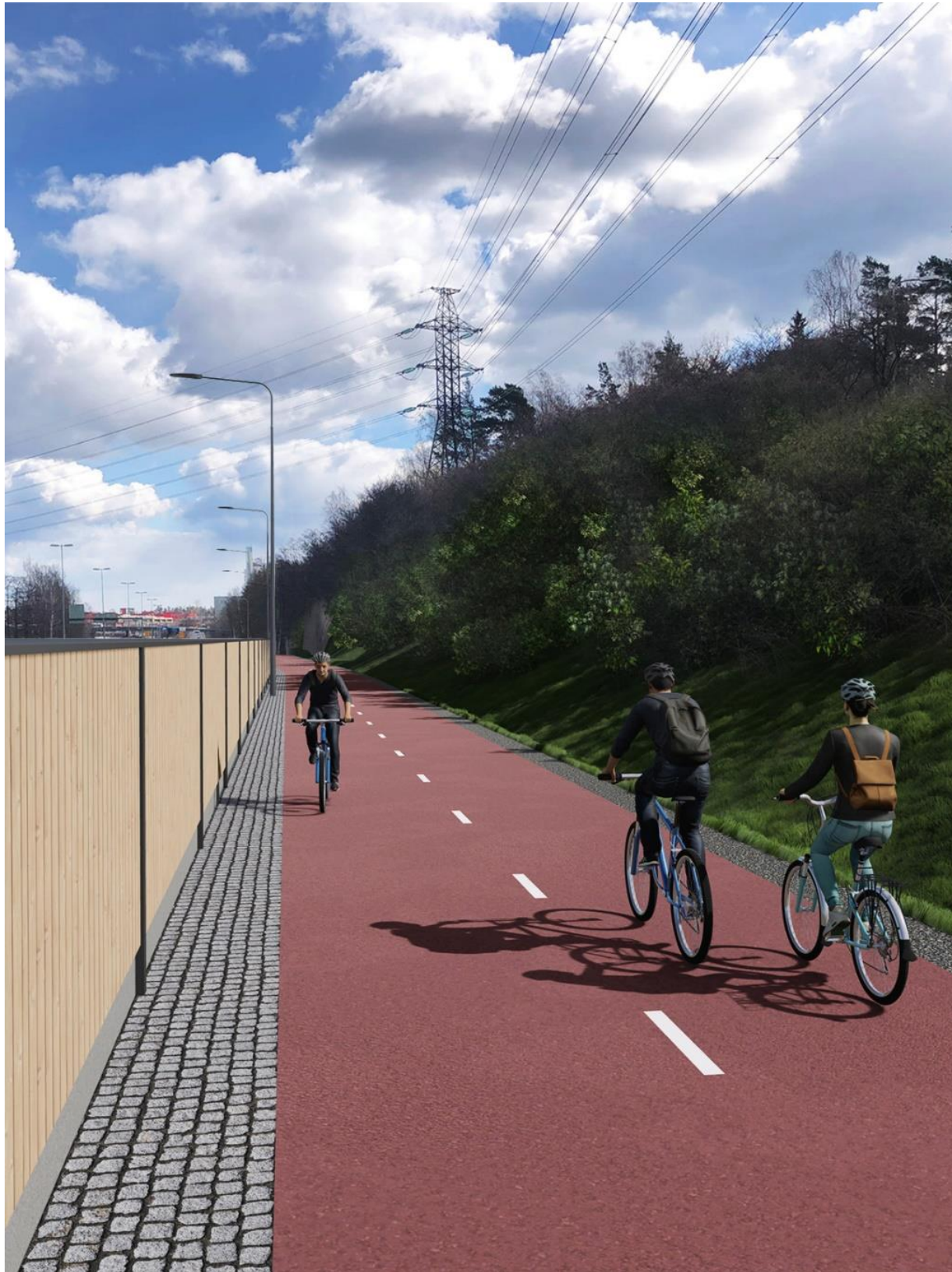
Kuva 29. Uusi pyörätie Itäväylän varrella suojataan meluseinällä, joka suojaa myös mm. roiskeilta (Ramboll)
