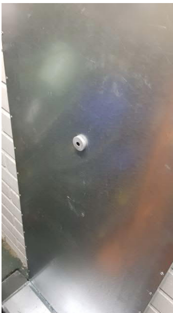
Kuva 3 Näytteenottopiste irroitettavalla tulpalla
