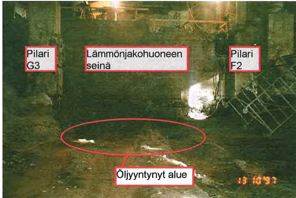
Kuva 2. Lämmönjakohuoneen edusta (Oy Teboil Ab/PTI-Soil Oy, 1997, raportin kuva 3)
