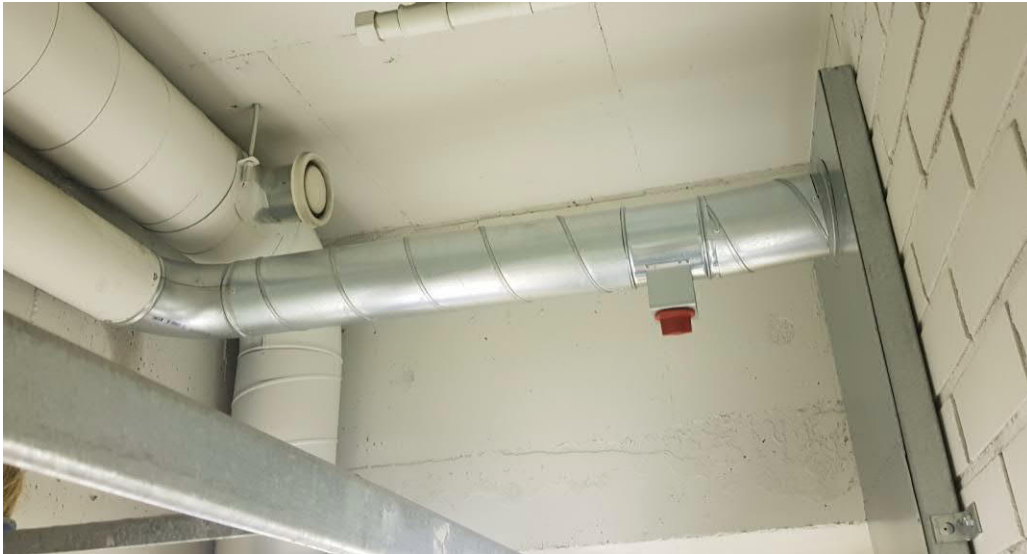
Kuva 4 Käsikäyttöinen sulkupelti vaakaosuudella sekä yhdistäminen jäteilmaan
