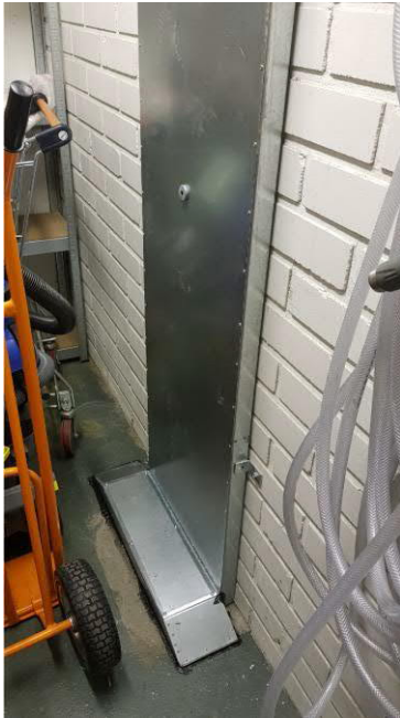
Kuva 2 Huokoisilmaputkiston kantikanavarakenne seinällä ja lattialla
