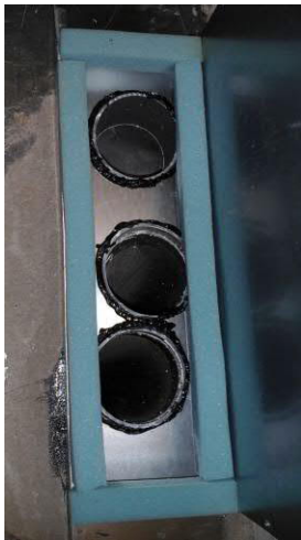
Kuva 1 Huokoisilmaputkisto tiivistetty lattianrajaan
