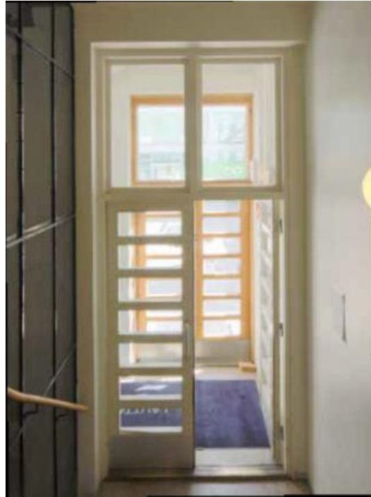
Pääsisäänkäynnissä on alkuperäinen tammiovi. Pääsisäänkäynti johtaa porrashuoneeseen. Tuulikaapissa on säilynyt kaksi alkuperäistä puu-lasiovea. Ovet on kunnostettu 1990.
