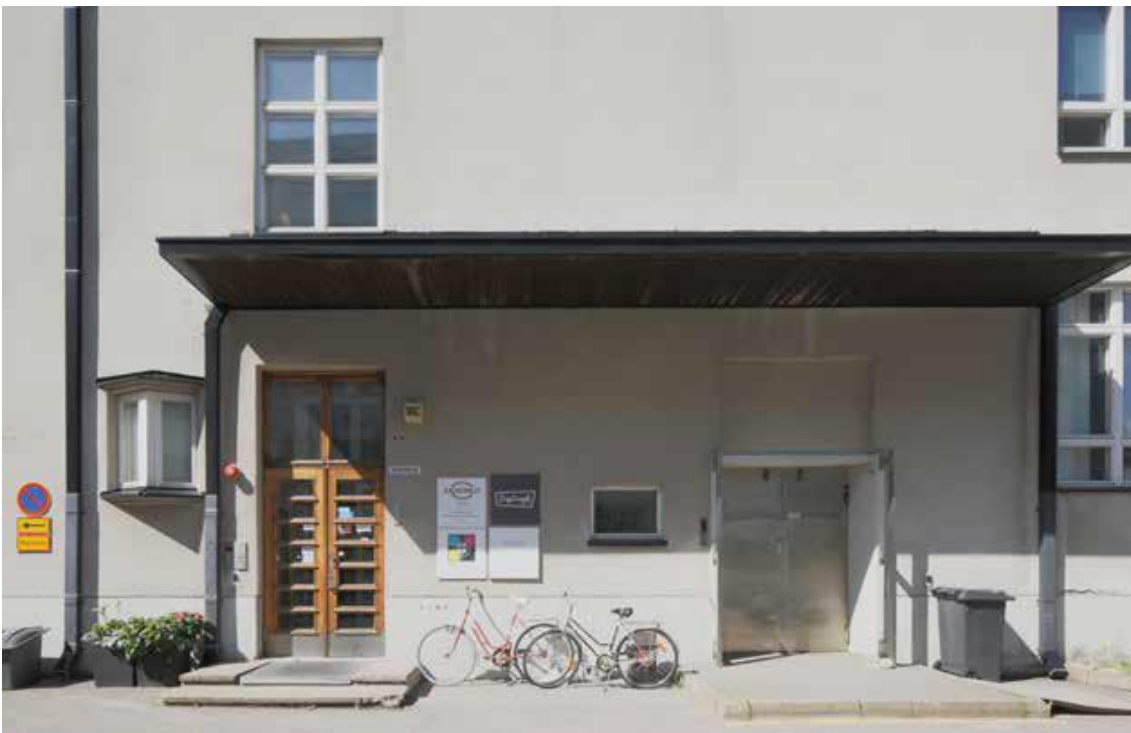
Pääsisäänkäynnin ja tavarahissin katos itäjulkisivulla. Julkisivussa on erkeri-ikkuna pääsisäänkäynnin vieressä. Tavarahissin edustalla ollut lastauslava purettiin 1965. Nyt siinä on betonikoroke.
