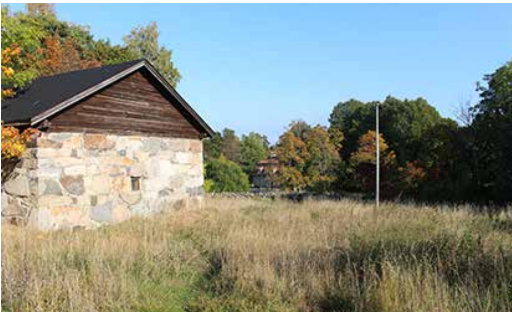
Kuva 109. Päärakennuksen ympärillä on kapea nurmena hoidettu alue. Rantavyöhyke päärakennuksen kohdalla näyttää olleen pengerretty.
