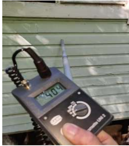
Ylempää seinä on kuiva
