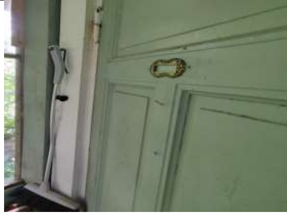
Ulko-ovet ovat ehjiä, eikä osissa ole havaittavissa muutoksia
