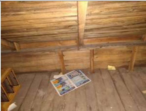
Kuva 15 Pitkän seinäosan vaakapanelointia, sekä kattorakennetta.
