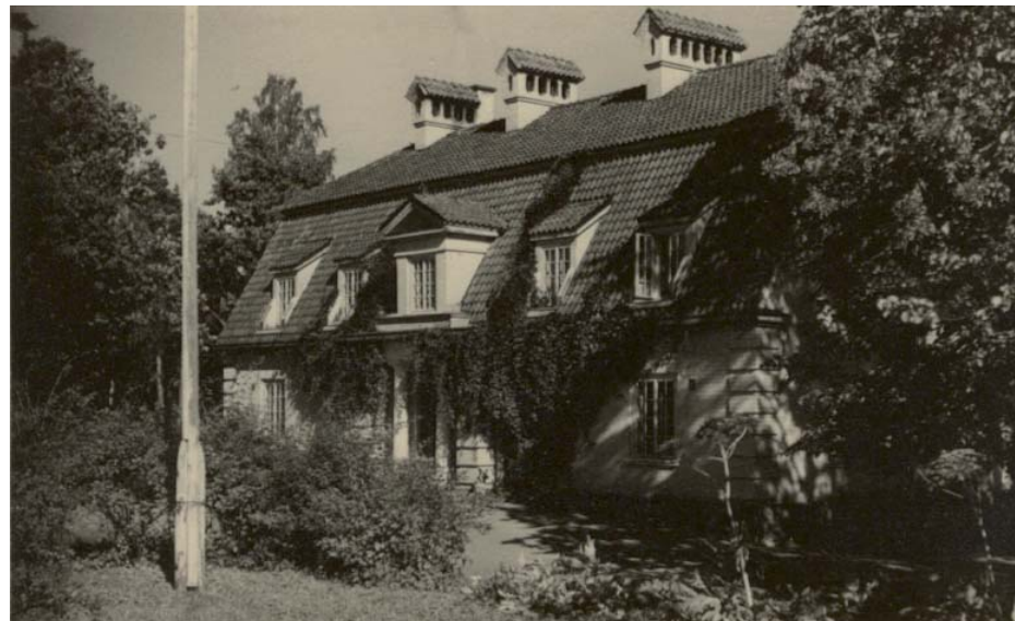
Jollaksen kartanon päärakennuksen luoteisjulkisivu pihalta päin nähtynä v. 1949. SOK:n kuva-arkisto.
