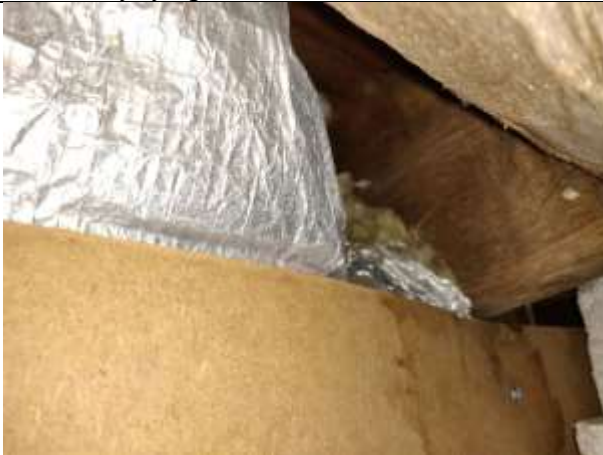
Kuva 3 Kotelointia rakennuksen ulkopuolella
