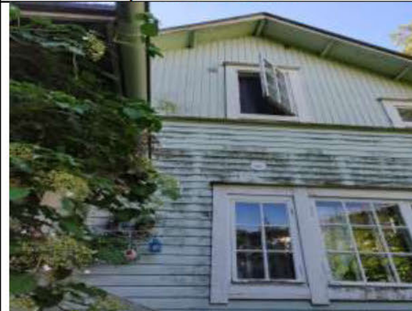
Kuva 21 Maalipinnat kuluneet, lisäksi ne ovat mustuneet orgaanisen lian vuoksi.
