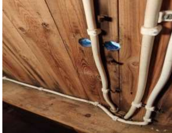
Kuva 14 Ullakon eristämätön päätyseinä
