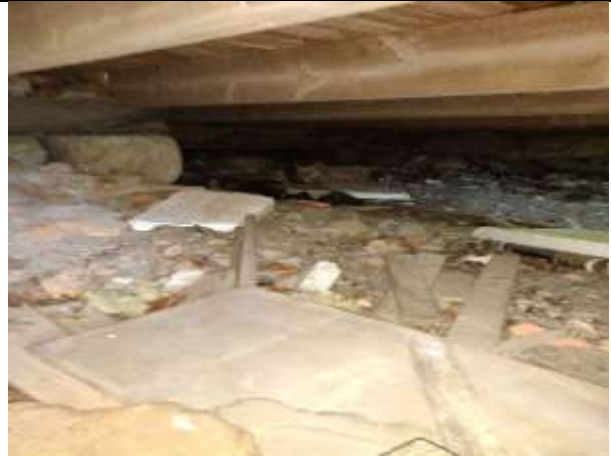
Kuva 2 Rakennuksen alapuoleista kannatinrakennetta.
