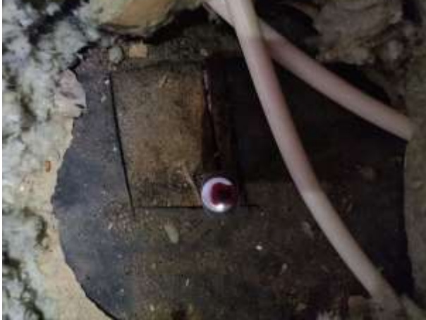
Kuva 7 Lattian alinpana osana bitumimaton alla on harva laudoitus (Kuvassa villaveitsi laudoituksen välissä)
