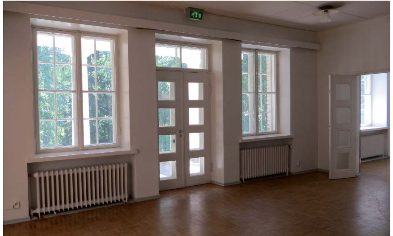
Ylhäällä vasemmalla salin ikkunaseinä ja ovi patiolle, oikealla ikkuna.
