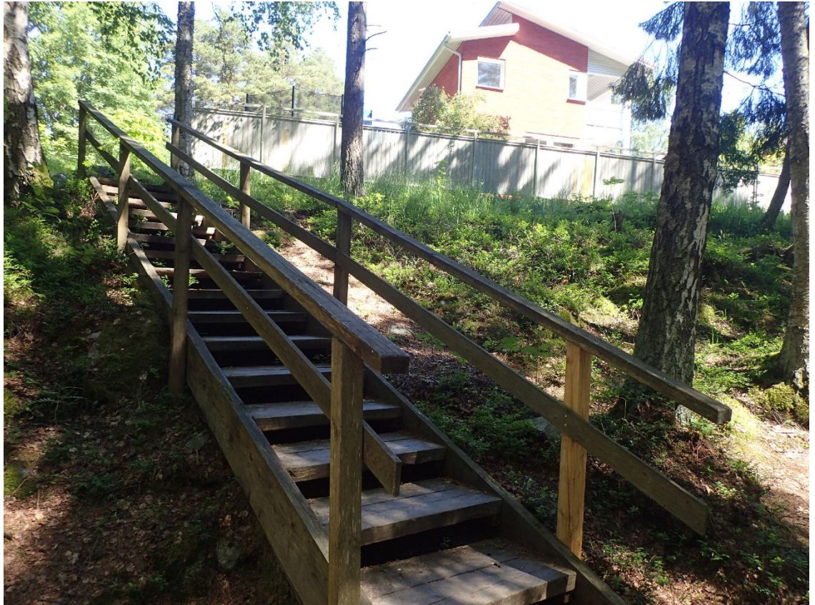
Kuva 22 Pohjoislaidan puuportaatt ovat hyväkuntoisia vuonna 2020, mutta niitä on tarpeen huoltaa ja mahdollisesti myös uusia tällä suunnitelmakaudella.
