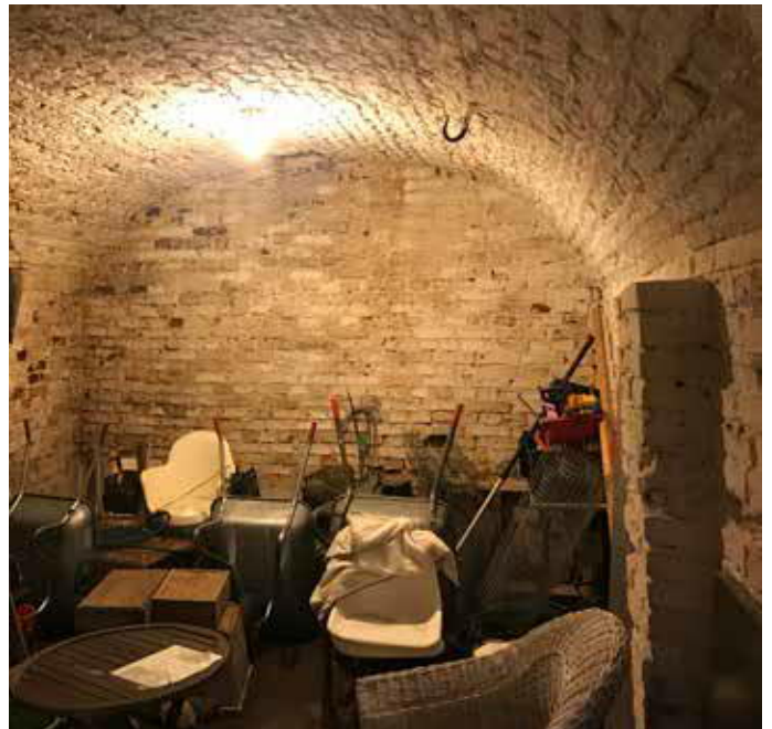
Jääkellarissa on rinnan kaksi tynnyriholvattua tilaa. Holvit on tiilimuurattu, lattia on kellariholveissa betonia, niiden edustan eteistilassa on tiililattia. AS.
