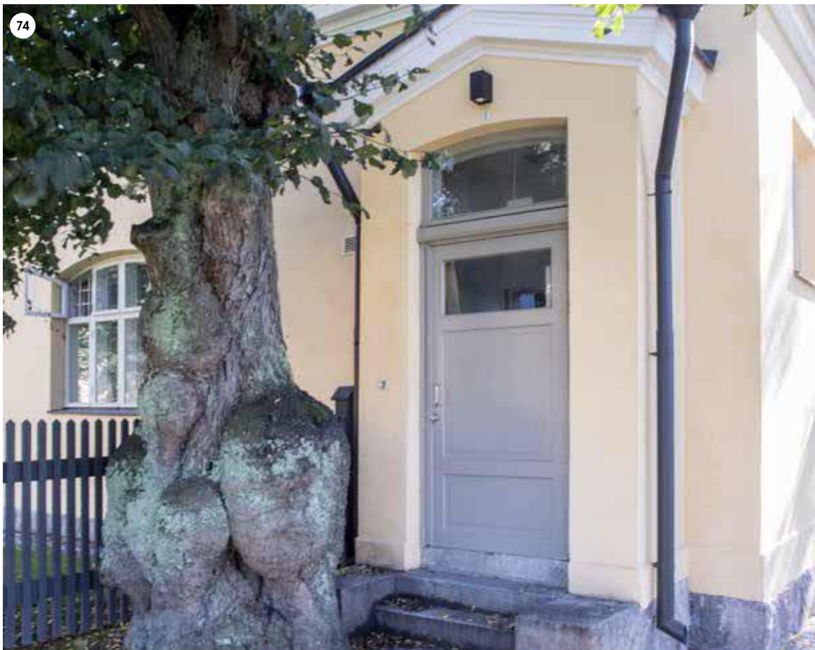
E-siiven pohjoisjulkisivun läntinen sisäänkäynti. Sisäänkäynti sijaitsi alun perin 1870-luvun suunnitteluratkaisussa idempänä, se siirrettiin lännemmäs 1900-luvun alussa, kun eristysosaston pää muutettiin kylpytiloiksi ja sille osoitettiin oma sisäänkäynti. Nykyinen ovilehti on melko uusi.
