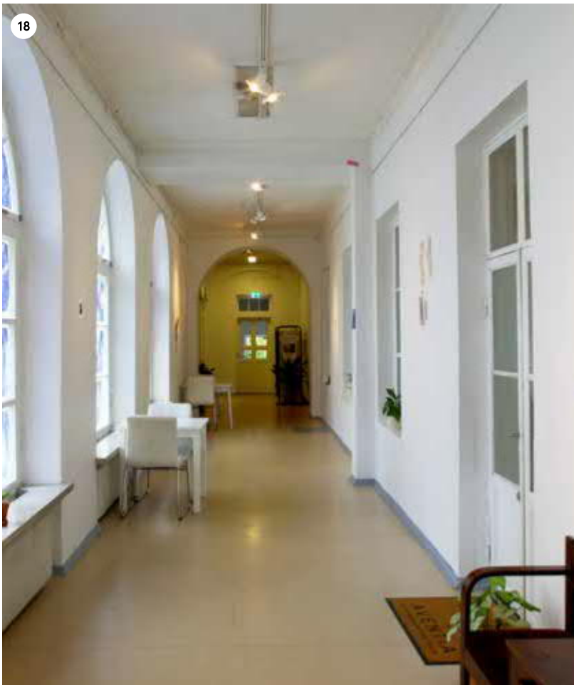
C-osan galleriakäytävän pohjoisosa, joka toimii galleriatilana. Näyttelytoimintaa varten käytävän pohjoispään seinät on maalattu vuonna 2017. Käytävän päässä oleva sisäänkäynti on 1800-luvun lopulta tai 1900-luvun alusta. Kuvan keskellä oleva, käytävätilan seinän ja katon kotelointi on myöhäinen lisä, päässä oleva kaariaukko on alkuperäinen.
