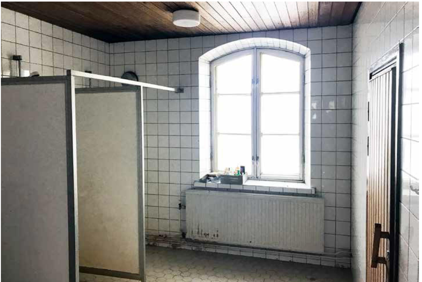
Saunatilan vasemmasta nurkasta on purettu suuri kiuas, sauna jaettu löyly- ja pesuhuoneen kesken ja pesutilat laatoitettu, kappaholvikatko peitetty puupaneelilla. AS.
