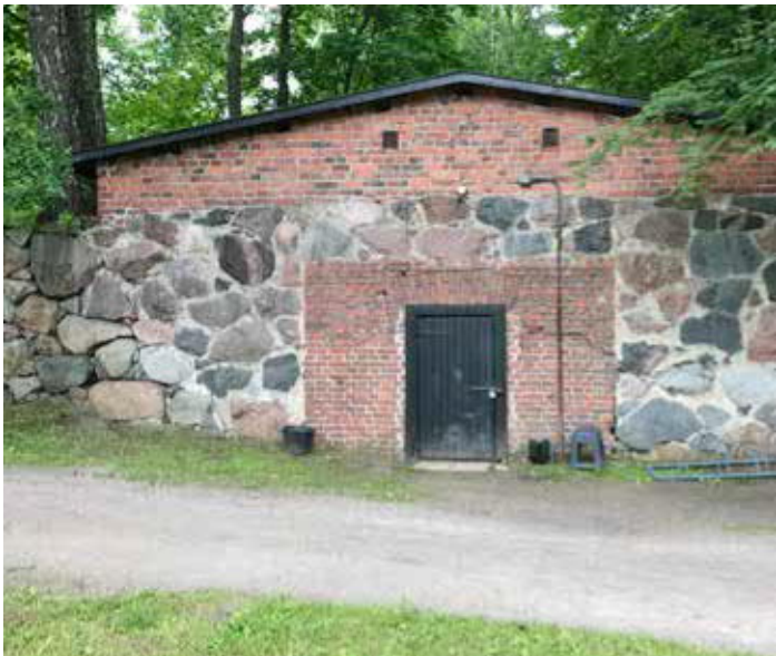
Jääkellari sijaitsee sairaala-alueen koillisosassa, rinteessä, ja se palvelee nykyisin palstaviljelijöiden varastona. Rakennuksen yläosa oli alun perin puuta ja päiväämättömässä inventointipiirustuksessa seinä koostuu säännönmukaisista kiviharkoista. Nämä viittaavat siihen, että julkisivua on uudistettu huomattavissa määrin. HY.
