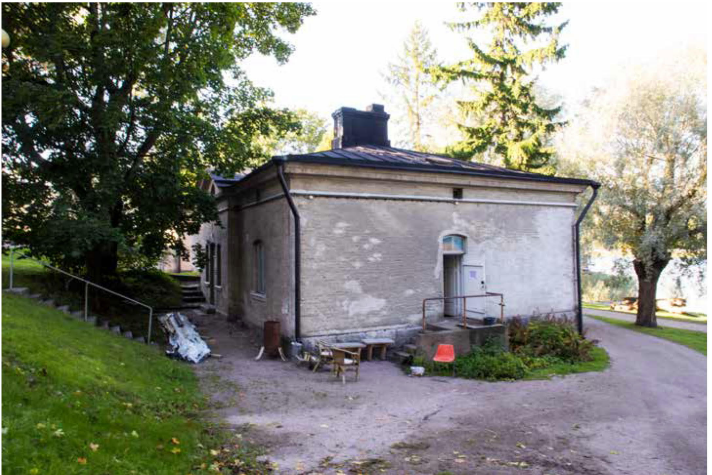
Saunarakennuksen alkuperäisen osan itäjulkisivu, johon lisättiin uusi sisäänkäynti 1930-luvun laajennuksen yhteydessä. Alun perin eteläjulkisivun pääsisäänkäynnille johtivat portaat, nyt maan pinnan taso on sisäänkäynnin tasalla. Rakennuksen ympäristön pinnanmuotoja korotettiin ilmeisesti 1930-luvun lisärakentamisen yhteydessä, jolloin rakennuksen eteläpuolelle sijoitettiin keskuslämmityksen pannuhuonetta palveleva korkea savupiippu.
