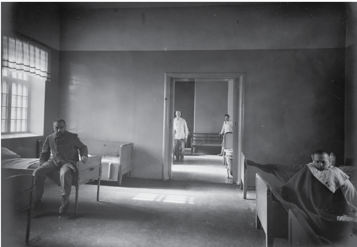
Tiloja yhdistettiin vastaavasti F-siivessä suurten valvontahuoneiden aikaansaamiseksi. Huoneiden välille puhkotussa oviaukossa on liukuovet, jotka on sittemmin poistettu ja oviaukko on suljettu. Huomaa myös potilashuoneiden pieniruutuiset ikkunat. Ikkuna-aukon koko vastaa nykytilaa, eli kuva on otettu sitten 1900-luvun alun, jolloin alkuperäinen aukotus palautettiin. Kuva on Lapinlahden sairaalan ylilääkärinä toimineen Christian Sibeliuksen valokuva-albumista. Helsingin yliopistomuseo.
