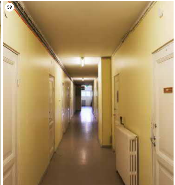
G-siiven kolmannen kerroksen käytävä on sekini kapea ja suhteellisen matala. Valoa käytävään antaa itäpäähän ikkuna. Huoneisiin johtavat ovet poikkeavat malliltaan F ja B-siipien kolmannen kerroksen huoneiden ovista. Siivessä G kaikki 1920-luvun ovet ovat systemaattisesti puisia peilliovia, joiden peilien päät on lovettu.
