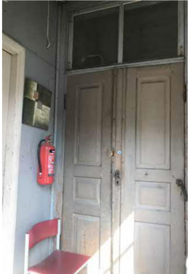
Puusepänerstaan eteläpuoleinen katettu kuisti, jonka pohjoispuolella on kaksilehtinen alkuperäinen peiliovi, jossa on säilynyt alkuperäiset helat. Vastaava ovi on rakennuksen pohjoisjulkisivun sisäänkäynnissä, eteläjulkisivun oveen on ulkopuolelle lisätty uusi panelointi. Kuvan oven yläpuolista ikkunaa on muutettu. AS.
