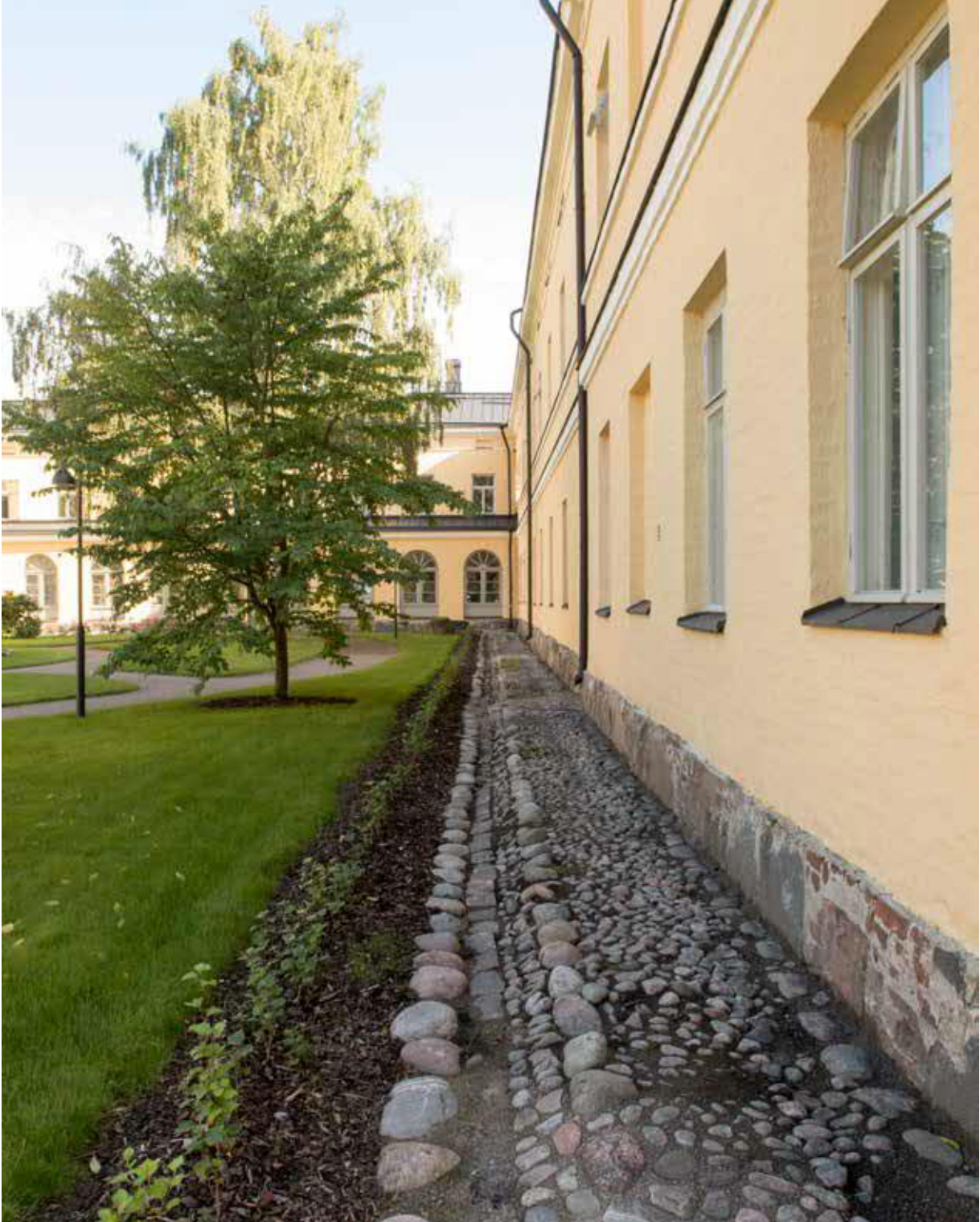
F-siiven pohjoisjulkisivu. Sokkelin edustalla oleva kiveys kunnostettiin vuosien 2016–2017 korjaustöiden aikana.
