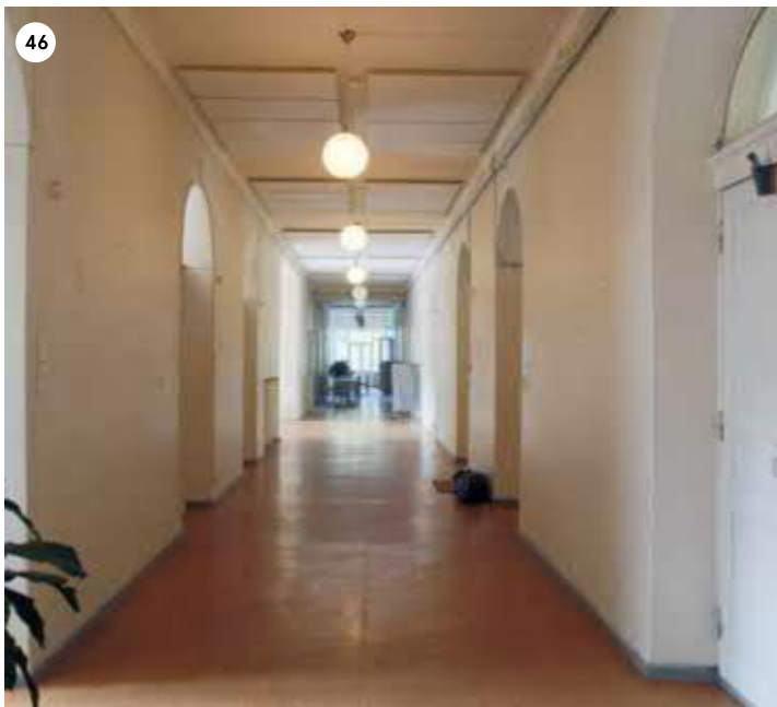
F-siiven toisen kerroksen käytävä kohti länttä. Potilashuoneiden ovien paikat ovat alkuperäisillä paikoillaan, pois lukien käytävän keskelle, sen eteläpuolelle, avattu päivähuone, jonka tieltä purettiin kahden huoneen käytävänpuoleinen seinä oviaukkoineen. Käytävän päässä on 1980-luvun puu-lasiseinä. Kattokorkeus on alkuperäinen, kattopintaan on lisätty akustolevyt. Osa ovilehdistä on siirretty karmin käytävänpuoleiseen pintaan, jotta huoneen sisäpuolelle on voitu lisätä toinen ovi. Myös oven yläpuolinen lunetti-ikkuna on muutettu tuplaikkunaksi.
