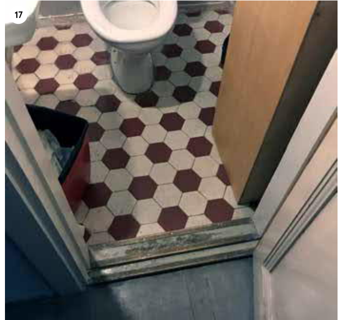
C-osan ensimmäisen kerrokseen, alun perin kappelin olleeseen tilaan, sijoitettiin 1920-luvulla wc-tiloja, joiden klinkkerilaattalattiat ovat säilyneet tähän päivään asti. AS.
