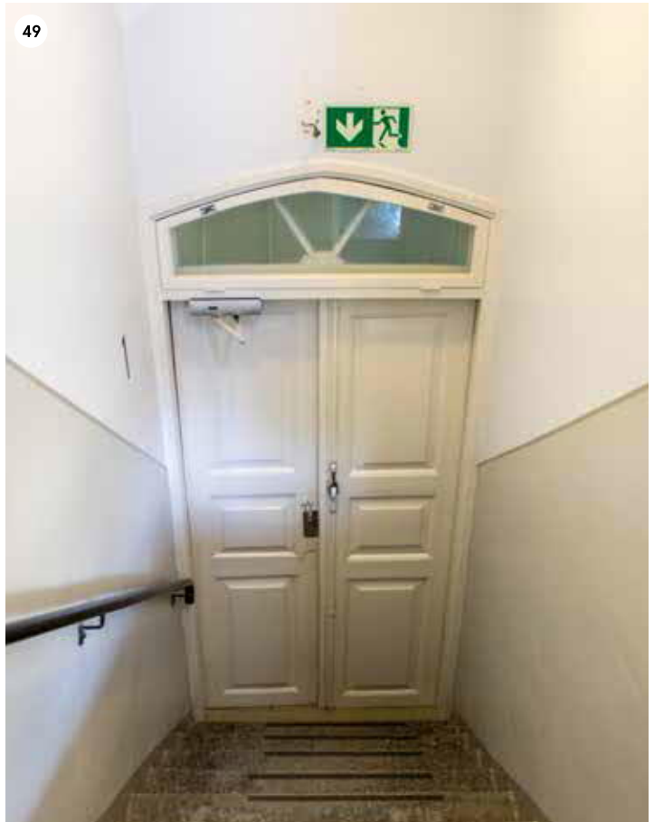
F-siiven länsipään portaissa ei ole kerrostasanteita, vaan porras on suorassa yhteydessä kerrosten käytäviin. Portaana ja käytävän välissä on kaksilehtiset puuovet, jotka poikkeavat potilashuoneiden ovista vähäisissä määrin.
