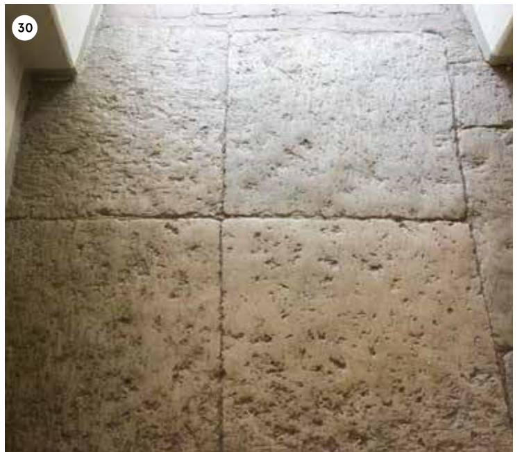
C-osan pohjoispään paraatiportaassa ja eteläisen keittiöportaан alatasanteen porraskäytävässä on käytetty suurta kivilaattaa.
