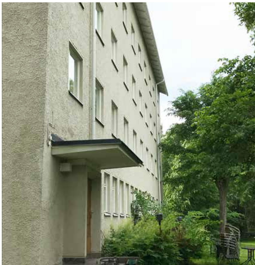
Rakennuksen länsijulkisivun pohjoispäässä on sisäänkäyntikatos, joka on lähellä alkupe- räistä arkkitehtonista asua. Sisäänkäyntiovi on vaihdettu alkuperäisen kaltaiseksi tammio- veksi, jossa on lämpöläsi. HY.
