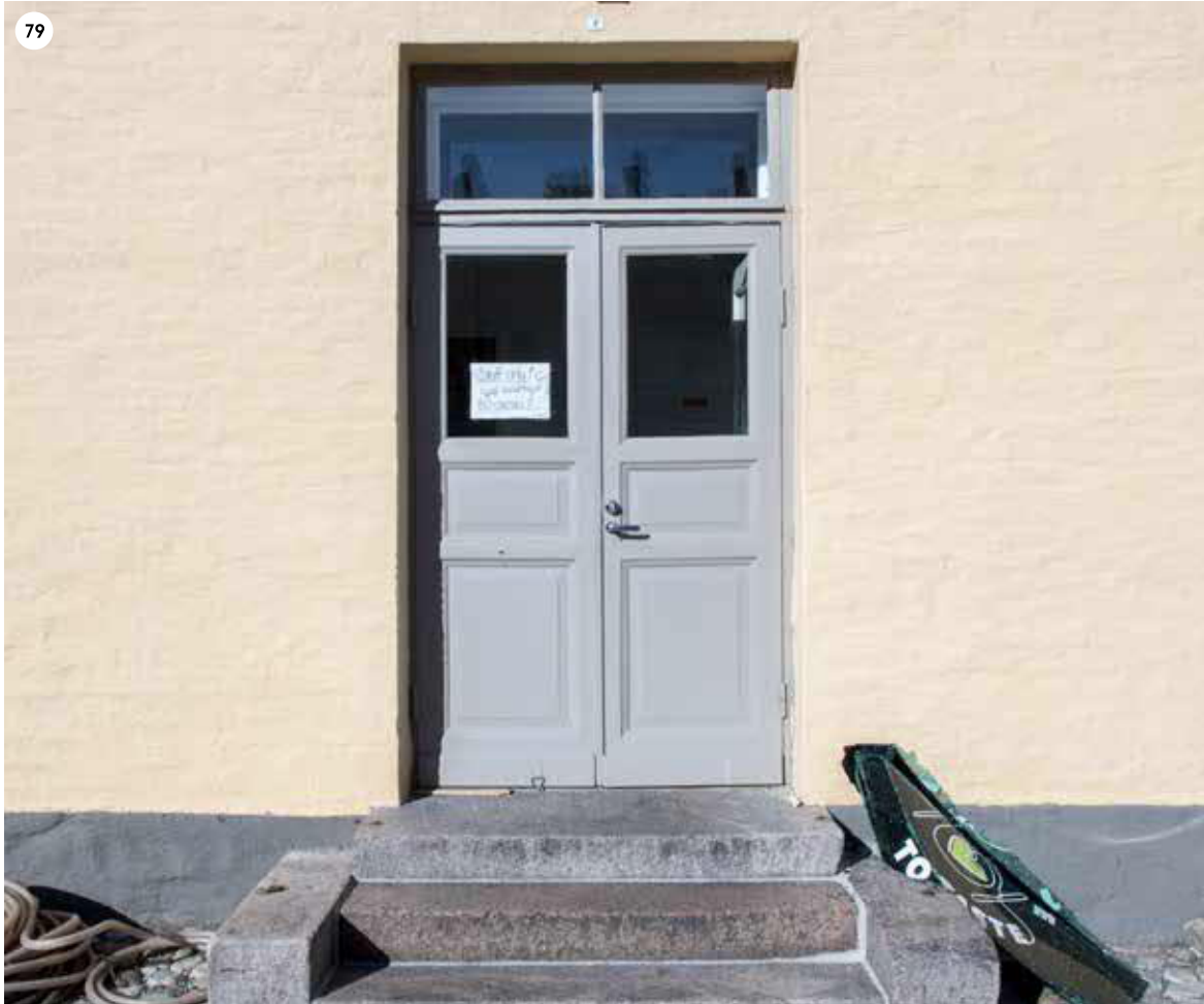
Osan D eteläisen julkisivun sisäänkäynti. Ovi-ohjelmat on uusittu.
