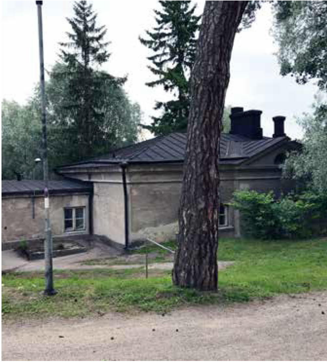
Alkuperäisen saunarakennuksen länsipuolelle rakennettiin 1930-luvulla matala nivelosa, jonka eteläpuolelle sijoittui piippu. Piippu on purettu, merkinä sen sijainnista on nivelosan edessä betonikoroke. HY.
