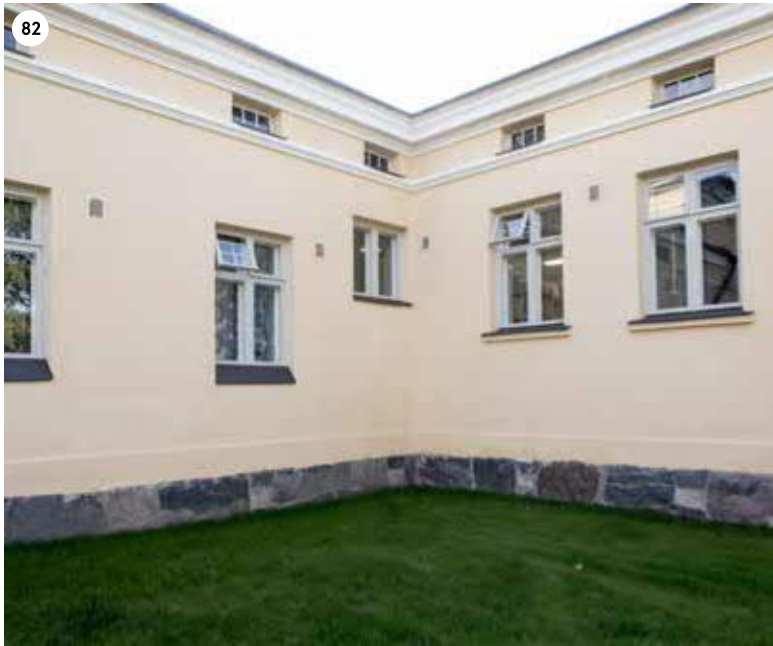
A-osan pohjoisjulkisivun läntinen osa. Myös tässä siivessä on säilynyt yksi eristys- huoneen ikkuna alkuperäisessä koossa ja korkeudella.
