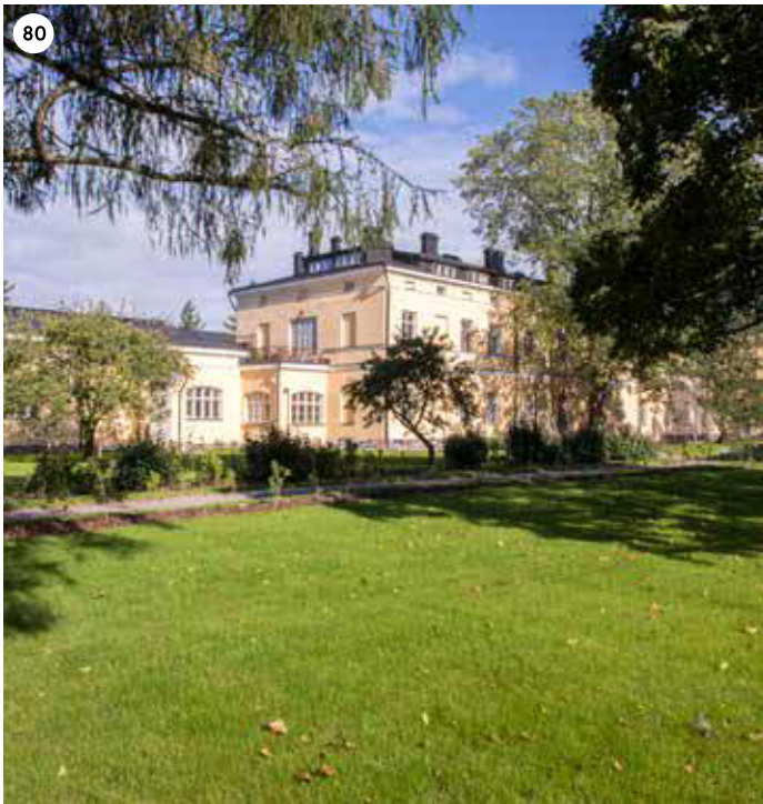
Siivet A ja B kuvattuna läntisen sisäpihan puolelta. Siiven A eteläjulkisivuun lisättiin yläosastaan kaarevia ikkunoita sitten 1870-luvun alkuperäisen suunnitteluratkaisun. Siiven B länsijulkisivussa oli alun perin venetsialaiset ikkunat, joita muutettiin 1870-luvun lisärakentamisen myötä ja 1920-luvulla kun toisen kerroksen päähän lisättiin terassi.
