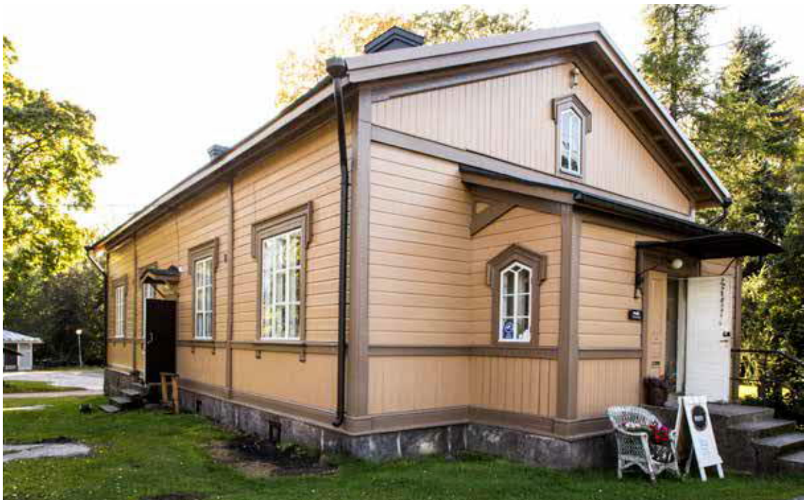
Puusepänerveaan pohjois- ja itäjulkisivu maalipinnan uusimisen jälkeen 2017. Rakennuksen pohjoisen sisäänkäynnin yllä oleva lippa ei esiinny alkuperäispiirustuksissa. Se on kuvattu vuoden 1945 piirustuksissa, joissa on myös itäjulkisivun sisäänkäynnin yllä oleva katos esitetty suorana.
