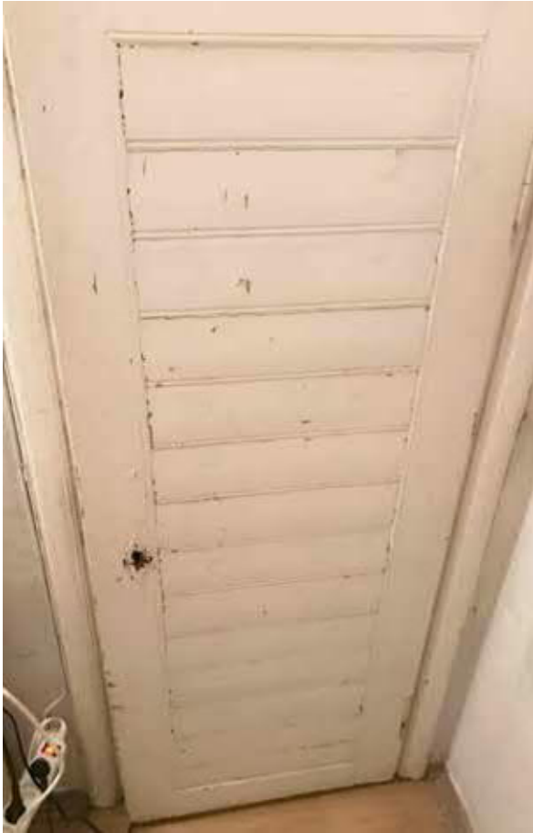
Puusepänerstaan alkuperäisessä komeron ovessa on keskellä helmiponttipaneeli. Yksi komero sijaitsee alkuperäisellä paikallaan pohjoispuolen kuistilla, toinen rakennuksen eteläosissa portaiden alla. AS.
