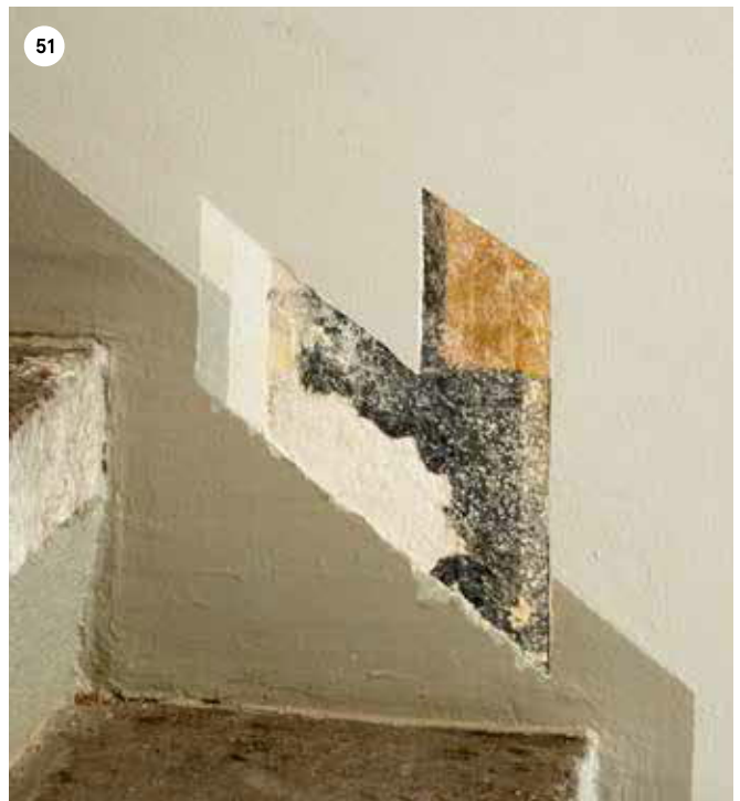
F-siiven länsipään portaiden askelmat ovat ensimmäisen ja toisen kerroksen osalta päällystetty kalkkikivellä. Alun perin kivilaatan reuna oli luultavasti pyörästetty, kuten muissa portaissa, mutta reuna on sittemmin leikattu suoraksi. Seinässä on otettu esiin vanhoja värikerroksia.
