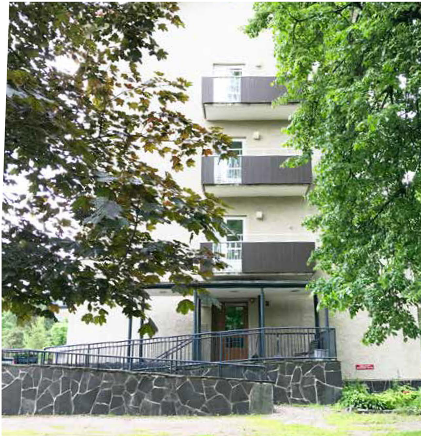
Koivulan pohjoisjulkisivu, johon kohdistuivat suurimmat muutostoimet 2000-luvun alussa. Uusi sisäänkäyntikatos ja liuska muodostavat raskaan rakenteen, joksinkin se on tyyllisesti pyritty sovittamaan vanhaan. HY.
