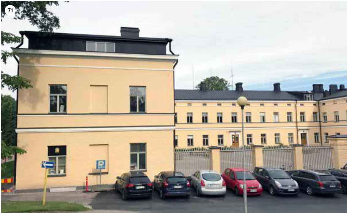
Sairaalan päärakennuksen itäjulkisivun eteläinen osa. Samalla kun G-osaa korotettiin 1920-luvulla, alkuperäistä kattomuotoa muutettiin. Pystysuoran korotuksen ansiosta ullakkokerrokseen tuleville huonetiloille ei tarvinnut rakentaa erillisiä kattolyhtyjä. HY.
