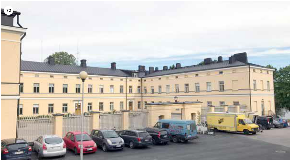
Sairaalan päärakennuksen itäjulkisivun pohjoinen osa. Kattolyhty on 1910-luvulta. HY.
