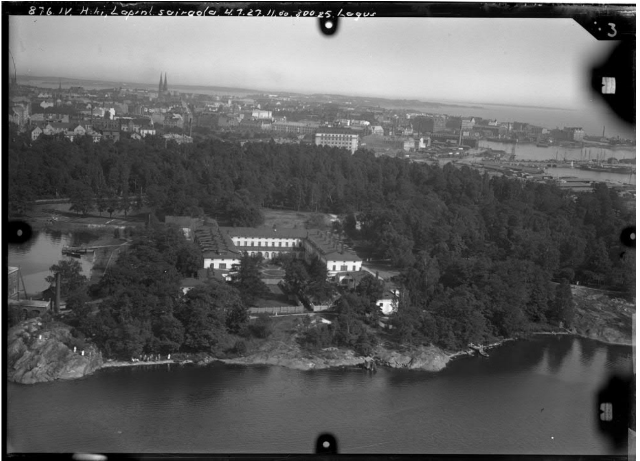
1920-luvun viistoilmakuva sairaala-alueesta, kuvattuna mereltä kohti itää. Kuvan vasemmassa laidassa etualalla on Venetsia-rakennukseen 1900-luvun alussa rakennetun sähkölaitoksen piippu. 1800-luvun lopun karttaan on merkitty päärakennuksen osan E länsipuolelle rantaviivaan jätevesikanavan suuaukko. Se jää kuvassa hiekkarannan oikealla puolelle. Se, miten pitkään kyseinen kanava oli käytössä, ei ole tiedossa. Ilmavoimien kuva-arkisto.
