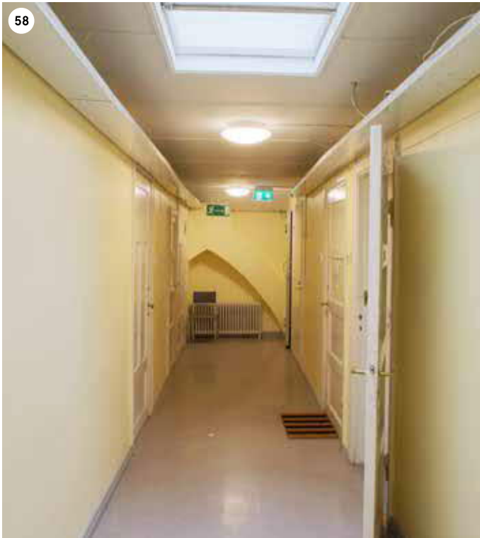
F-siiven kolmannen kerroksen käytävän länsipäässä on tiilimuurattu ja rapattu hormin paikka, jonne on sijoitettu 1920-luvun ripapatteri.
