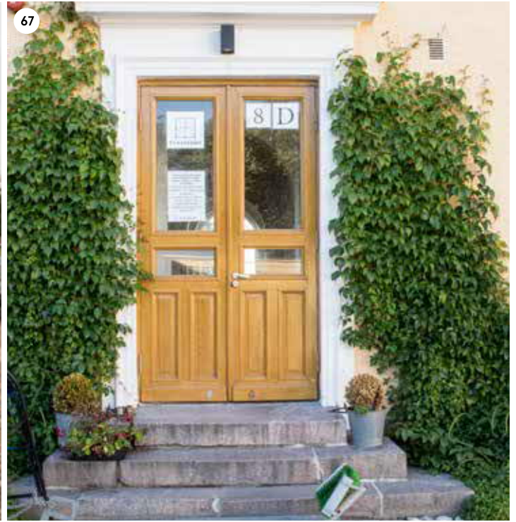
Itäjulkisivun keskimäinen pääsisäänkäynti. Kaikki sisäänkäynnit on kunnostettu vuoden 2017 aikana. C-osan itäjulkisivun kolmen sisäänkäynnin ovilehdet ovat pitkälti toistensa kaltaisia, pääsisäänkäynnissä on ovilehtien keskipeili lasia, kun sivusisäänkäynneissä keskipeili on umpinainen. Keskimäisen oven läpi näkyy rakennuksen poikki, sillä akselin päässä on galleriakäytävän ovi läntiselle sisäpihalle.
