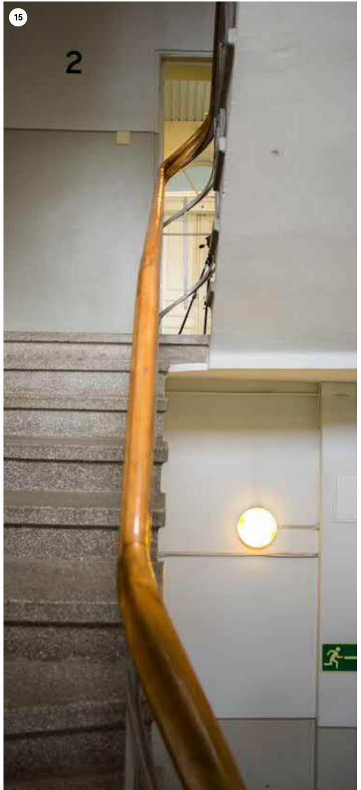
B-siiven länsipään portaikon porrassyöksen alapinta ja kerrostasanteiden alakatot ovat suoria, sileäksi rapattuja ja maalattuja. Portaan sisäkaaren puolella on nelikulmaisista metallipinnoista koostuva metallikaide, jonka päällä on puinen käsijohde.
