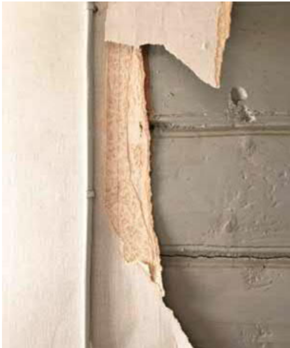
Puusepänerstaan seinissä oli helmiponttipaneelia. Panelointi jäi sittemmin piiloon tapettikerrosten alle. Kuva on rakennuksen eteläpuoleisesta käytävätilasta. AS.
