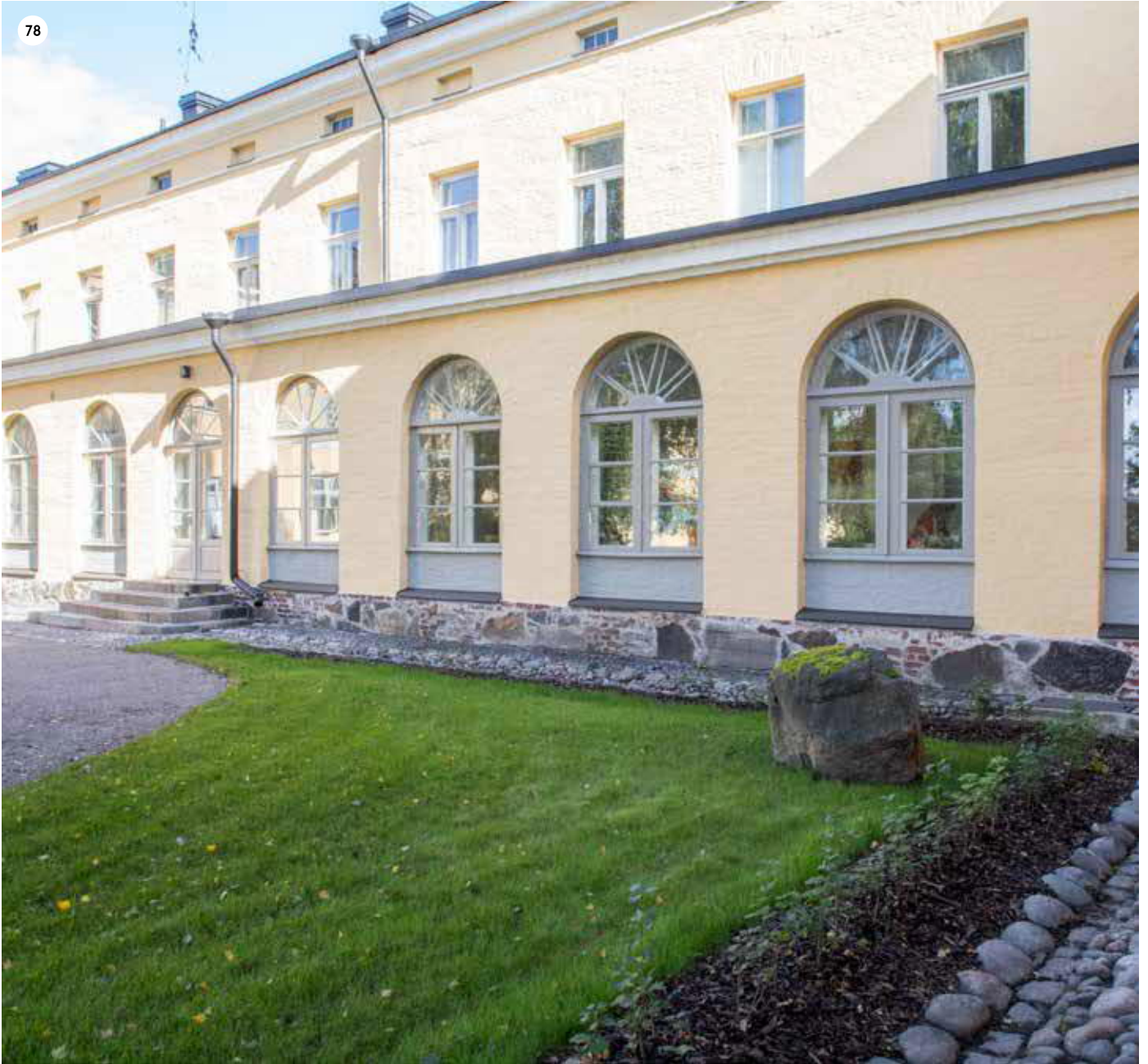
C-osan galleriakäytävän länsijulkisivu. Ikkunoita on muutettu alkuperäisestä. Länsipihan sokkelinviereinen kiveys uusittiin vuonna 2017, jotta sadavedet saatiin johdettua tehokkaammin pois rakennuksen vierustoilta. Julkisivun kunnostustöissä puhdistettiin myös sokkeli.
