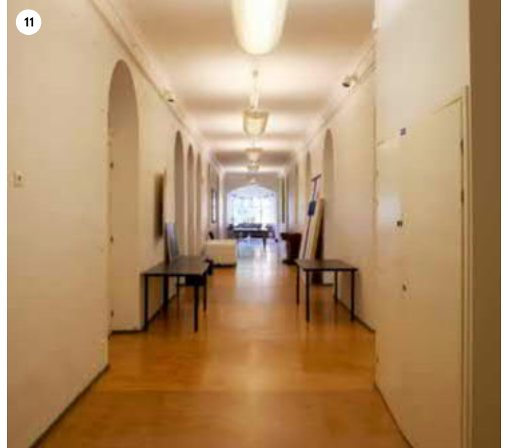
B-siiven ensimmäisen kerroksen käytävän länsiosassa on pääosin alkuperäiset seinäpinnat. Alkuperäiset ovet sijaitsivat kaarisyvennyksissä ja käytävän eteläpuolelle on muodostettu kahdesta huoneesta yhdistämällä uusi päivähuone, joka avautuu käytävään kolmen ovettoman kaariaukon kautta. Käytävän päässä olevan kaariaukon tilalla oli alun perin oviaukko ja sen kummallakin puolella ikkuna, nyt käytävä jatkuu lännemmäs 1870-luvulla rakennettuun ikkunalliseen nivelosaan.
