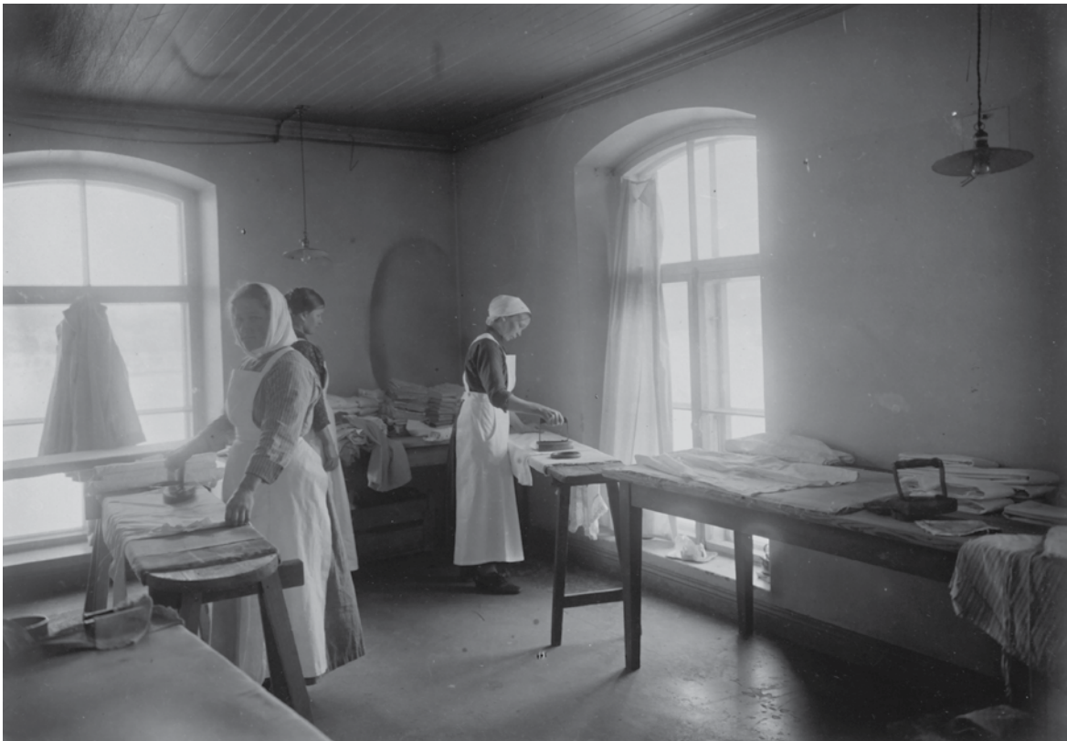
Silitystyö käynnissä Venetsia-rakennuksen toisessa kerroksessa 1900-luvun alussa. Kuva on Lapinlahden sairaalan ylläkäarinä toimineen Christian Sibeliuksen valokuva-albumista. Helsingin yliopistomuseo.
