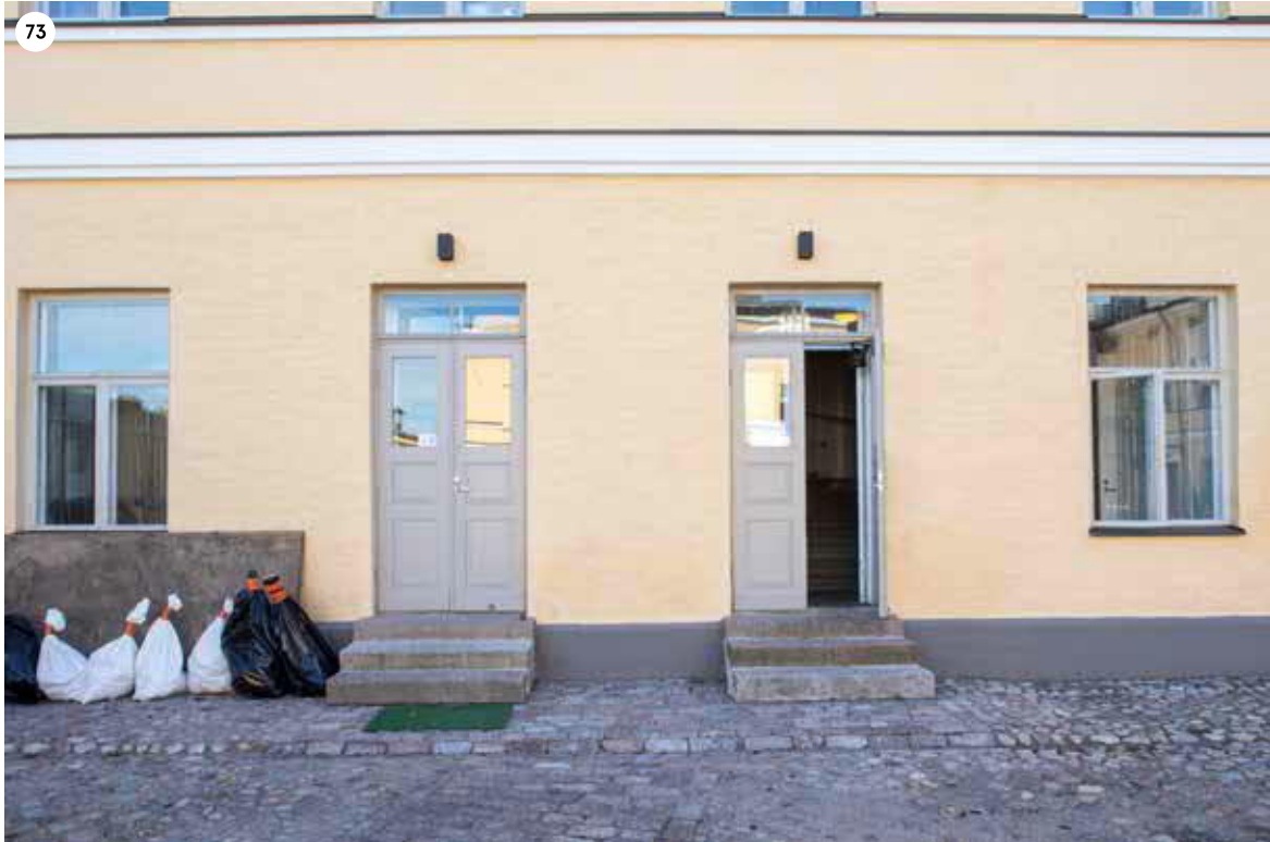
Osan G pohjoisen julkisivun kaksi vierekkäistä sisäänkäyntiä. Ovilehdet on uusittu ja portaat eivät ole alkuperäisen suunnitteluratkaisun mukaisilla paikoilla.
