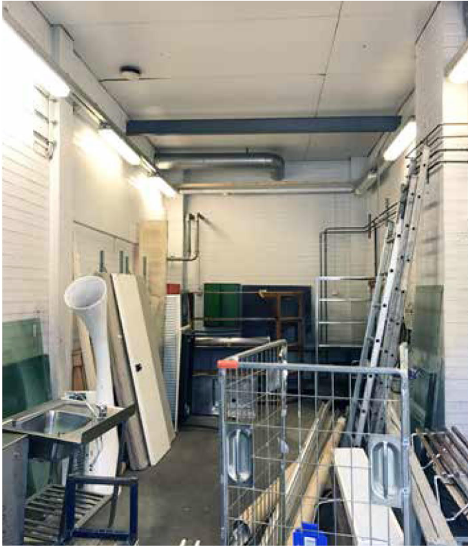
Saunarakennuksen länsipuolelle 1930-luvulla rakennettu lisäosa oli alun perin yksi suuri hallimainen tila, 1980-luvun lopussa tila jaettiin sitä kantaneiden pilareiden kohdalta huonetiloihin. AS.
