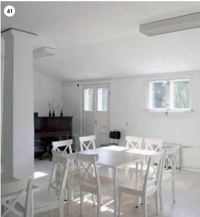
Kolmannen kerroksen pylvässali osassa C rakennettiin 1920-luvulla yhtä aikaa G-osan kolmannen kerroksen kanssa. Sali on saanut nimensä sen keskellä olevasta puisesta pylväästä. Huoneen lattiapinta on uusittu. Ikkunat ovat ilmeisesti 1940-luvulta. Niiden alla on puinen ikkunalaiva, jossa on muotoiltu konsoli. Huoneen kanssa samaan aikaan rakennetulle parvekkeelle johtavissa ovissa on päistään lovetut puupeilit. Patterit ovat 1920-luvulta.
