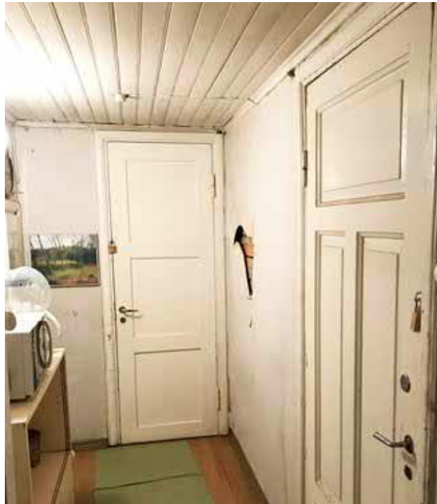
Rakennuksen eteläpuolelta käytävätila, jota on lyhennetty ja kaivettu alkuperäisestä. Huoneessa on pinkopahvi, jonka alta pilkistää alkuperäinen helmiponttipaneeli. AS.
