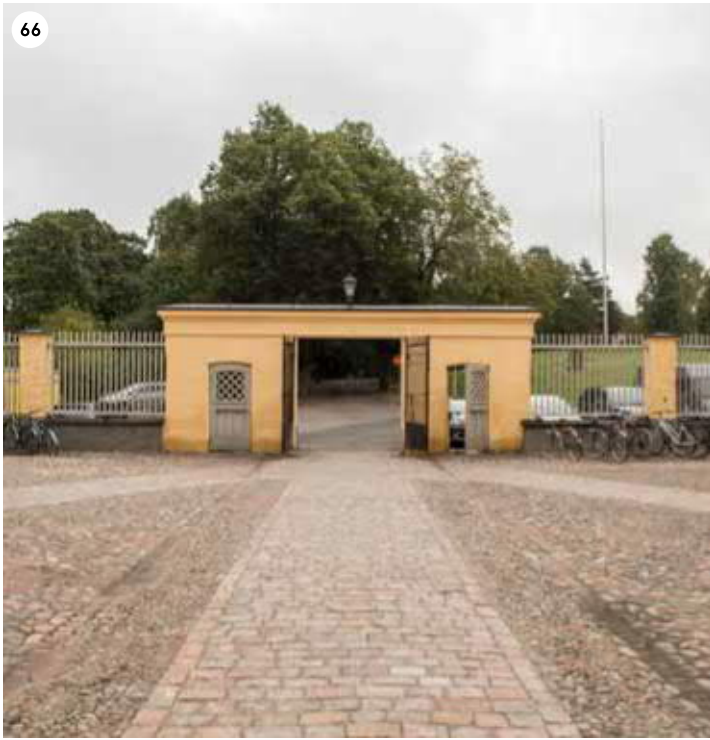
Sairaalan päärakennuksen itäisen sisäpihan sulkeva portti ja vuonna 2017 esiin otettu, osin rekonstruoitu pihakiveys.
