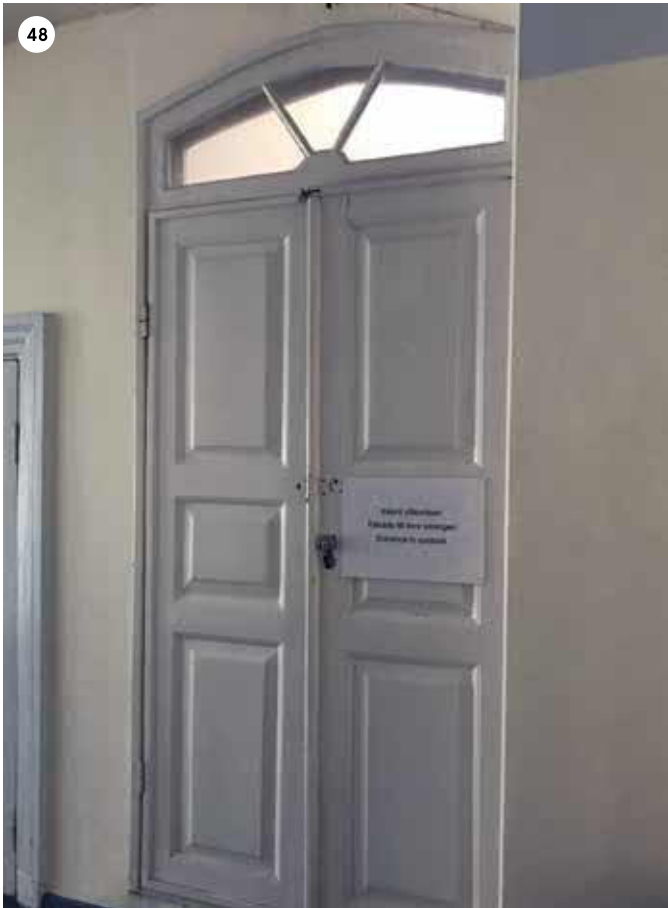
F-siiven länsipään portaaseen johtavan oven yllä on ensimmäisessä kerroksessa kapea, pyörästettyreunainen lasiosa. HY.
