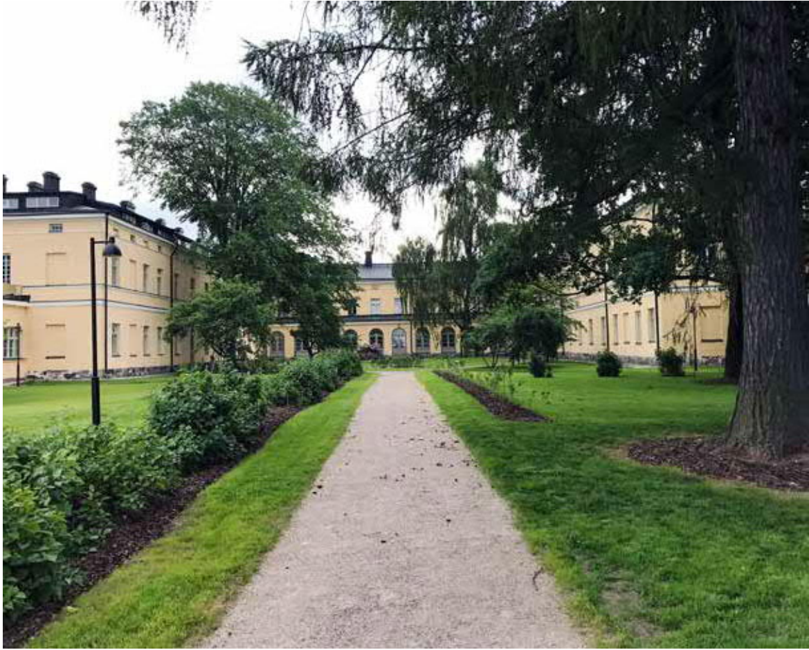
Päärakennuksen länsijulkisivu on polveileva. HY.
