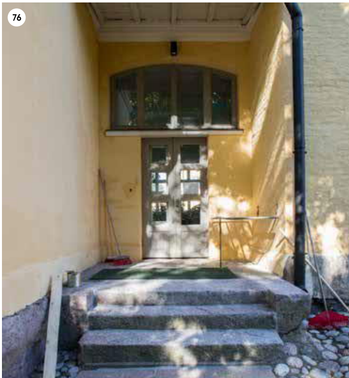
Siipiä E ja F yhdistävän nivelosan sisäänkäynti. Alun perin sisäänkäynnille oli portaat, 1920-luvulla sen edustalle rakennettiin sisäänkäyntitaso. Nykyiset ovilehdet ovat todennäköisesti 1930-luvulta, puinen katos on mahdollisesti tehty 1990-luvulla vesikaton uusimisen yhteydessä.
