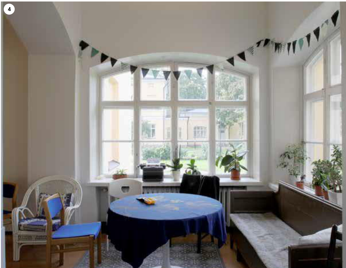
1870-luvulla rakennettu nivelosa siipien A ja B välillä yhdistää kummankin rakennusosan linjaukset toisiinsa. B-siiven jatkoksi tehdyssä osassa on ikkunat kahdella seinällä, ja osa yhdistyy B-siipen alkuperäiseen ulkoseinään puhkaistun suuren kaariaukon kautta. Pohjoisseinässä, joka ei näy kuvassa, on A-siipeen johtava oviaukko ja siinä on moderni ovi.
