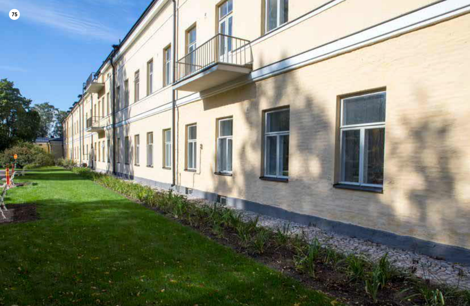
Sairaalarakennuksen eteläjulkisivu. Parvekkeet on lisätty julkisivuun 1920-luvun loppuun sijoittuvassa vaiheessa, jossa osaa G korotettiin ja kolmannen kerroksen tilat otettiin käyttöön.
