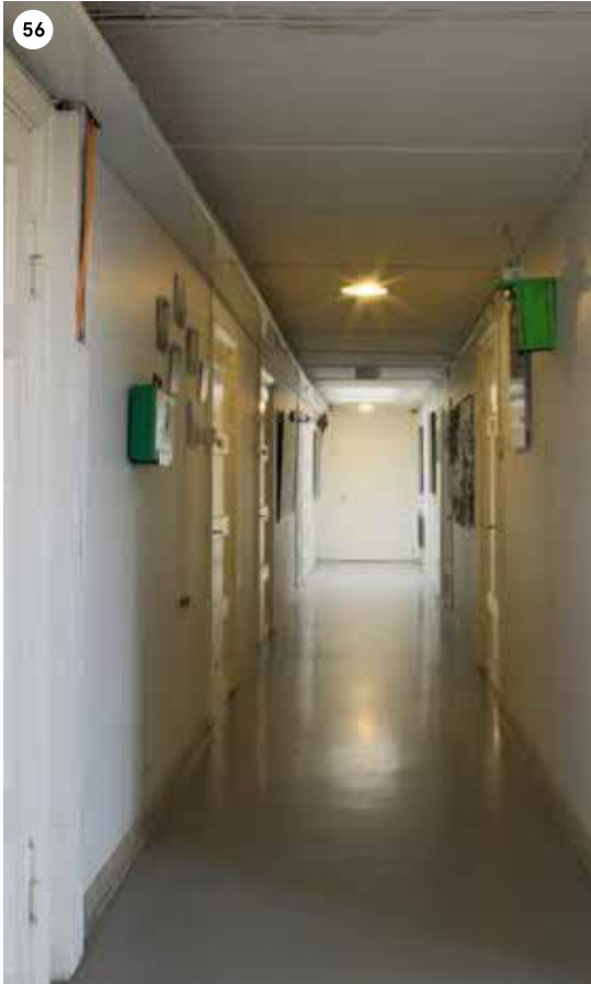
B-siiven kolmannen kerroksen käytävä on alempia kerroksia huomattavasti kapeampi ja huonekorkeudeltaan matalampi.
