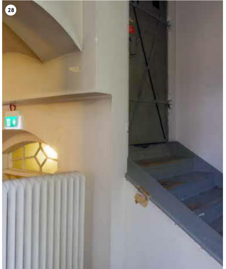
C-osan eteläpäässä sijaitsevan portaан ylätasanteelle lisättiin 1920-luvulla ripapatteri. Sen oikealla puolella on puuaskelmilla varustettu nousu ullakolle, joka on säilynyt pitkälti alkuperäisessä 1840-luvun asussa. Portaalle johtavassa ovesa on vanha metallinen palo-ovi, jossa on taottu kehysrakenne. Vastaavia ovilehtiä on mm. osan E ja Venetsia-rakennuksen ullakolle johtavassa oviaukossa.
