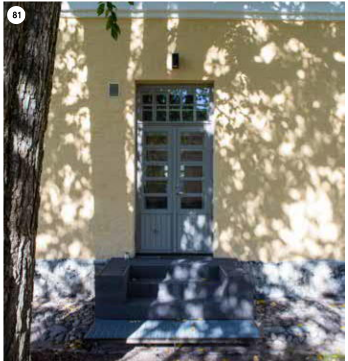
B-osan eteläjulkisivun sisäänkäynti. Oviaukko ei kuulunut alkuperäiseen suunnitteluratkaisuun, mutta avattiin 1920-luvun muutostöissä. Ovi-ohjelma on uusittu 1980-luvulla. Puinen porttas on rakennettu 2017, jolloin aiempi terassi purettiin.
