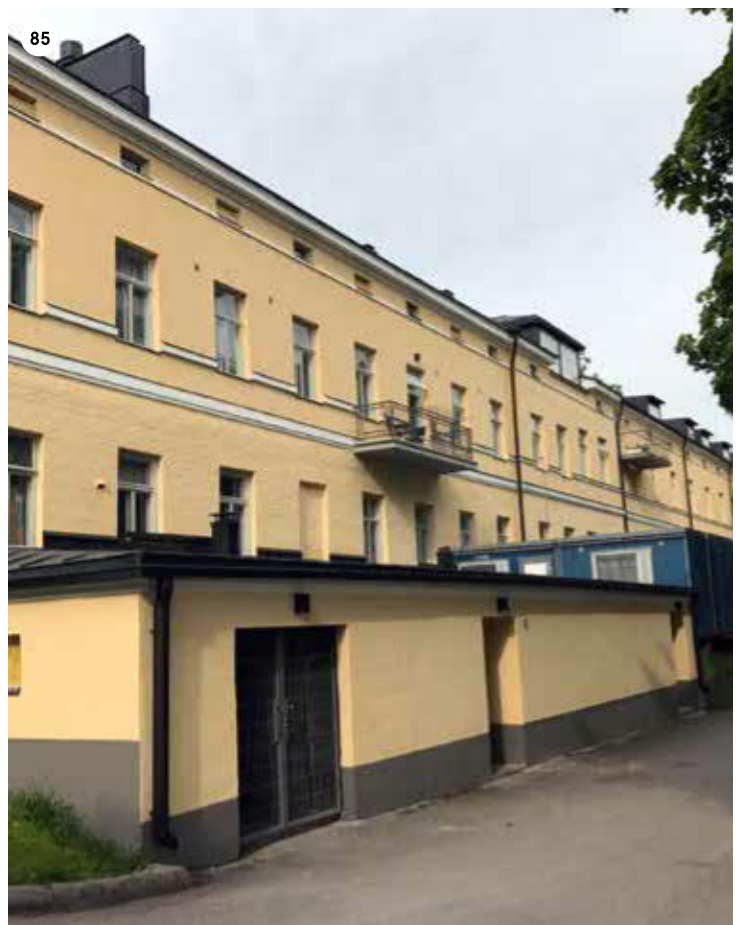
Sairaalan päärakennuksen koilliskulma. Etualalla keittiön huoltoa varten 1930-luvulla rakennettu lisäsiipi, jota laajennettiin 1990-luvulla. Parvekkeet on rakennettu 1900-luvun ensimmäisellä puoliskolla, kattolyhdyt 1900-luvun ensimmäisten kolmen vuosikymmenen aikana. HY.
