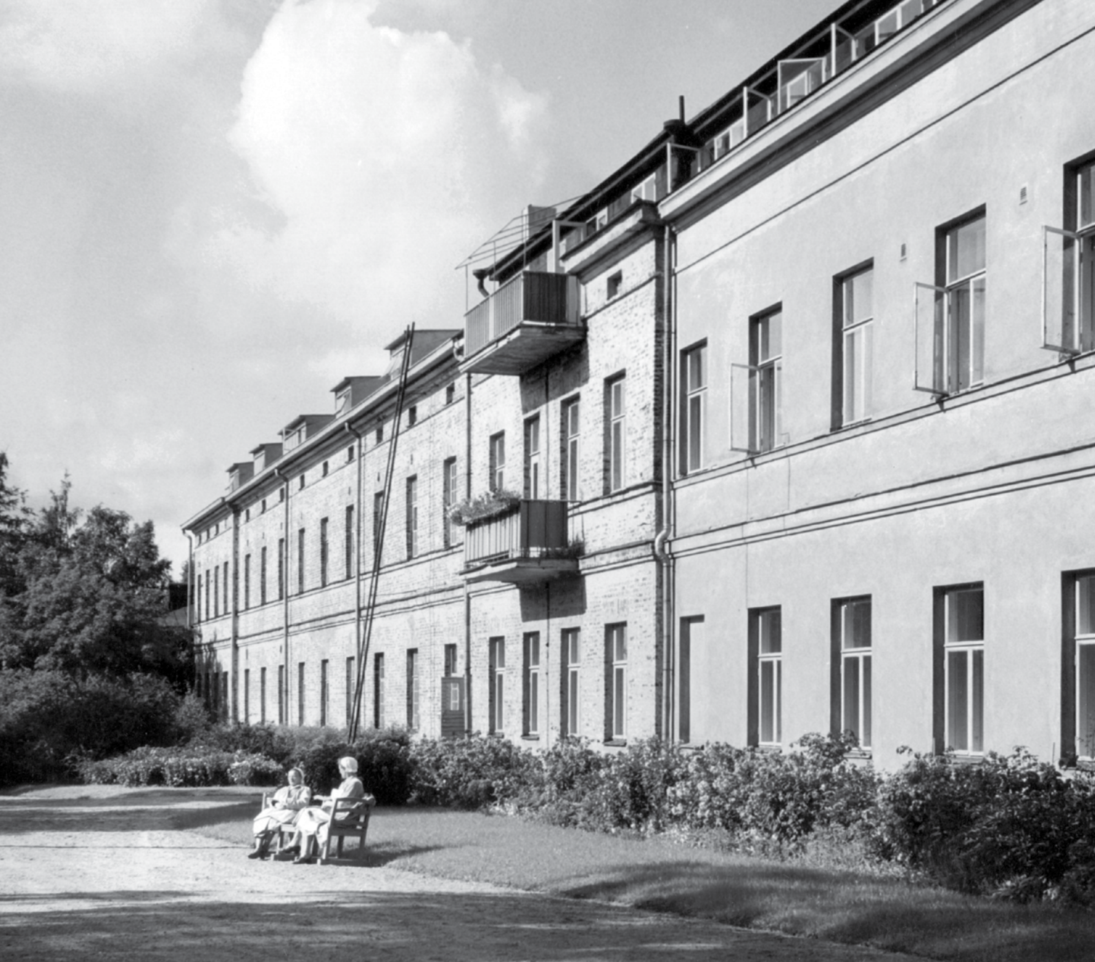
Potilas ja tämän hoitaja ulkoilemassa sairaalarakennuksen eteläpuolella 1950-luvulla. Toisin kuin nykyään, G-osan julkisivu on kuvassa kokonaan rapattu ja muut julkisivut on slammattu. Valokuvannut A. Salokorpi, Helsingin kaupunginmuseo.
