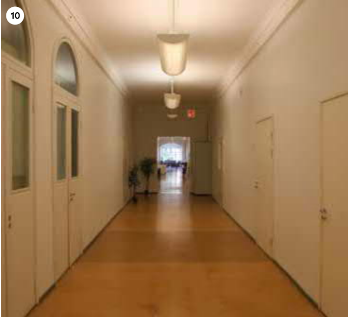
B-siiven ensimmäisen kerroksen käytävää jakaa alkuperäisellä paikalla sijaitseva oviaukko. Oviaukon itäpuolella sijaitsi alun perin käytävän varrella yhteensä neljä suurta päivä- ja ruokahuonetta, jotka on sittemmin jaettu pienemmiksi huoneiksi. 1900-luvun laakaovet on sijoitettu kaarisyvennyksen sijaan suoraan seinäpintaan ja oviaukot eivät muodosta säännönmukaista aukotusta käytäväseinään.
