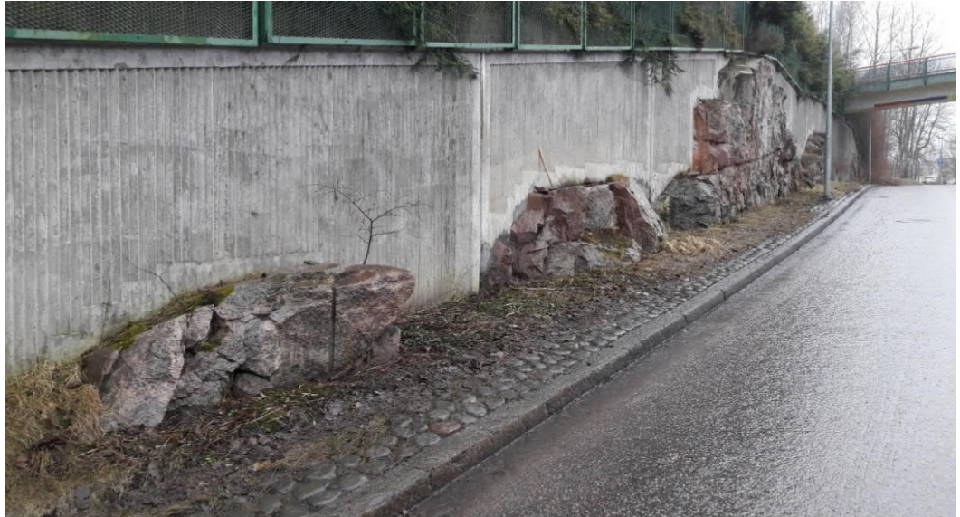
Kuva 4. Kallioleikkaukset betoniseinämässä Maaherrantien varressa Veräjämäellä (P = 6679825 m, I = 25498631 m).
