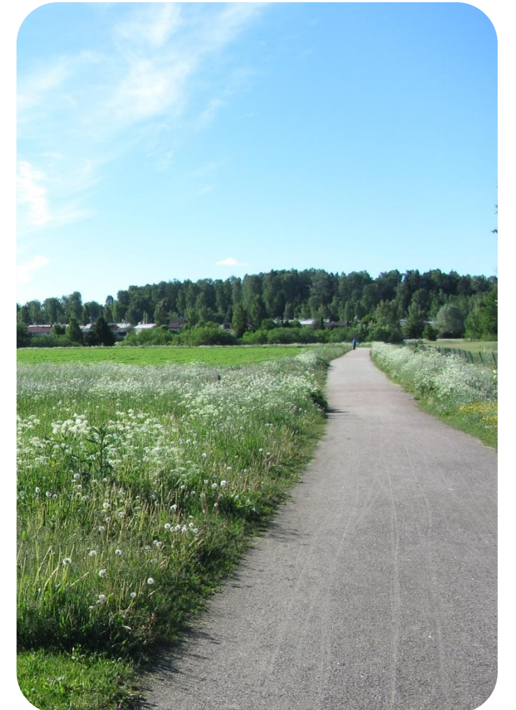
Kuva 4. Ulkoilureitti kohti Torpparinmäkeä.
